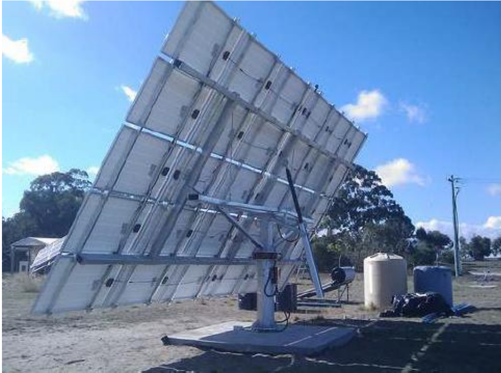
ΕΙΚΟΝΑ 30 : Κινητή βάση στήριξης των Πάνελ με στόχο την ιχνηλάτηση της πορείας του ήλιου
