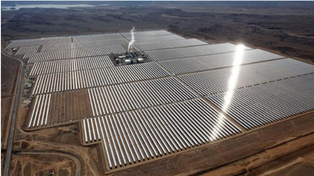
ΕΙΚΟΝΑ 62 : Φωτοβολταϊκό πάρκο στο Μαρόκο. Πηγή www.klik.gr
