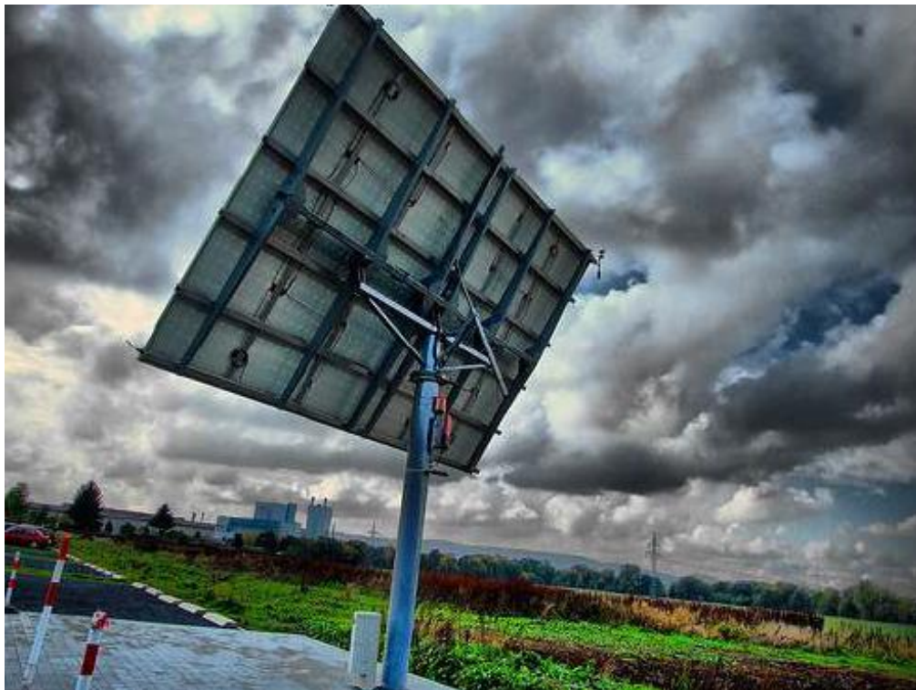
ΕΙΚΟΝΑ 31 : Κινητή βάση στήριξης των Πάνελ με στόχο την ιχνηλάτηση της πορείας του ήλιου
