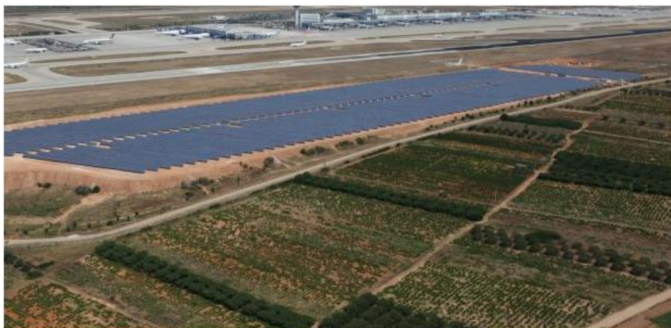
ΕΙΚΟΝΑ 61 : Φωτοβολταϊκό πάρκο στο αεροδρόμιο Ελ. Βενιζέλος στα Σπάτα. Πηγή www.energypress.gr
