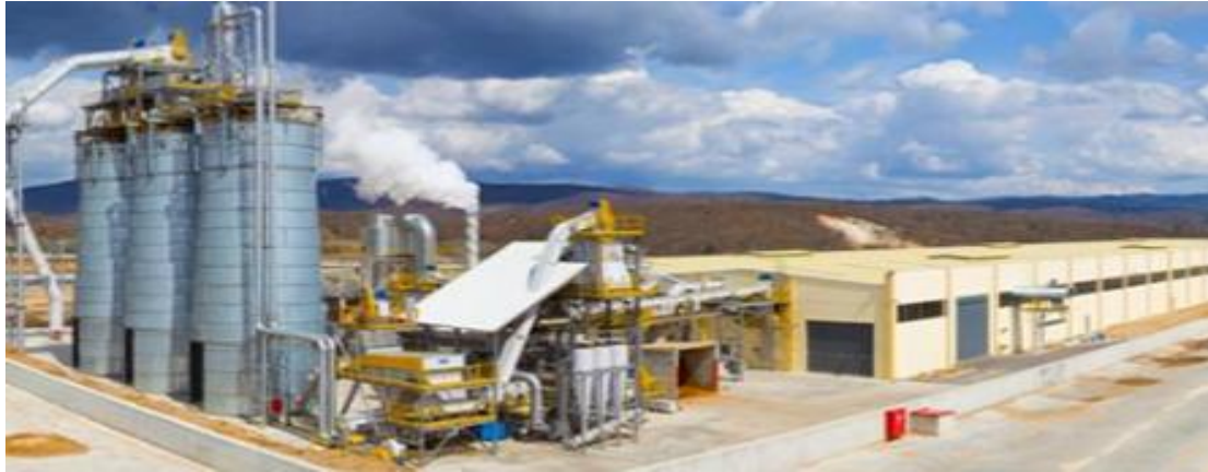
ΕΙΚΟΝΑ 10 : Εργοστάσιο παραγωγής pellet στο Νευροκόπι
