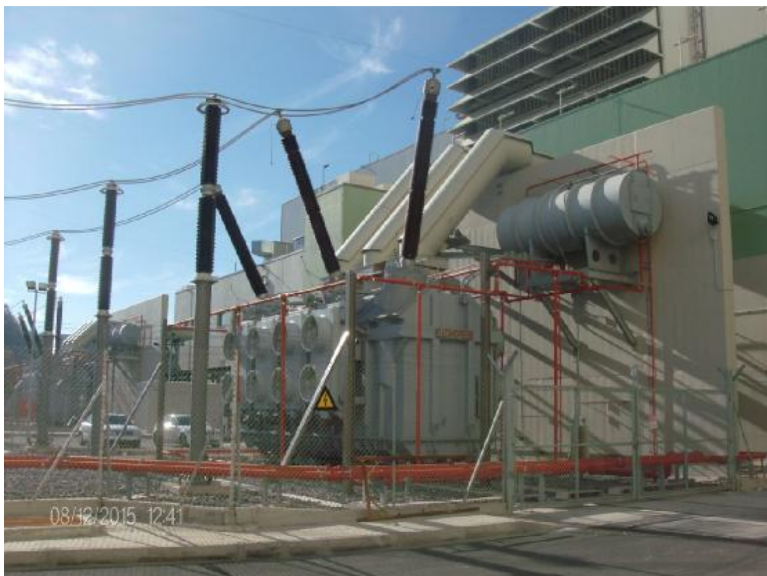
ΜΕΤΑΣΧΗΜΑΤΙΣΤΗΣ 17KV-400KV
