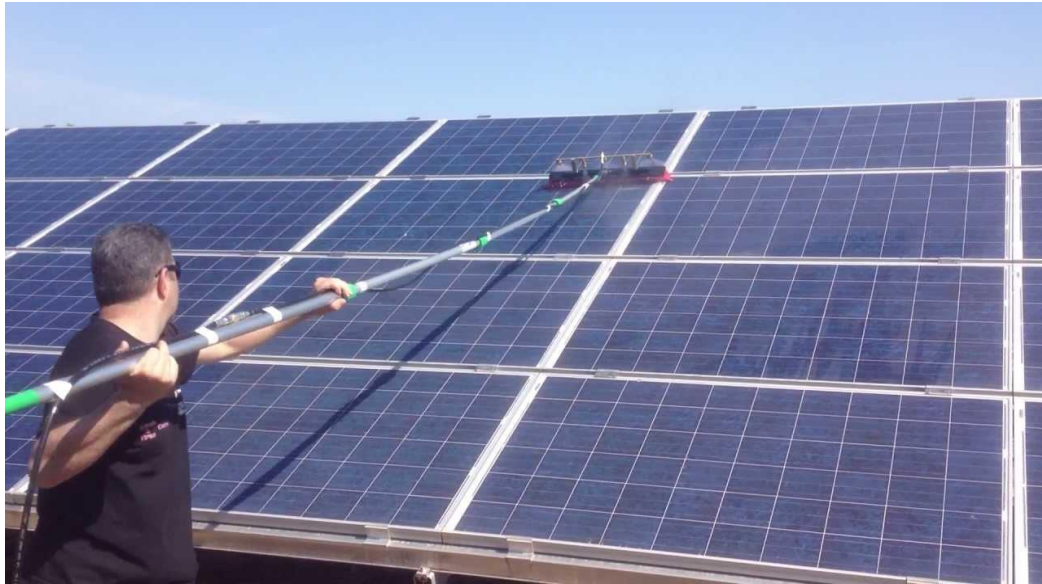
Εικόνα 49: Διαδικασία καθαρισμού ΦΒ πάνελ
