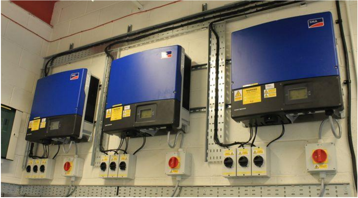
Εικόνα 41: Σειρά από inverters
