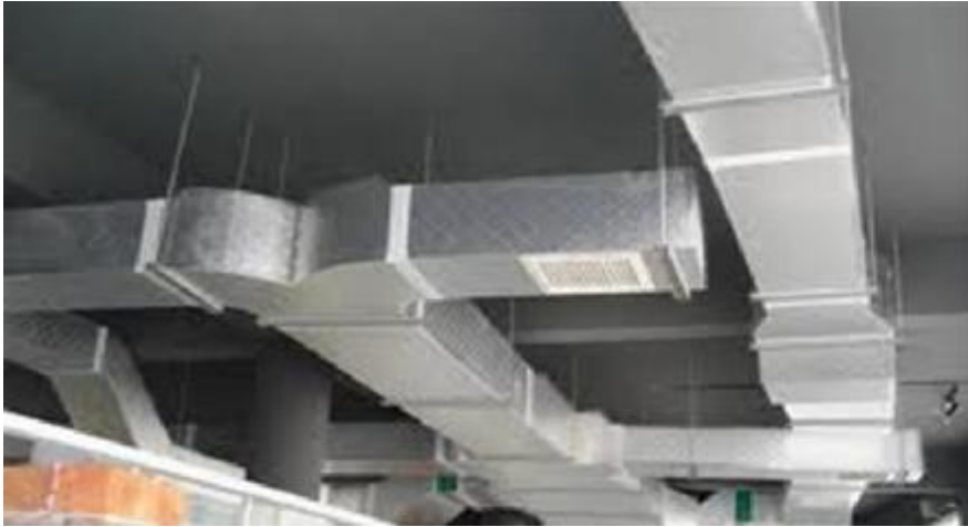
Εικόνα 6.3: Υπόδειγμα Δικτύων Αεραγωγών
