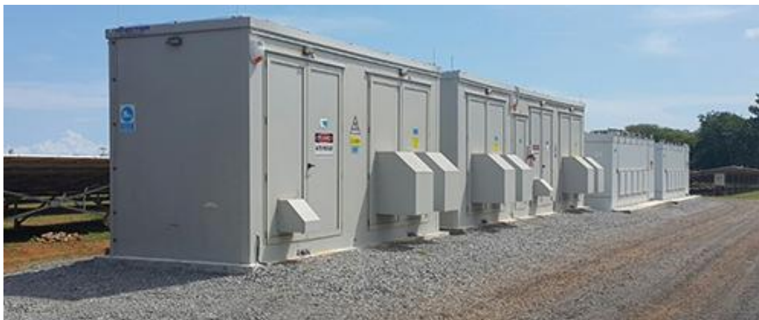
Εικόνα 6: Τυπικό κτίριο υποσταθμού
