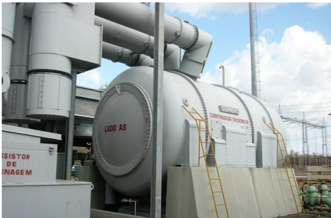
Εικόνα 3.3 :Στρεφόμενος πυκνωτής
