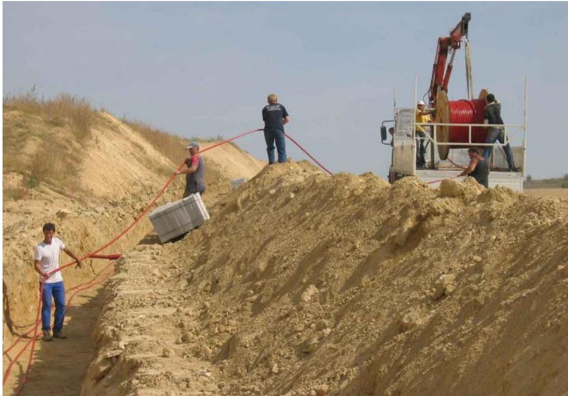
Εικόνα 35: Διαδικασία τοποθέτησης καλωδίων εντός του εδάφους
