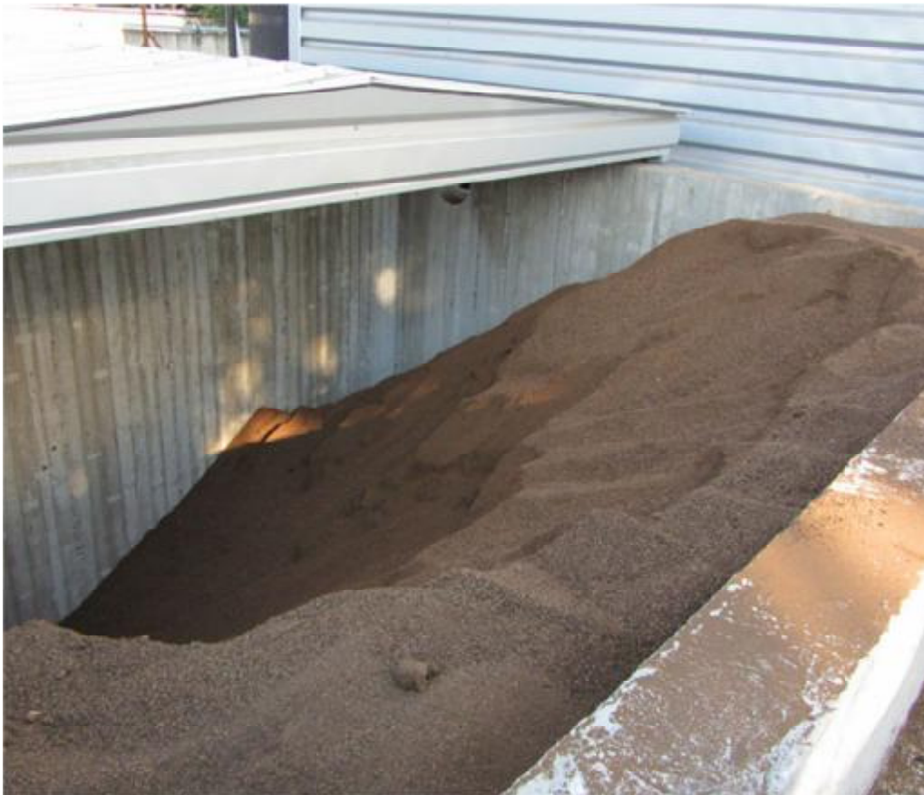
Εικόνα 4.2: Τμήμα αποθήκευσης βιομάζας
