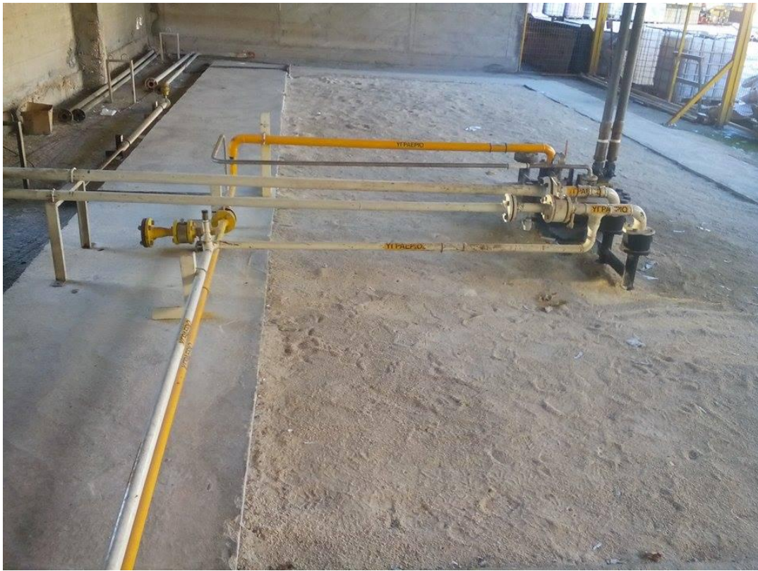
Εικόνα 2.17: Υπόγεια δεξαμενή αποθήκευσης καυσίμου(LPG)
