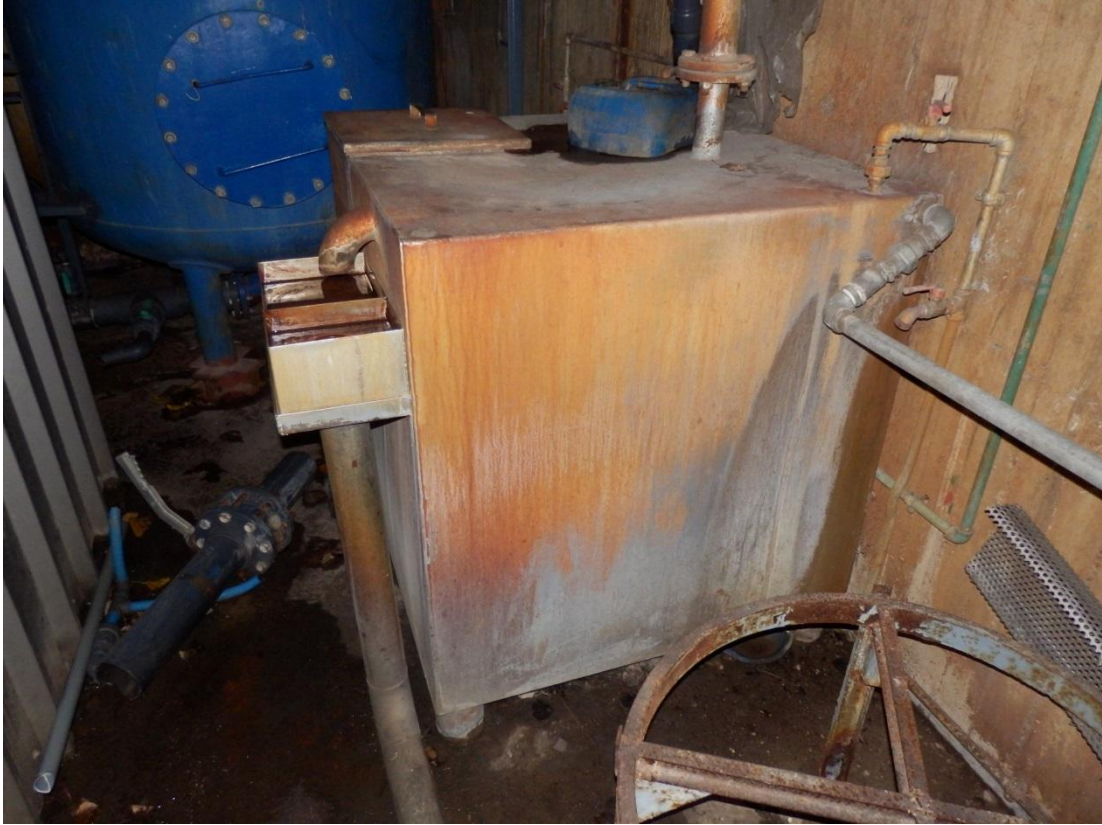
Εικόνα 2.15: Δεξαμενή αποθήκευσης κατεργασμένου νερού
