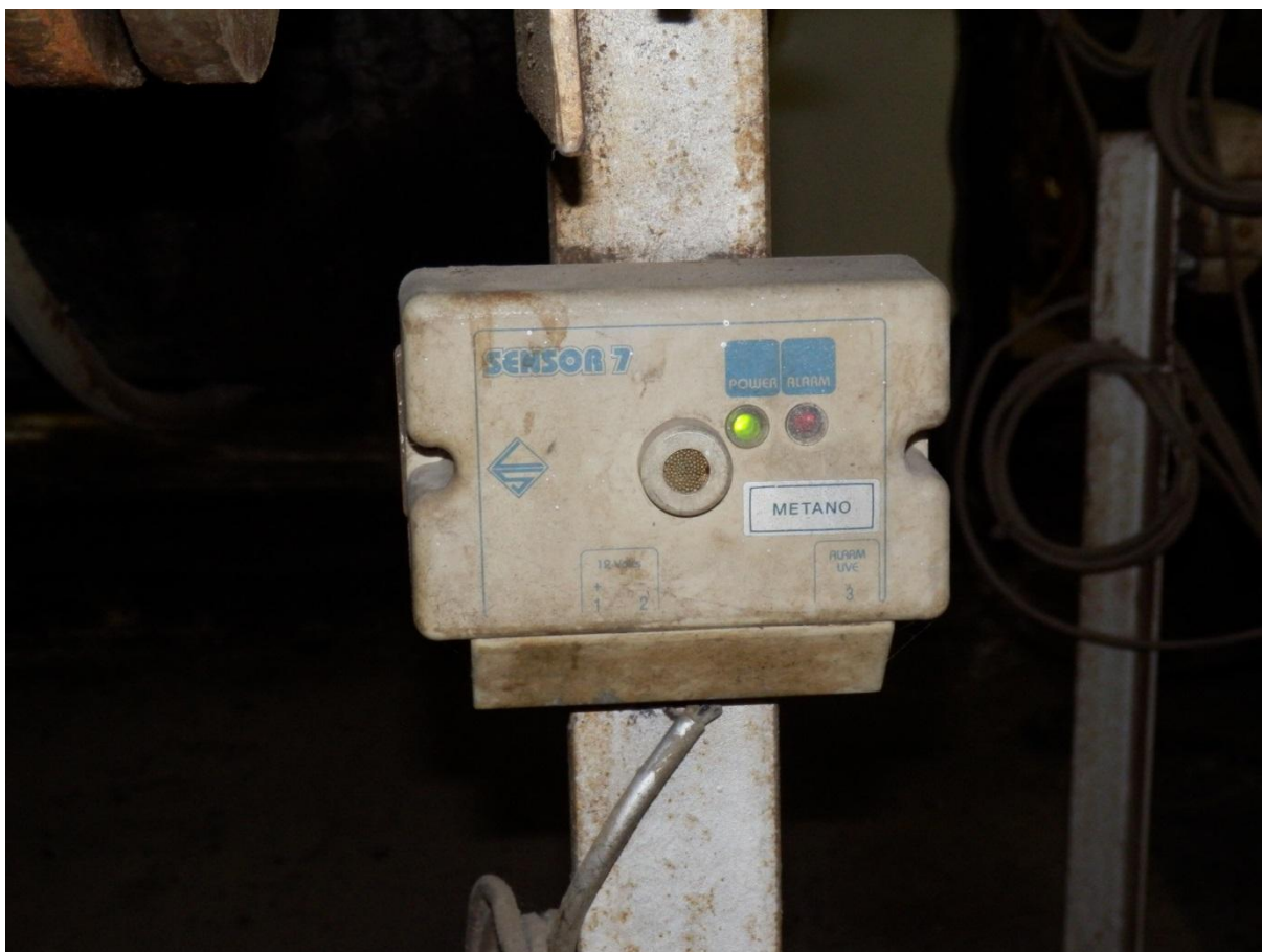
Εικόνα 2.13: Ελεγκτές διαρροών καυσίμου
