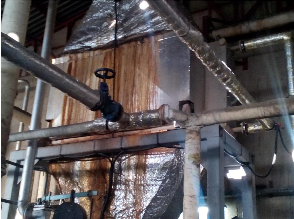
Εικόνα 2.9: Εναλλάκτης θερμότητας καπναερίων (economizer)
