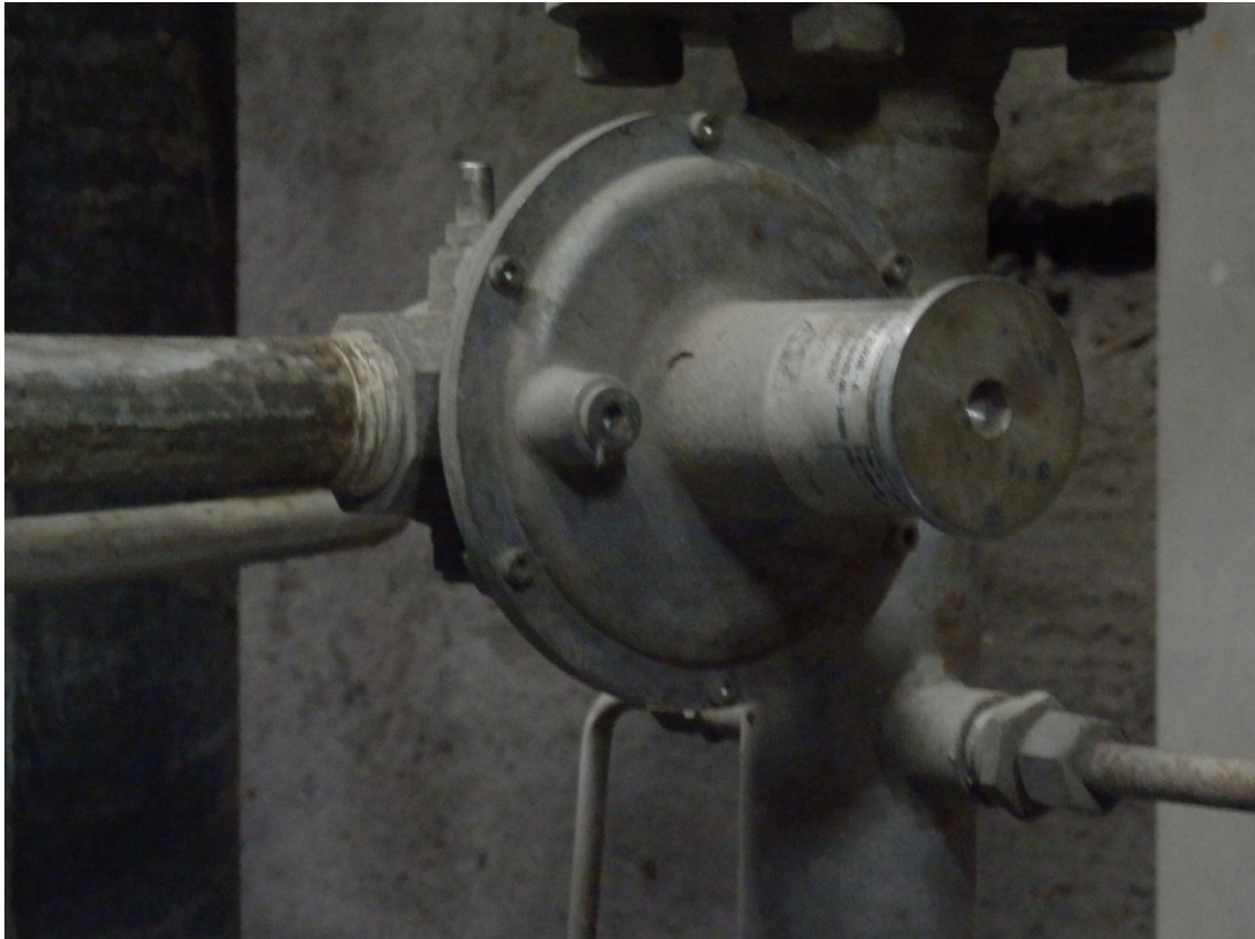
Εικόνα 2.19: Εξαεριστικό καυσίμου
