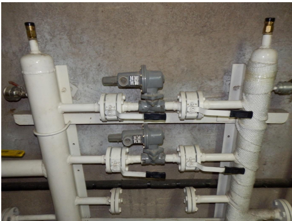
Εικόνα 2.12: Μειωτήρες πίεσης καυσίμου
