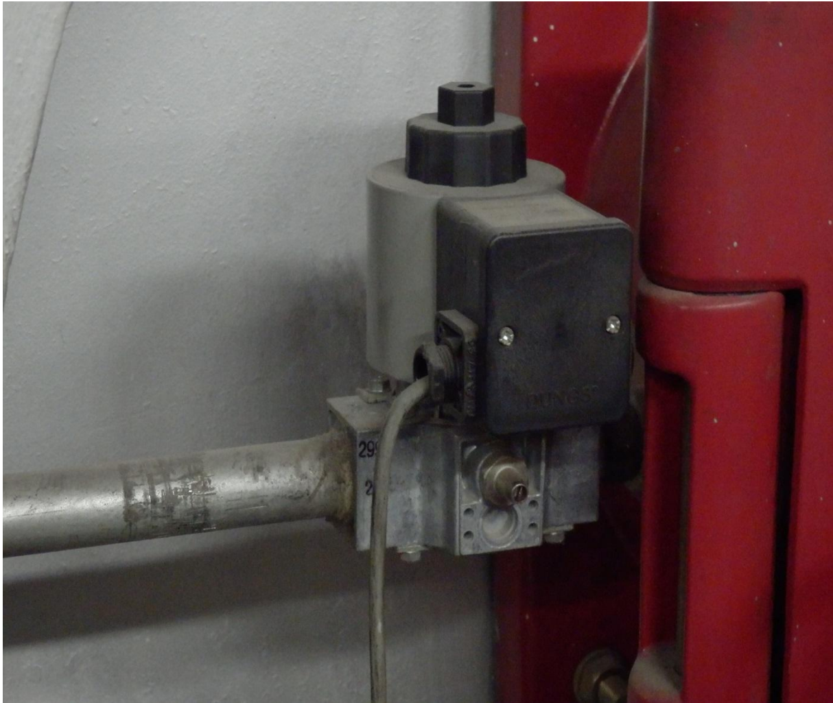
Εικόνα 2.14: Πρώτη βαλβίδα τροφοδοσίας καυσίμου (πιλότος)
