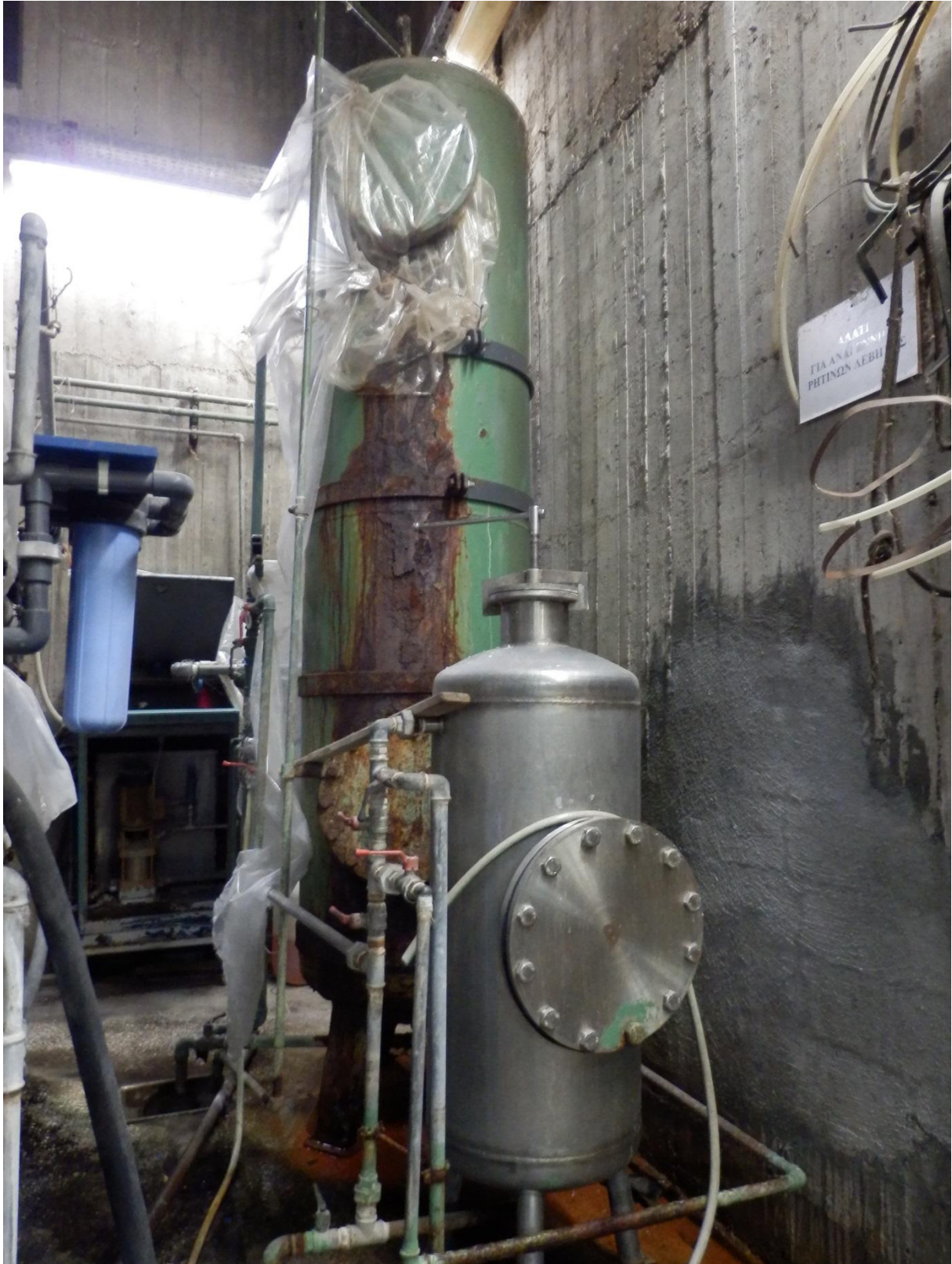
Εικόνα 2.21: Αποσκληρυντής νερού
