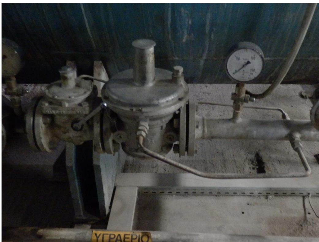
Εικόνα 2.22: Ελεγκτής ροής του καυσίμου
