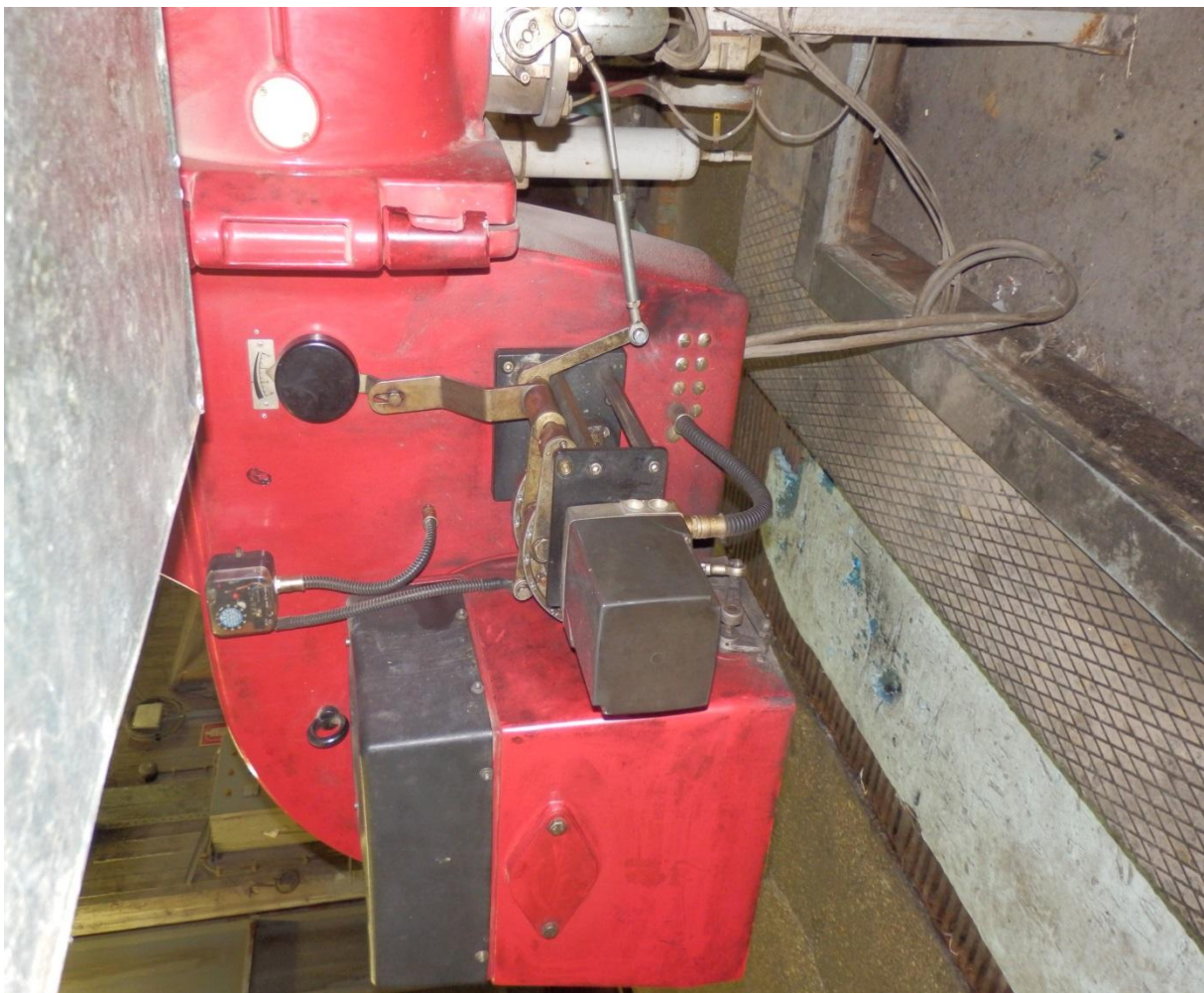
Εικόνα 2.5.: μηχανισμός ρύθμισης μίγματος αέρα-καυσίμου
