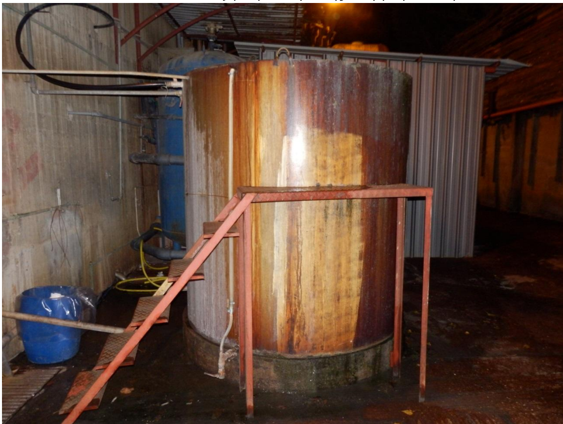
Εικόνα 2.15: Δεξαμενή αποθήκευσης κατεργασμένου νερού
