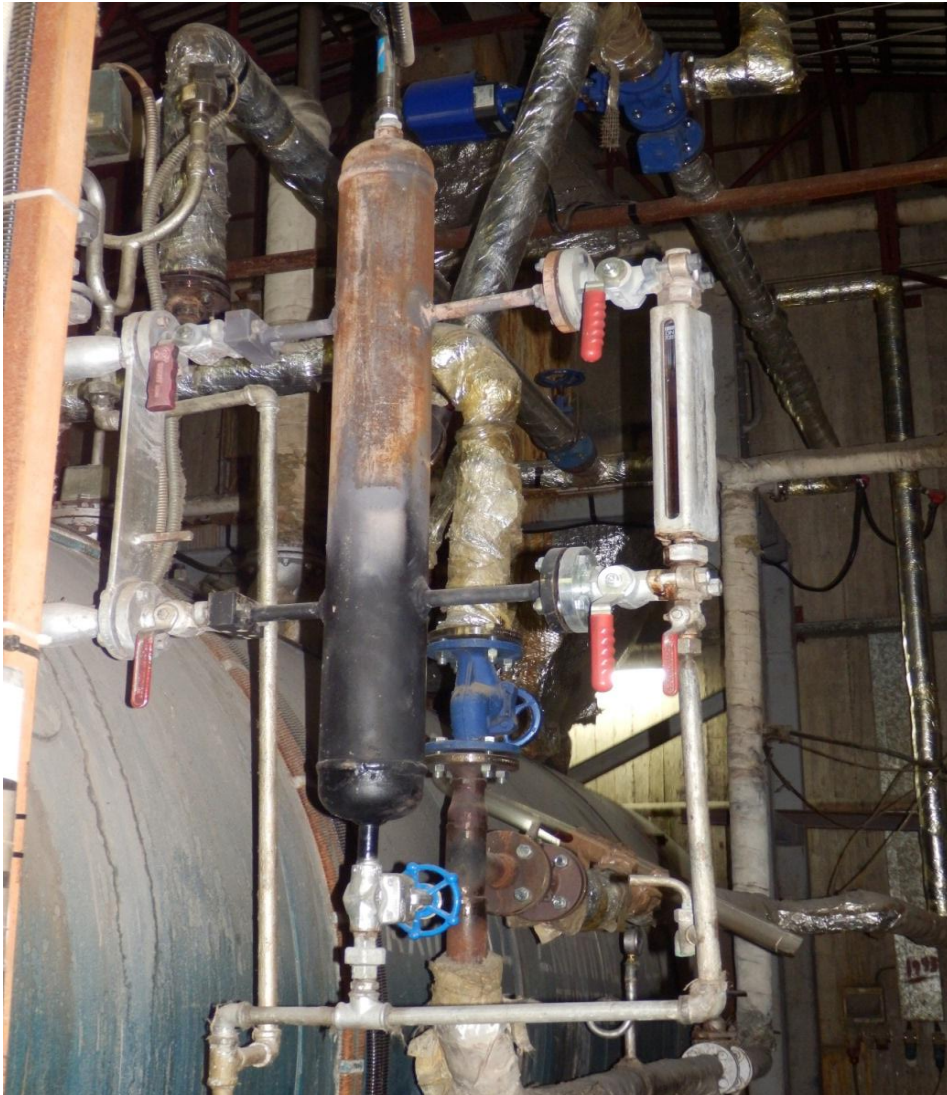
Εικόνα 2.7: συστήματα ελέγχου στάθμης νερού(ηλεκτρονικό και αναλογικό γυαλί)
