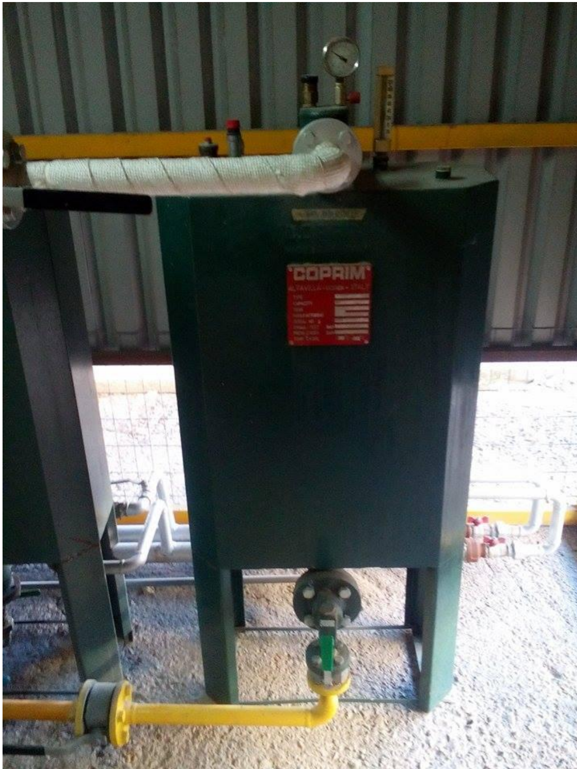
Εικόνα 2.10: Εξαερωτής καυσίμου
