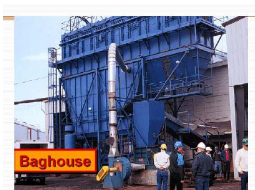
Εικόνα 66: Ολοκληρωμένο σύστημα καθαρισμού σακόφιλτρου σε διάταξη ροής αερίου αντίθετης ροής [7].
