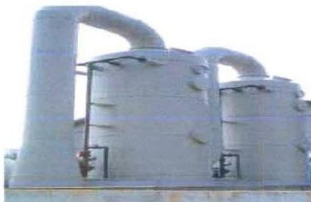
Εικόνα 30: Σύστημα αποκονίωσης με πύργους υγρής μεθόδου [7].
