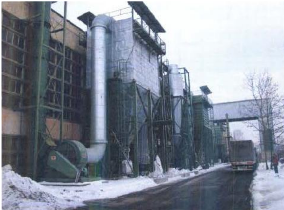
Εικόνα 22: Ολοκληρωμένο σύστημα αποκονίωσης εργοστασίου [7].
