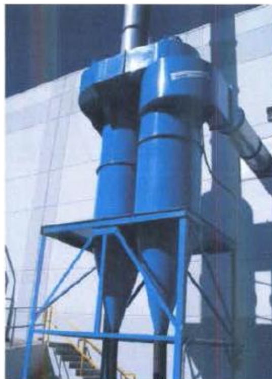
Εικόνα 28: Απεικόνιση τυπικού κυκλώνα κατακράτησης σωματιδιακής ύλης και πολυκυκλώνα [6,7].
