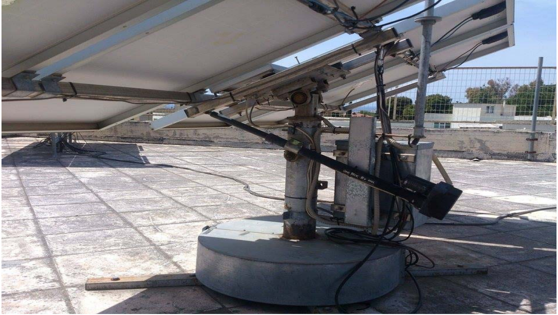
Εικόνα 2.29: Διαξονική κινητή βάση παρακολούθησης του ηλιακού δίσκου, εργαστήριο ΑΠΕ, ΤΕΙ Δυτικής Ελλάδας
