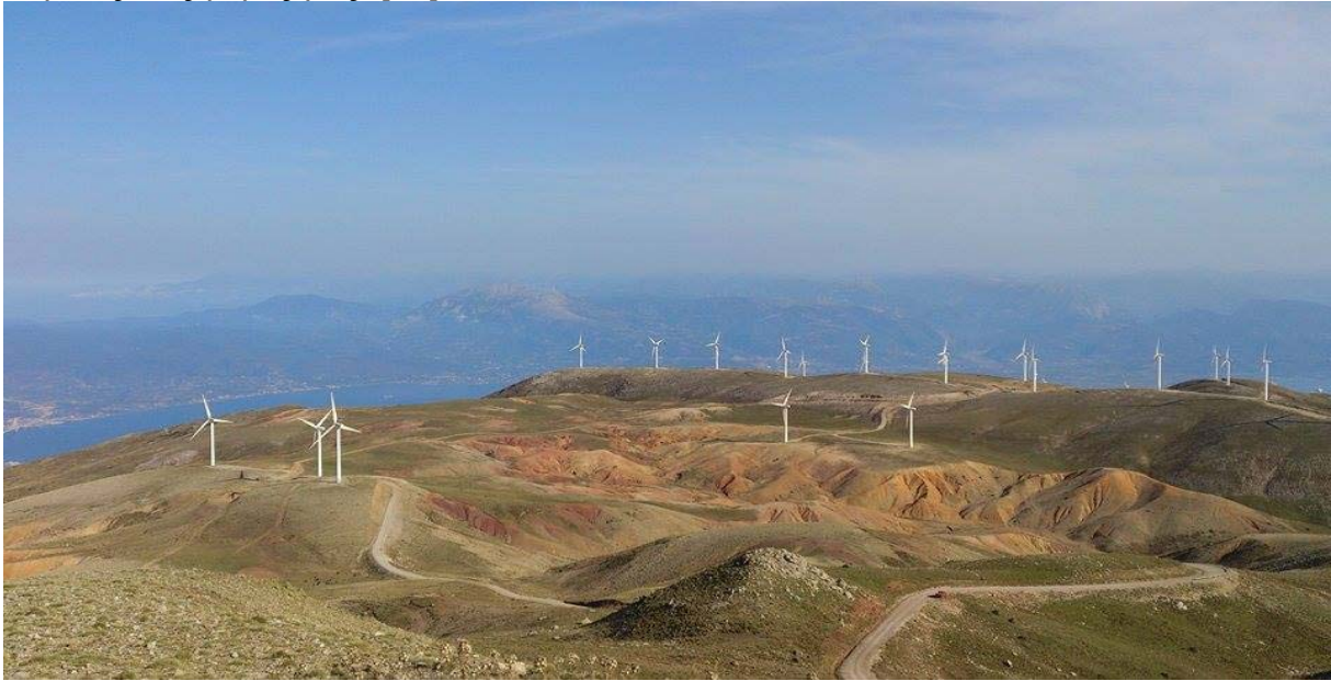
Εικόνα Ε7: Φωτογραφία εγκατάστασης ανεμογεννητριών για παραγωγή ηλεκτρικής ενέργειας στο Παναχαϊκό όρος(οριζόντιου άξονα τύπου Vestas 800KW/έκαστη).
