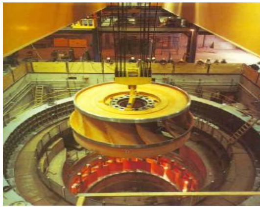
Εικόνα 50 α) Τοποθέτηση δρομέα β) Κατασκευή τμημάτων Υδροστροβίλου Francis [πηγή: Steam Turbine Impulse and Reaction]
