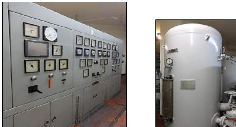
Εικόνα 81 Ταμπλό ρυθμιστή στροφών αριστερά, θάλαμος ελαίου ψύξης δεξιά. .[πηγή: ΔΕΗ Α.Ε]
