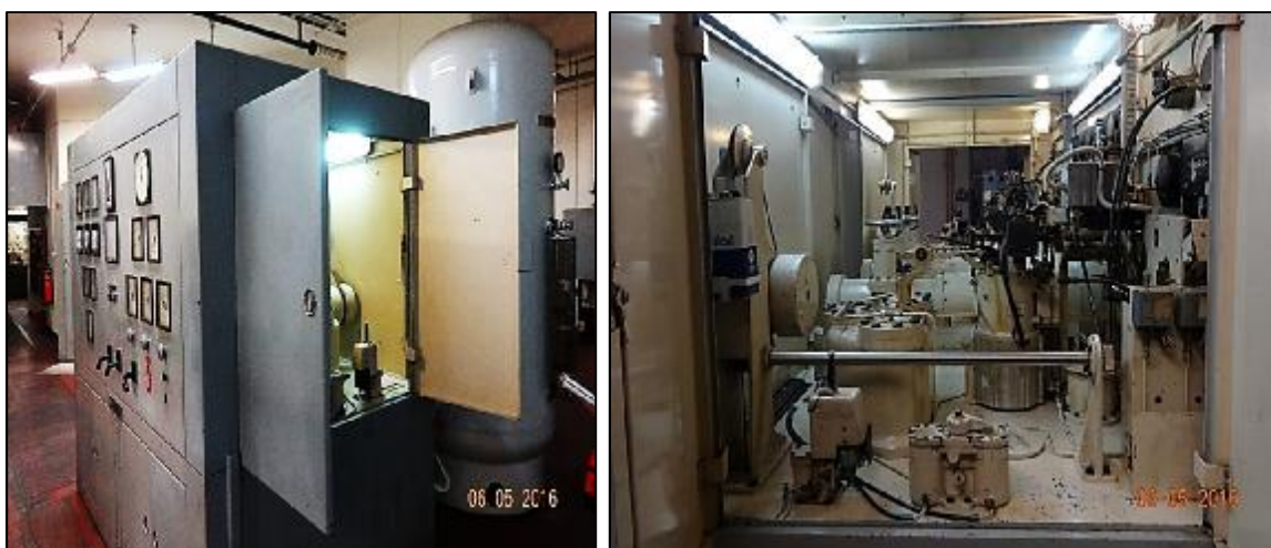
Εικόνα 80 Ρυθμιστής στροφών, εξωτερικά οι ενδείξεις, εσωτερικά ο μηχανισμός.[πηγή: ΔΕΗ Α.Ε]
