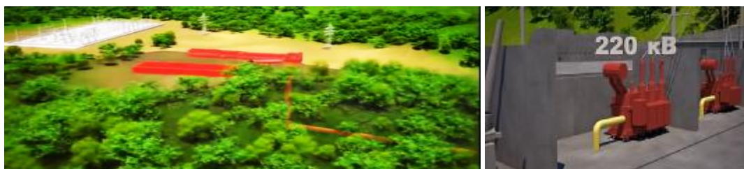
Εικόνα 113. πορεία ρεύματος παραγωγής από τους μετασχηματιστές στον χώρο του ΥΗΣ στον ανυψωτή τάσης και στον υποσταθμό [πηγή: Voith Hydro, youtube.com/watch?v=pNx76qvT9EU]
