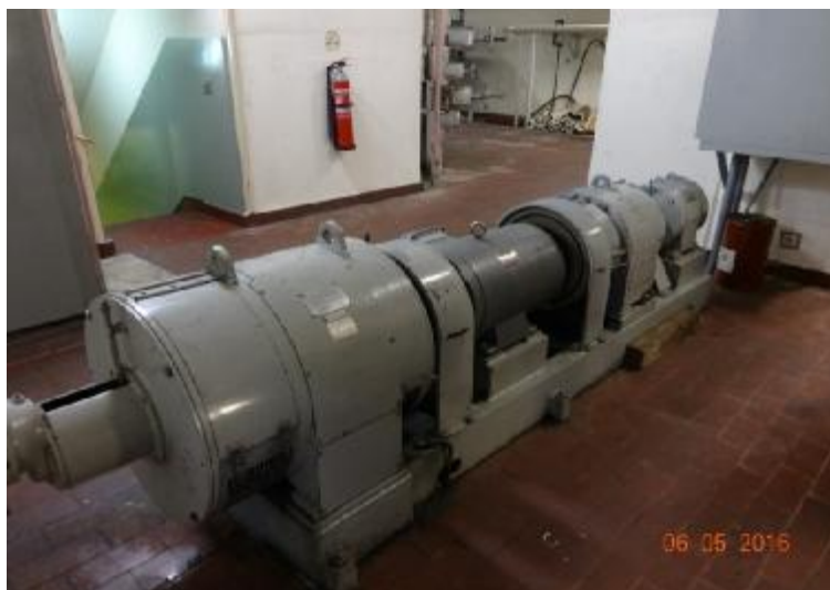
Εικόνα 109. Αυτόματος ρυθμιστής τάσης μονάδας. [πηγή: ΔΕΗ Α.Ε]
