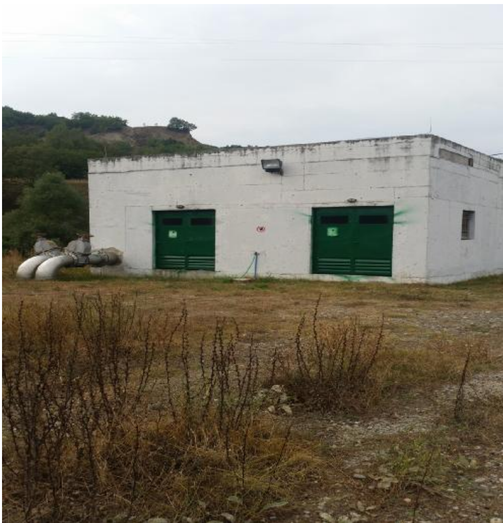
Εικ. 1.3 : Αντλιοστάσιο κεντρικής ανύψωσης
