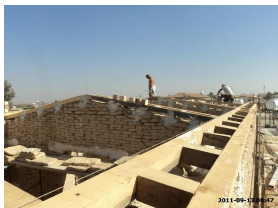
Εικ.24 τοποθέτηση ξύλινου σενάζ για την περίδεση του κτηρίου.
