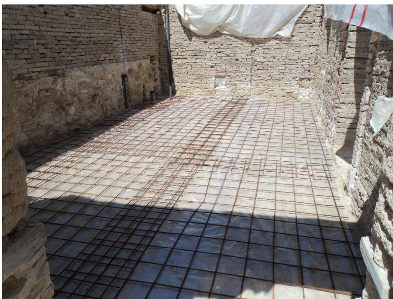
Εικ.22 σιδεροσύνδεση πριν την στρώση του πατώματος από μπετόν
