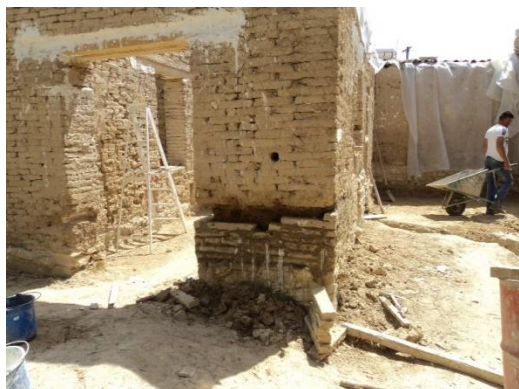
Εικ.23 επιδιόρθωση και ενίσχυση τοίχου από πλίνθρα οι οποία έχει διαβρωθεί.
