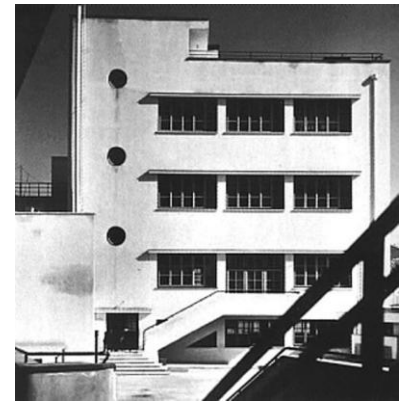
Εικόνα 46: Μεσοπολεμικό σχολικό κτήριο στην Οδό Λιοσίων, Αθήνα
