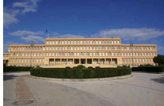
Εικόνα 61: Το Αρσακείο σχολικό κτήριο στο Ψυχικό
