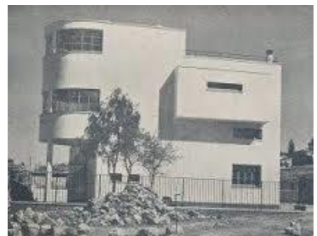
Εικόνα 72: Σχολικό κτήριο Γούβας
