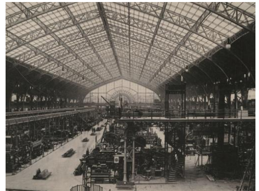
Εικόνα 37: Galerie des Machines, Παρίσι, 1889
