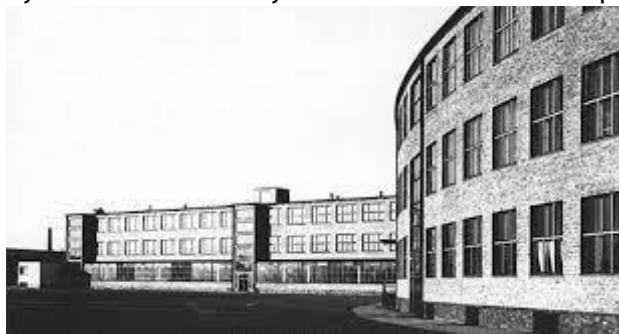
Εικόνα 64: Σχολικό κτήριο του Max Taut, περ.1927
