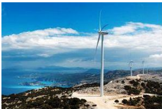
9. Αιολικό πάρκο στον Αίνο
