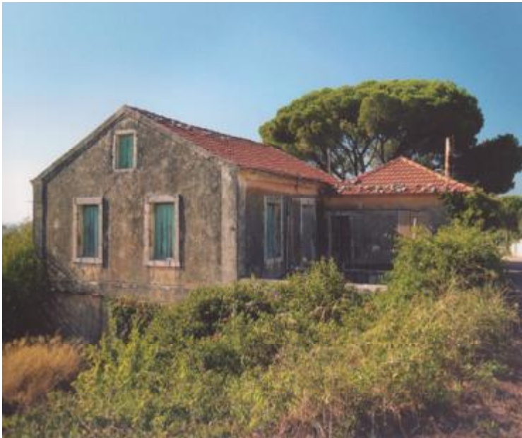
46. Δίριχτη στέγη με ατσούπι και το φώτολο, Ερισσός
