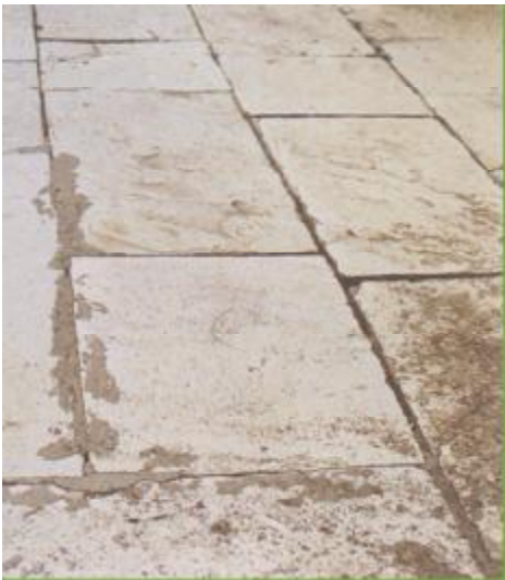
39. Δάπεδο ισογείου από ορθογώνιες πέτρινες πλάκες.
