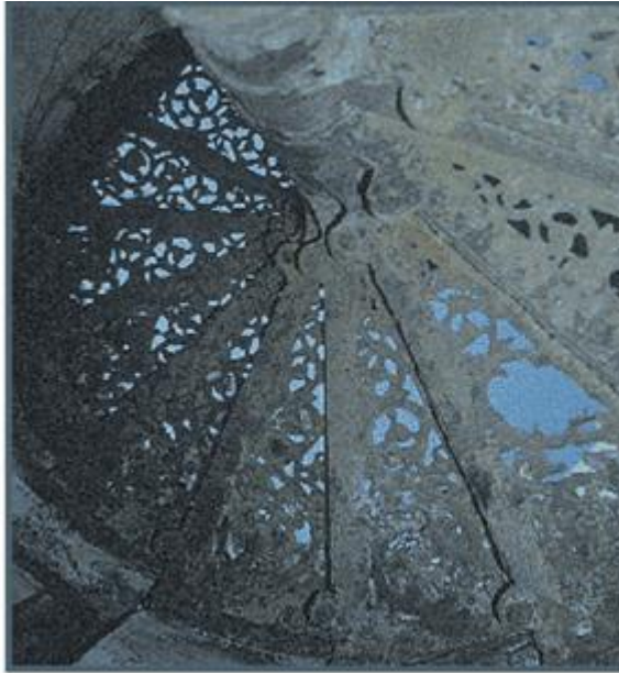
Εικόνα 15. Εξαιρετικής τέχνης κλιμακοστάσιο σε εγκαταλειμμένο φάρο
