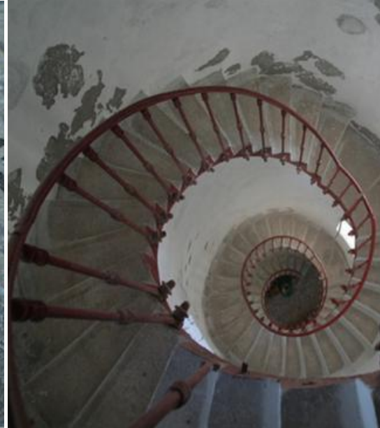
Εικόνα 16. Κλιμακοστάσιο Φάρου Ψαθούρας
