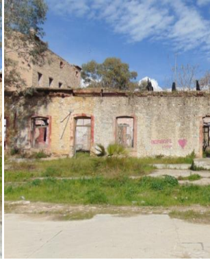
Φ.137 Άποψη Νότιας όψης
