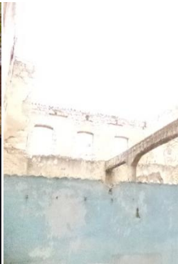
Φ.125 Γενική άποψη χώρου A3 από χώρο A3.1
