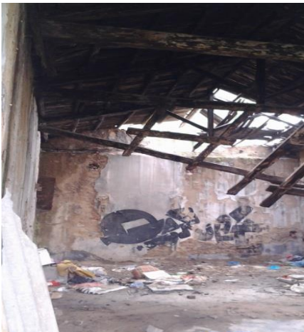
Φ.162 Άποψη Νότιας όψης εσωτερικά του Θ κτηρίου
