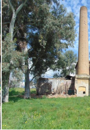
Φ.166 Άποψη Βόρειας όψης Ι κτηρίου
