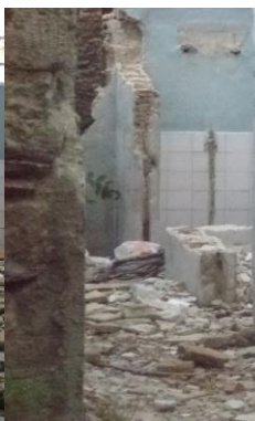
Φ.127 Άποψη χώρου A3.1
