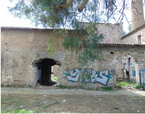
Φ.145 Άποψη Βόρειας όψης κτηρίου Δ
