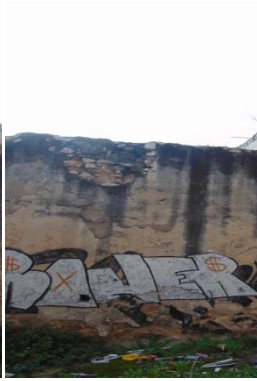
Φ.120 Άποψη Νότιου τοίχου στο χώρο A4
