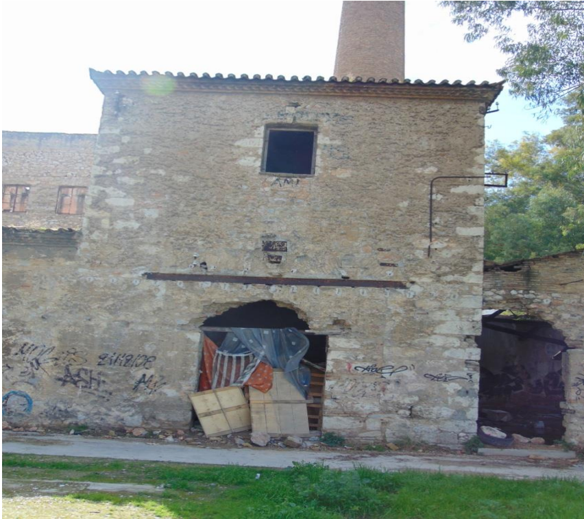
Φ.159 Άποψη Βόρειας όψης Η κτηρίου και λεπτομέρεια θύρας (Θ102)
