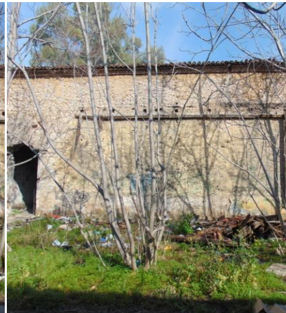
Φ.149 Πλάγια λήψη Βόρειας όψης κτηρίου Δ από το αίθριο, Υ
