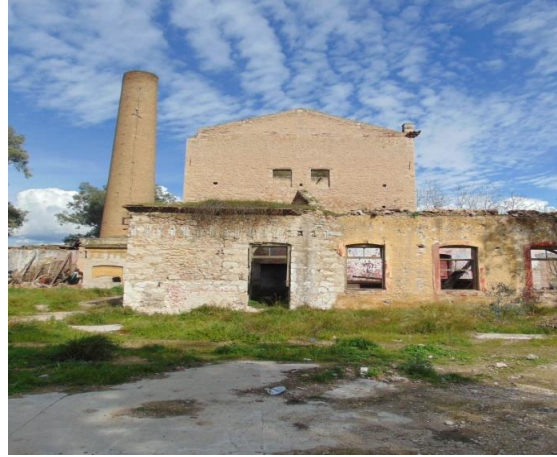
Φ.155 Άποψη Νότιας όψης Z κτηρίου
