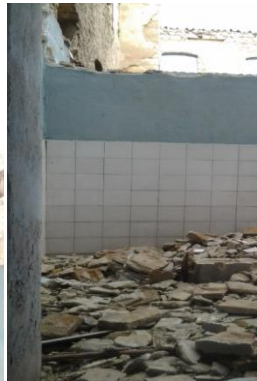
Φ.126 Άποψη χώρου A3.1
