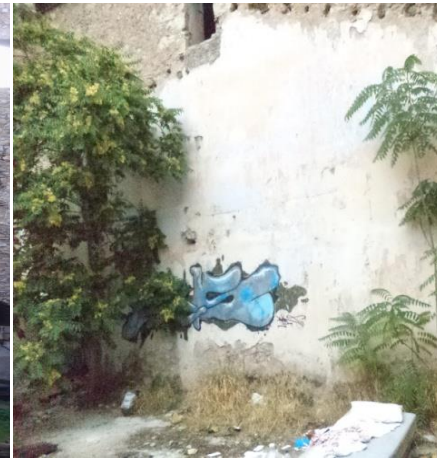
Φ.153 Πλάγια λήψη Δυτικού τοίχου στο εσωτερικό του κτηρίου Ε
