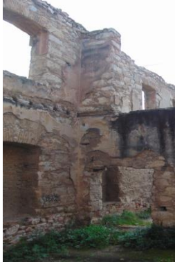
Φ.119 Άποψη Νότιου τοίχου στο χώρο A4, λεπτομέρεια θύρας (Θ125)
