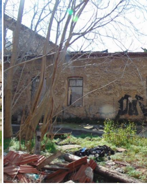
Φ.138 Άποψη Νότιας όψης κτηρίου Γ από το αίθριο, Υ
