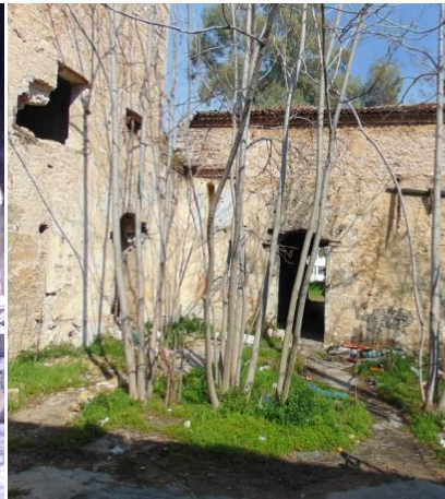
Φ.148 Πλάγια λήψη Βόρειας όψης κτηρίου Δ από το αίθριο, Υ
