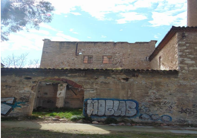
Φ.150 Άποψη Βόρειας όψης κτηρίου Ε και λεπτομέρεια θύρας (Θ115)
