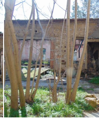
Φ.139 Άποψη Νότιας όψης κτηρίου Γ από το αίθριο, Υ
