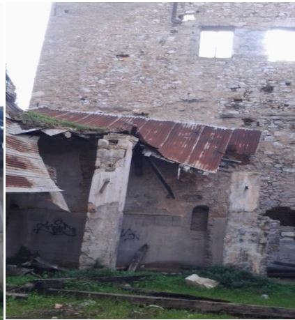
Φ.152 Πλάγια λήψη Νότιου τοίχου στο εσωτερικό του κτηρίου Ε
