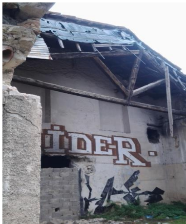
Φ.151 Πλάγια λήψη Ανατολικού τοίχου στο εσωτερικό του κτηρίου Ε
