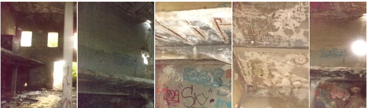
Φ.131 Άποψη Δυτικού τοίχου στο εσωτερικό του κτηρίου Β
