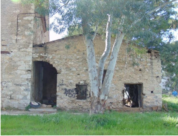
Φ.160 Άποψη Βόρειας όψης Θ κτηρίου
