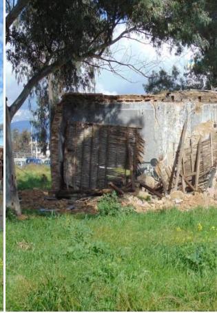
Φ.167 Άποψη Βόρειας όψης Ι κτηρίου
