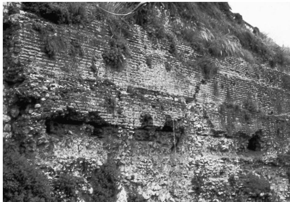
Εικόνα 01: Αναλημματικός τοίχος Ψηλά Αλώνια
