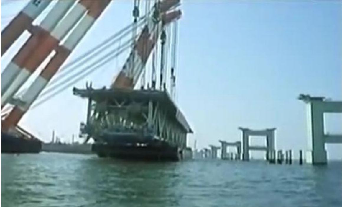
ΕΙΚΟΝΑ 6.ΤΟΠΟΘΕΤΗΣΗ ΚΑΤΑΣΤΡΩΜΑΤΟΣ
