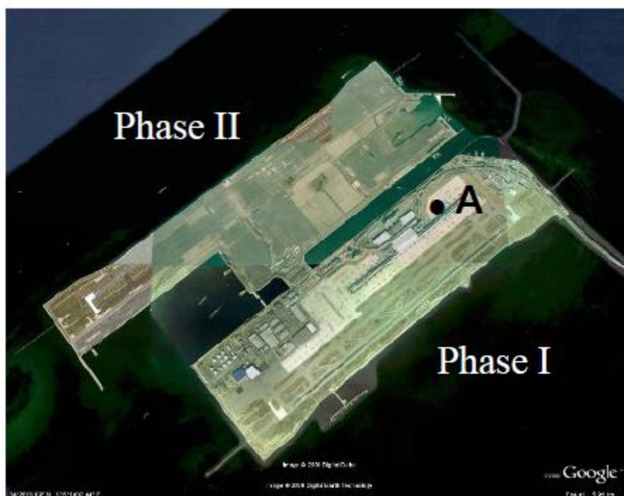
ΕΙΚΟΝΑ 27. ΦΑΣΕΙΣ ΚΑΤΑΣΚΕΥΗΣ ΤΟΥ ΑΕΡΟΔΡΟΜΙΟΥ
