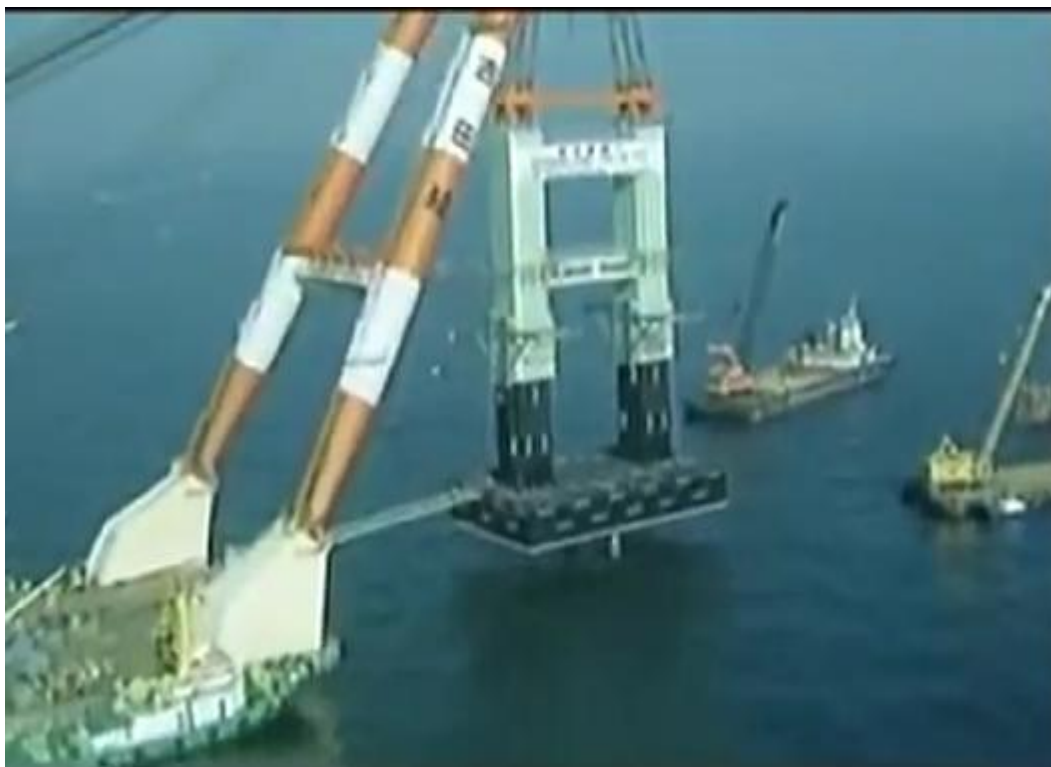
ΕΙΚΟΝΑ 5.ΤΟΠΟΘΕΤΗΣΗ ΒΑΘΡΩΝ
