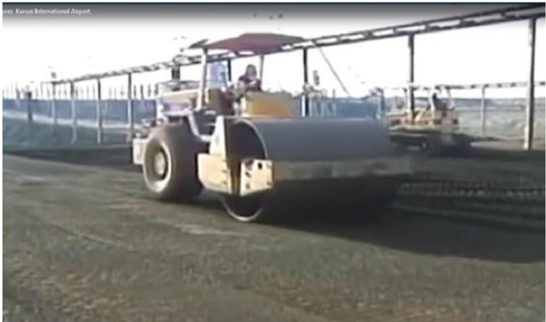
ΕΙΚΟΝΑ 21. ΟΔΟΣΤΡΩΤΗΡΑΣ ΓΙΑ ΤΗ ΣΥΜΠΥΚΝΩΣΗ ΤΟΥ ΕΔΑΦΟΥΣ
