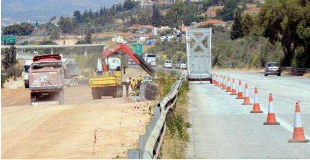
Εικόνα 24: Εργοτάξιο στο υπό κατασκευή έργο
