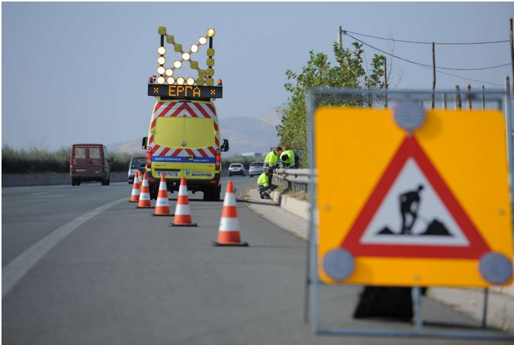
Εικόνα 9: Χρήση κώνων καθοδήγησης και εργαζόμενοι με ανακλαστικά γιλέκα εργασίας
