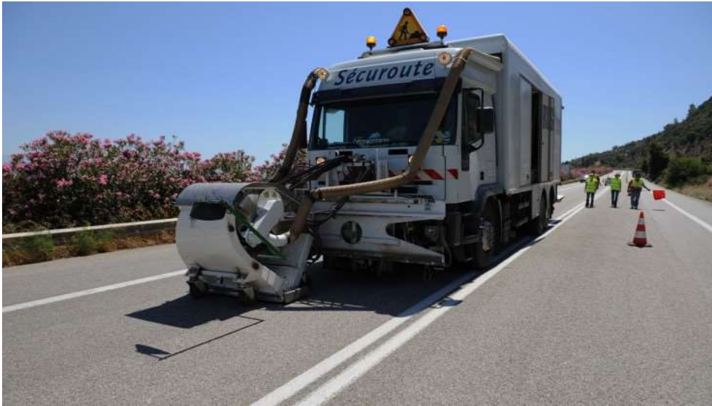
Εικόνα 25: Μέθοδος shotblasting για βελτίωση αντιολισθηρότητας οδοστρώματος
