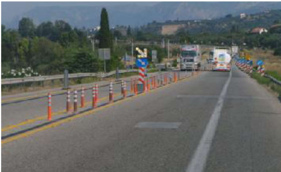
Εικόνα 36: Τοποθέτηση πινακίδας P- 52δ+Π-79 μαζί με φωτεινό αναλάμπον βέλος
