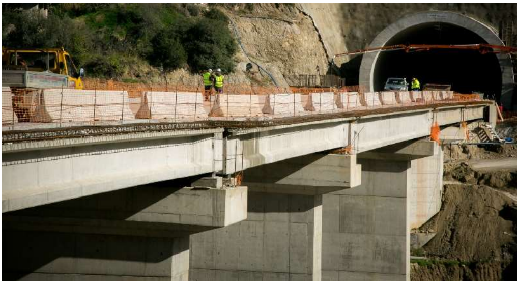
Εικόνα 10: Γέφυρα στο κόμβο του Ρίο (υπό κατασκευή).
