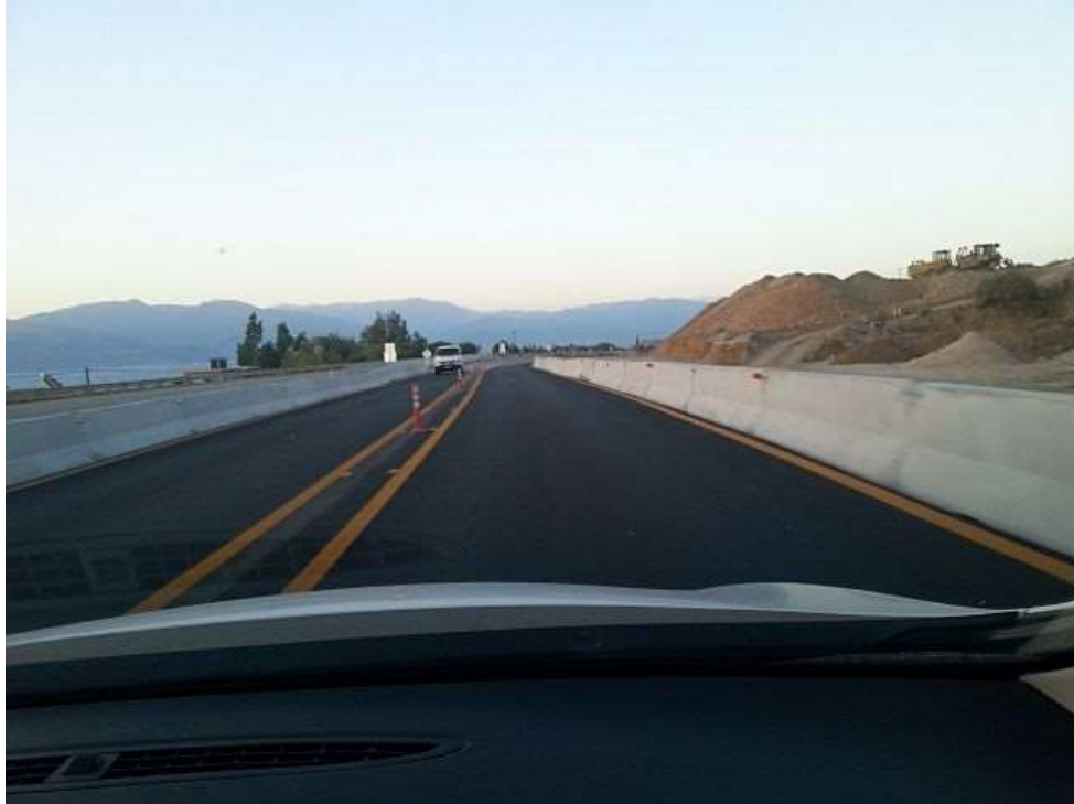
Εικόνα 1: Σχεδόν σε όλο το τμήμα από Κόρινθο μέχρι Πάτρα τα εργοτάξια δουλεύουν παράλληλα με τον οδικό άξονα που λειτουργεί κανονικά, έστω και αν δυσκολεύει αρκετά τους οδηγούς.
