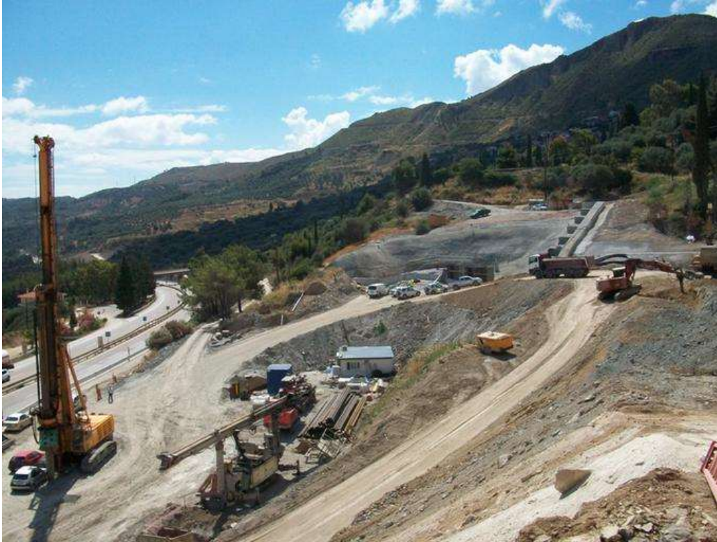
Εικόνα 3: Δυτική όψη σηραγγών Πλατάνου – Έξοδος
