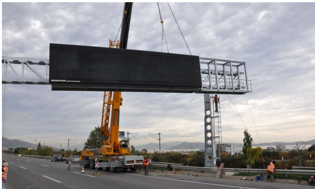
Εικόνα 26: Εγκατάσταση γέφυρας σήμανσης μεταβλητών μηνυμάτων
