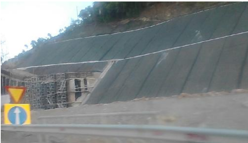
Εικόνα 69.Κάλυψη διαμορφωμένων πρανών με πλέγμα. (κ)
