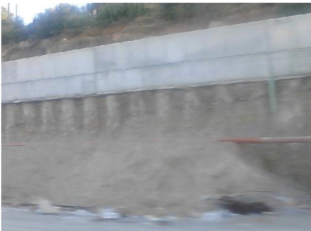
Εικόνα 84.Στήριξη πρανών με φρεατοπάσσαλους. (λ)
