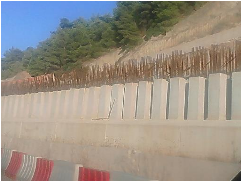
Εικόνα 82.Στήριξη πρανών με φρεατοπάσσαλους. (ι)
