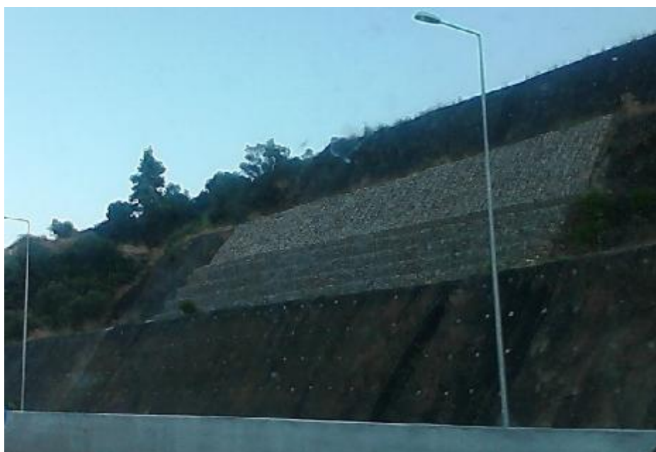
Εικόνα 73.Στήριξη πρανών με συρματοκυβώτια. (δ)
