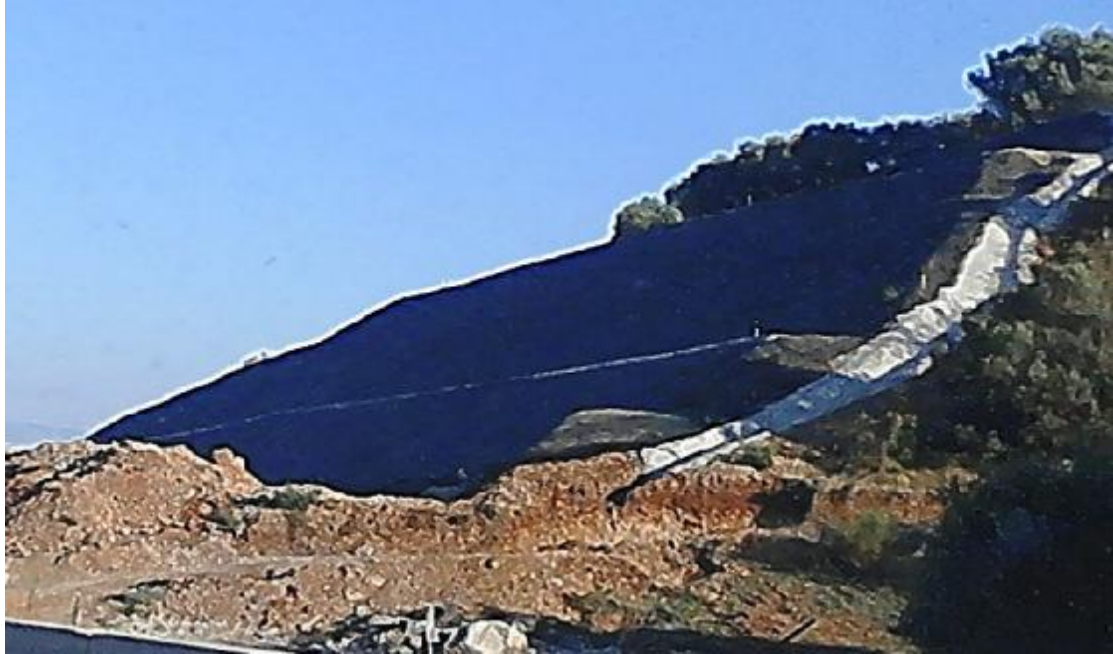
Εικόνα 60.Κάλυψη διαμορφωμένων πρανών με πλέγμα. (α)
