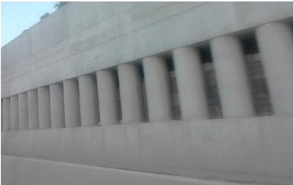
Εικόνα 87.Στήριξη πρανών με φρεατοπάσσαλους. (ξ)
