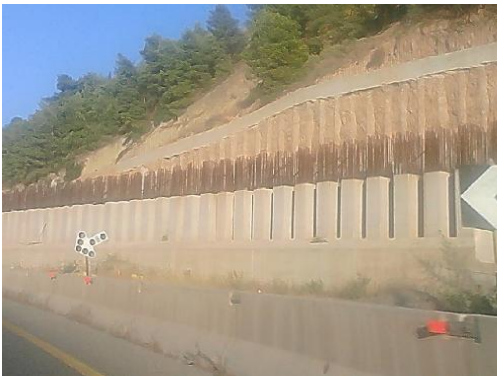
Εικόνα 81.Στήριξη πρανών με φρεατοπάσσαλους. (θ)
