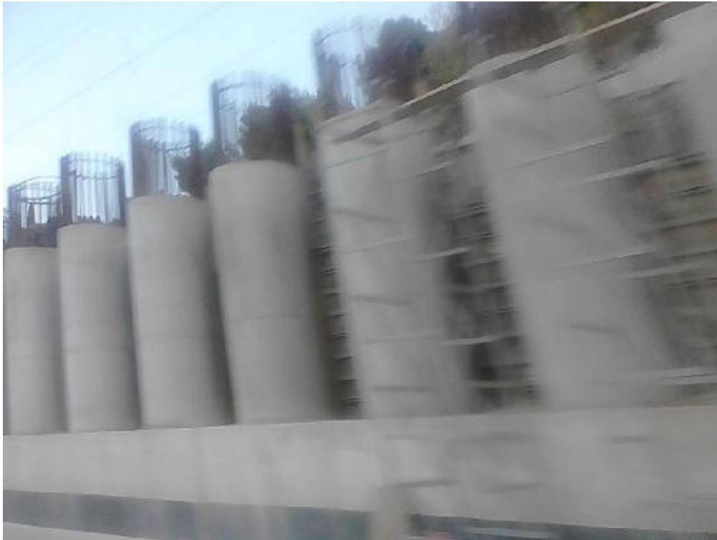
Εικόνα 88. Στήριξη πρανών με φρεατοπάσσλους. (ο)
