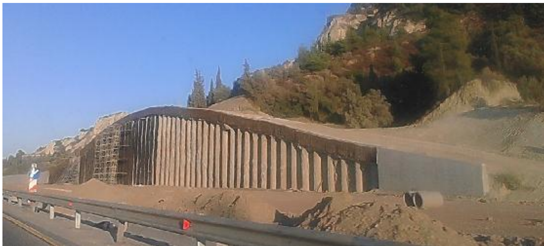
Εικόνα 89.Στήριξη πρανών με φρεατοπάσσλους. (πι)
