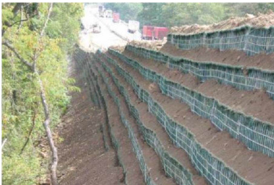
Εικόνα 5. Η χρήση γεωπλεγμάτων αποτελεί μια σύγχρονη, γρήγορη και οικονομική μέθοδο ενίσχυσης και σταθεροποίησης εδαφών.[2]
