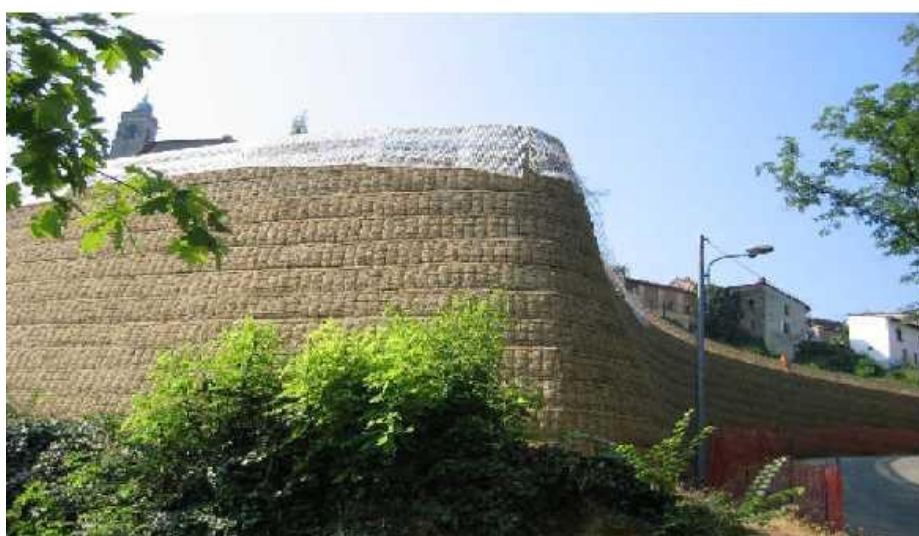
Εικόνα 40. Ενισχυμένο πρανές για την αντιστήριξη ξενοδοχείου. [9]
