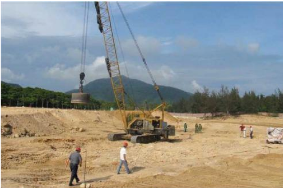
Εικόνα 4. Εφαρμογή της μεθόδου δυναμικής συμπίκνωσης, η οποία συνίσταται στη ρίψη όγκων μεγάλου βάρους στο έδαφος.[2]
