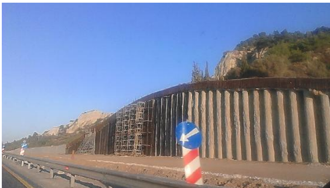
Εικόνα 90.Στήριξη πρανών με φρεατοπάσσαλους. (ρ)
