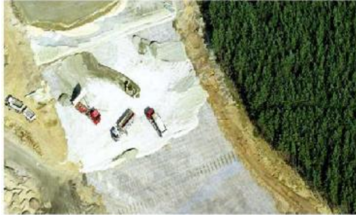
Εικόνα 34. Πανοραμική απεικόνιση της τοποθεσίας έργου οδοποιίας [9]
