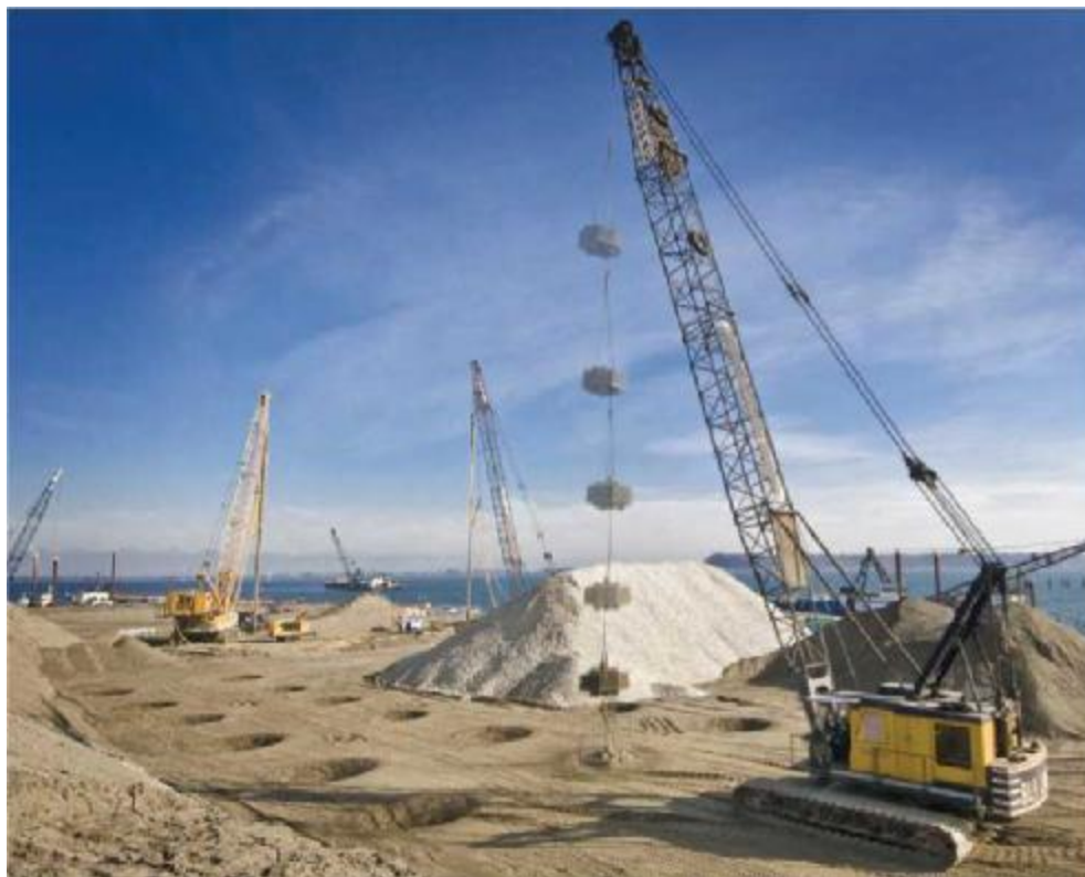
Εικόνα 1. Συμπύκνωση εδάφους με την βοήθεια μηχανήματος. [2]
