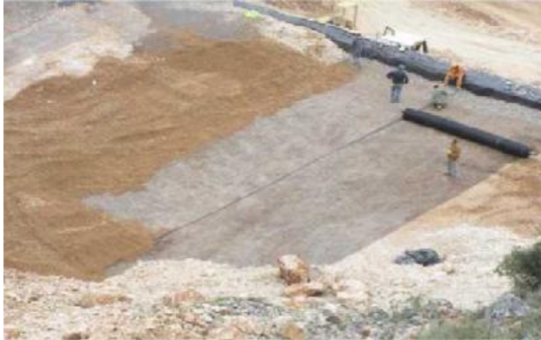
Εικόνα 51. Τοποθέτηση των γεωσυνθετικών στο πρανές.
