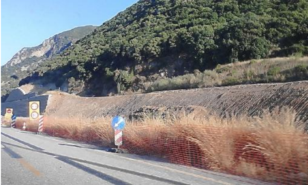
Εικόνα 70. Στήριξη πρανών με συρματοκυβώτια. (α)
