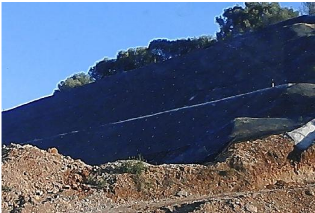
Εικόνα 61.Κάλυψη διαμορφωμένων πρανών με πλέγμα. (β)
