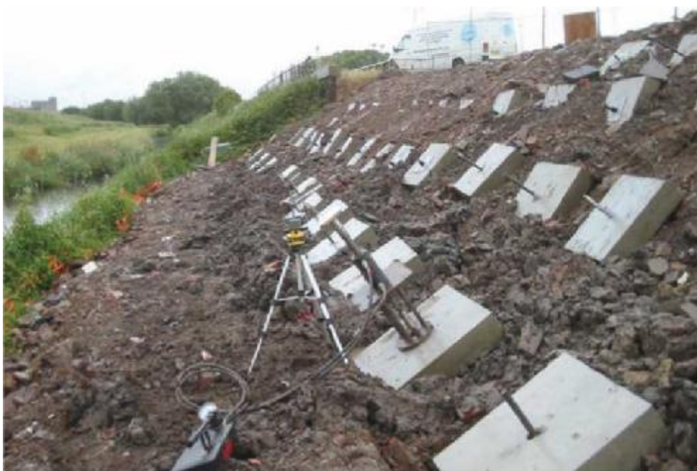
Εικόνα 7. Πολλές μέθοδοι ενίσχυσης περιλαμβάνουν την επιβολή ξένων προς το έδαφος στοιχείων, όπως αγκυρίων.[2]
