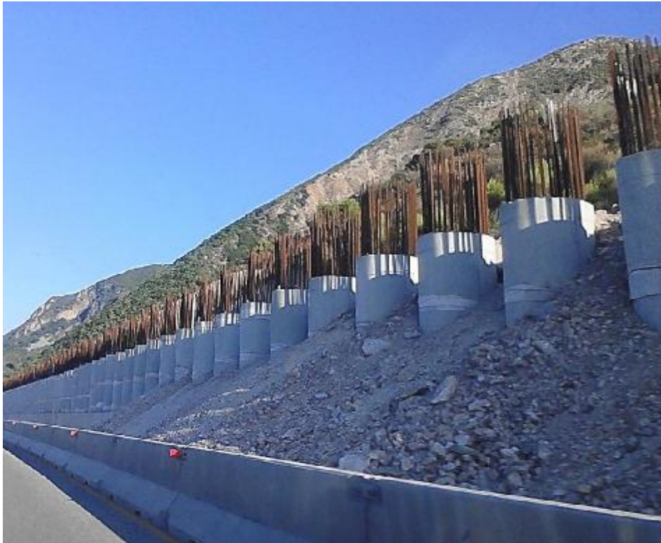
Εικόνα 76.Στήριξη πρανών με φρεατοπάσσαλους. (γ)
