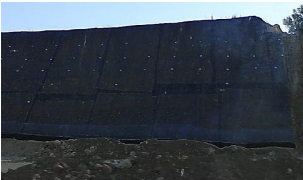
Εικόνα 63. Κάλυψη διαμορφωμένων πρανών με πλέγμα. (δ)
