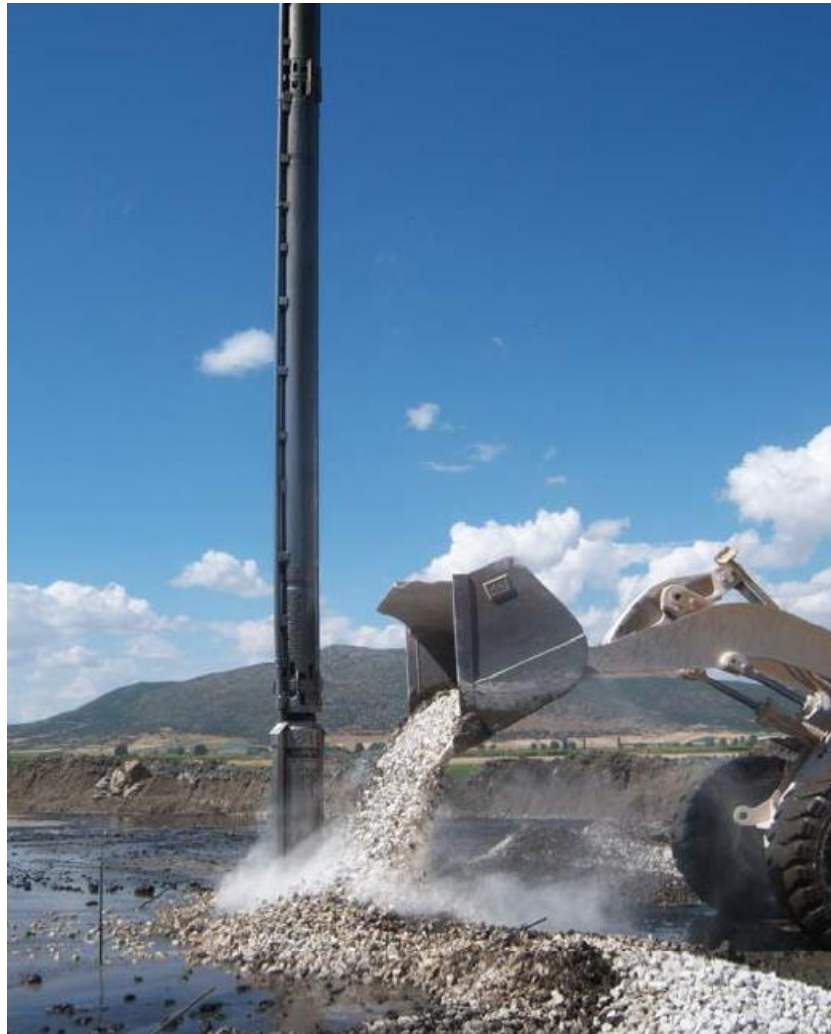
Εικόνα 56. Κατασκευή χαλικοπασσάλου σε «πραγματικές συνθήκες» [11].
