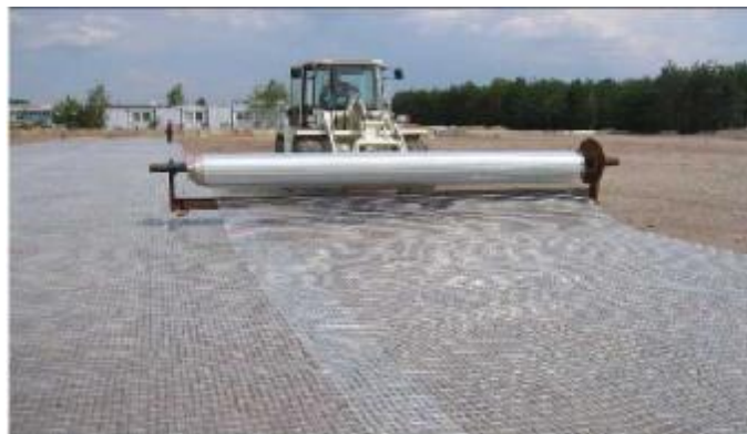
Εικόνα 35. Απεικόνιση της τοποθέτησης των γεωπλεγμάτων με ειδικό όχημα [9]
