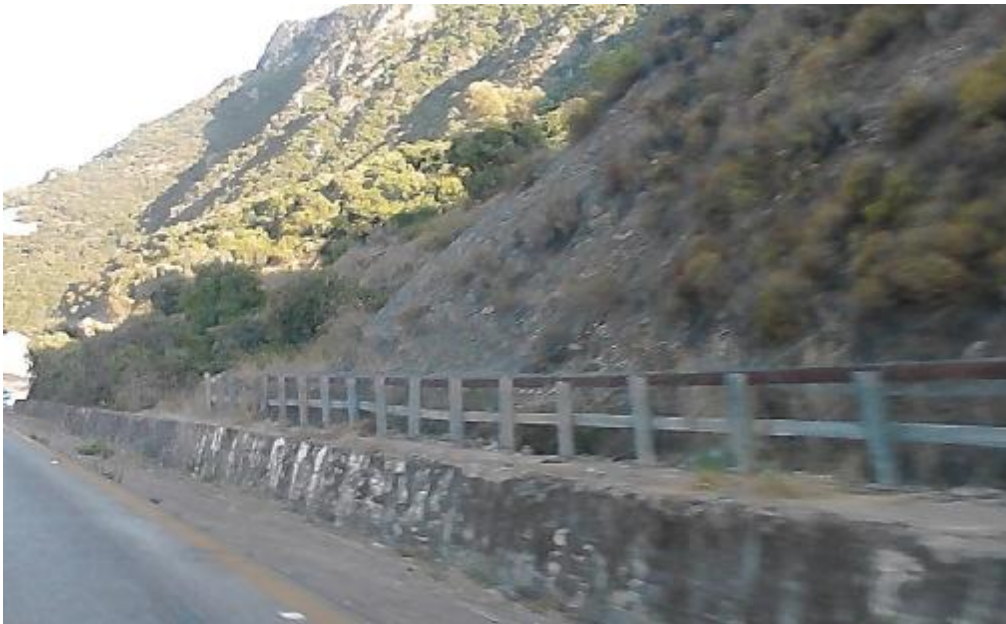
Εικόνα 92. Στήριξη πρανών με φυτοκάλυψη. (α)
