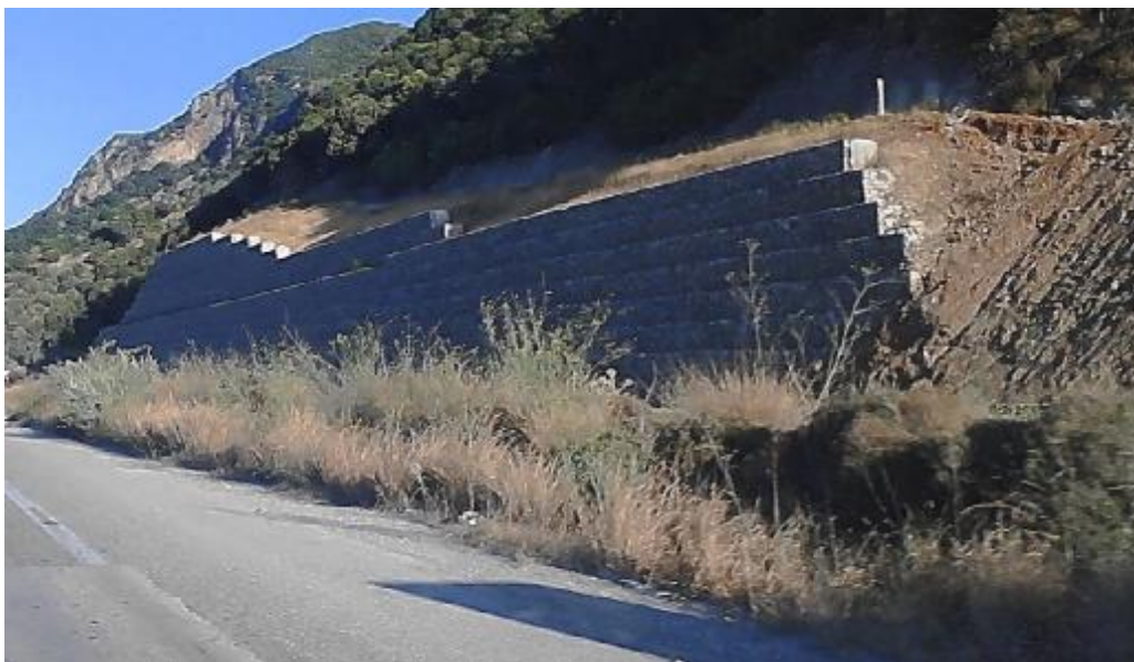
Εικόνα 71. Στήριξη πρανών με συρματοκυβώτια. (β)
