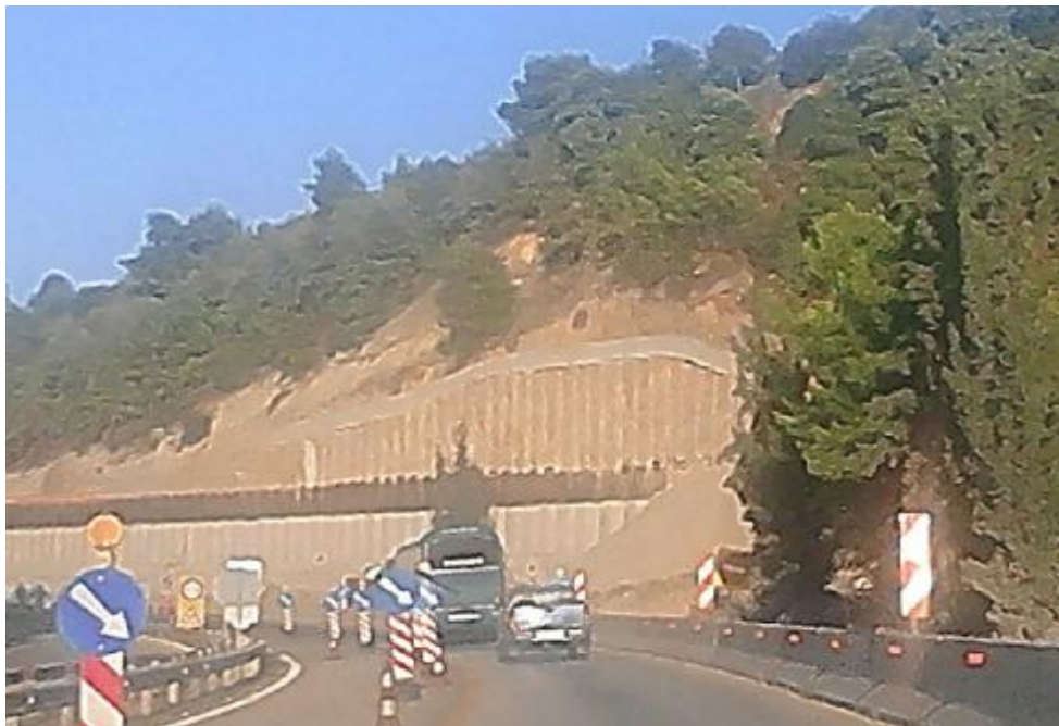
Εικόνα 79.Στήριξη πρανών με φρεατοπάσσαλους. (ζ)
