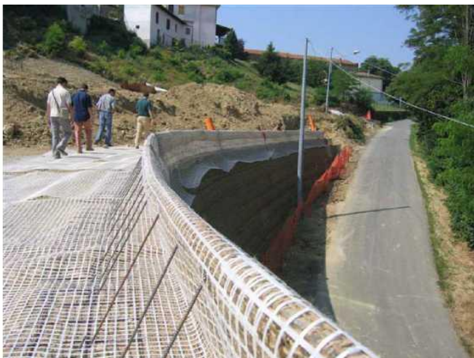
Εικόνα 39. Απεικόνιση της τοποθέτησης των γεωσυνθετικών. [9]
