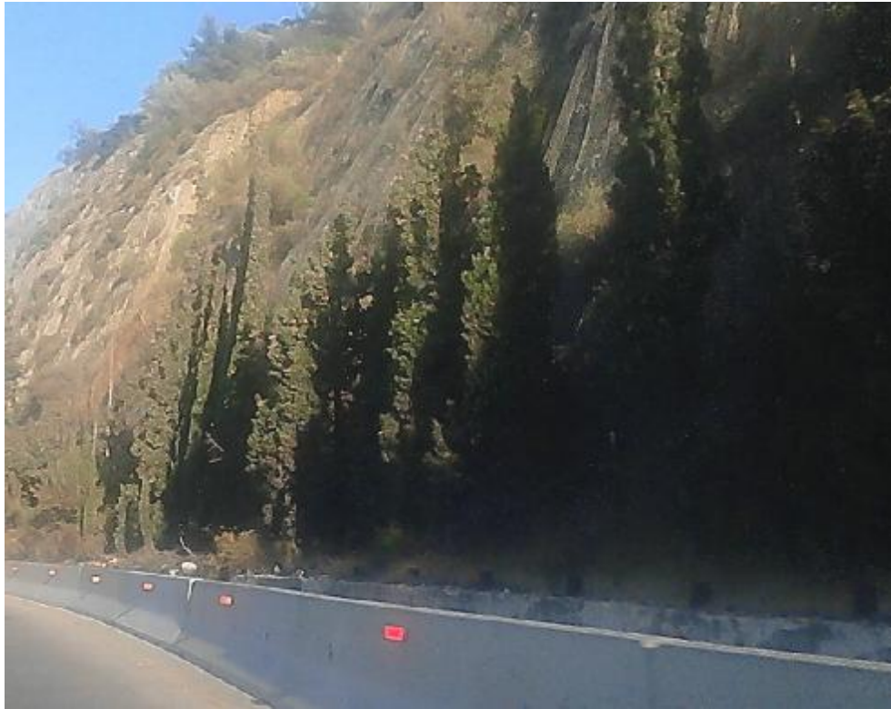
Εικόνα 96.Στήριξη πρανών με φυτοκάλυψη. (ε)
