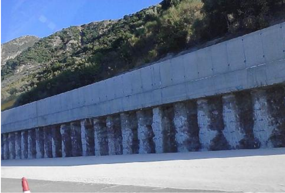
Εικόνα 74. Στήριξη πρανών με φρεατοπάσσλους. (α)
