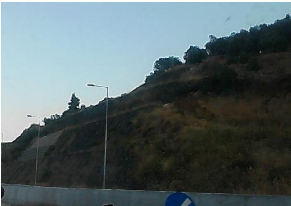
Εικόνα 95.Στήριξη πρανών με φυτοκάλυψη. (δ)
