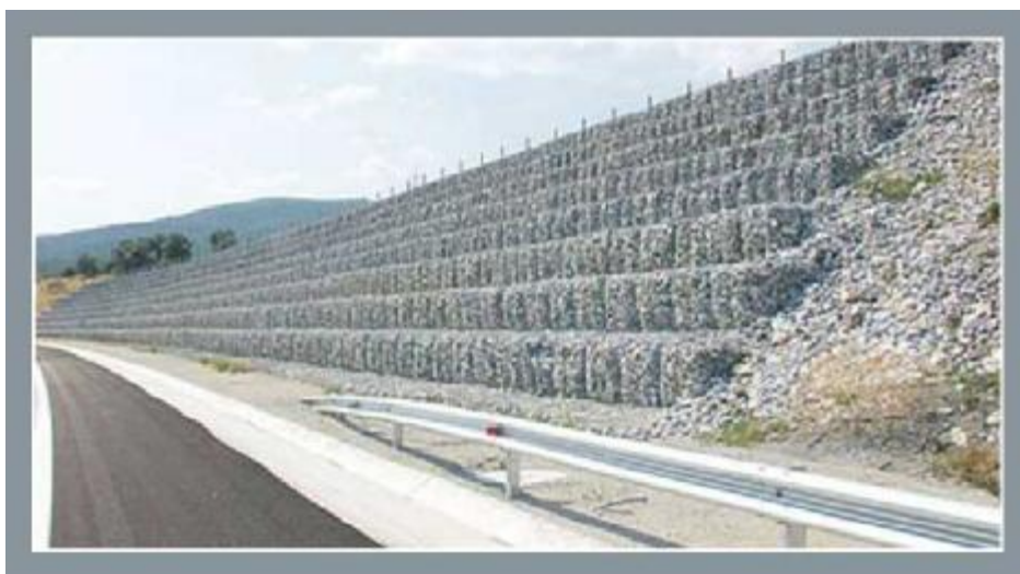
Εικόνα 15. Κάλυψη πρανούς με συρματοκιβώτια.[7]
