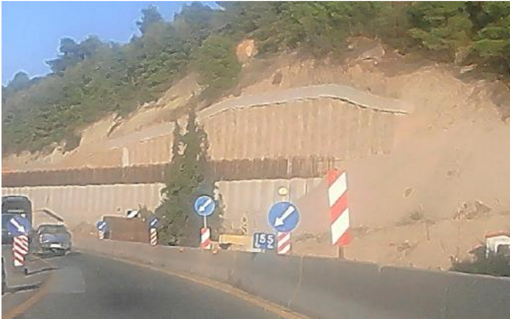
Εικόνα 80.Στήριξη πρανών με φρεατοπάσσαλους. (η)
