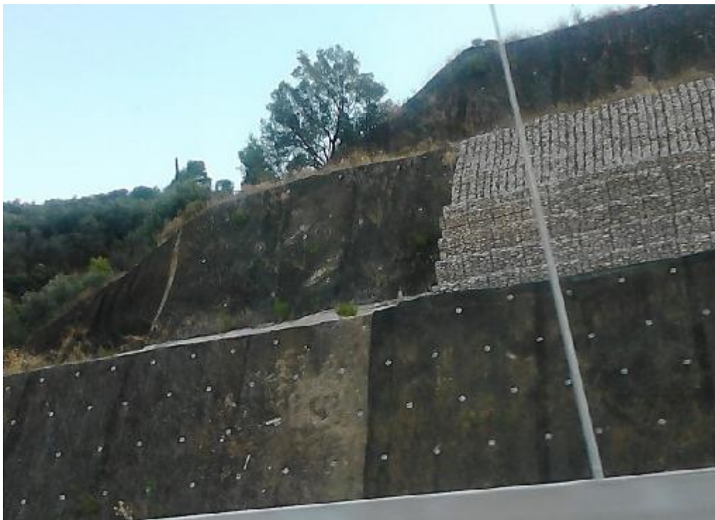
Εικόνα 64.Κάλυψη διαμορφωμένων πρανών με πλέγμα. (ε)
