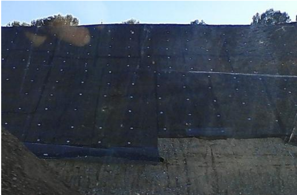
Εικόνα 62.Κάλυψη διαμορφωμένων πρανών με πλέγμα. (γ)
