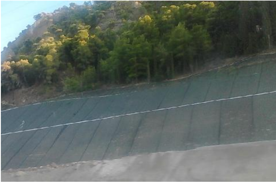
Εικόνα 68.Κάλυψη διαμορφωμένων πρανών με πλέγμα. (ι)
