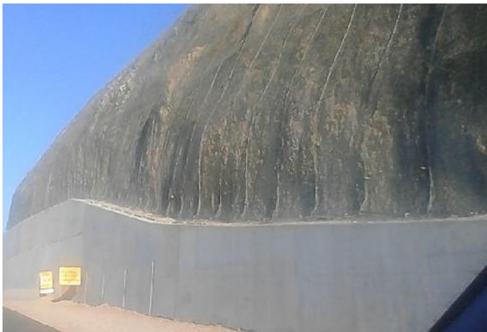
Εικόνα 67.Κάλυψη διαμορφωμένων πρανών με πλέγμα. (θ)
