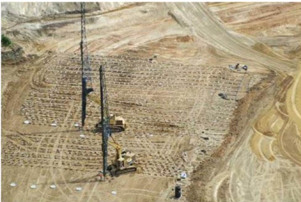
Εικόνα 2. Τα κατακόρυφα γεωσύνθετα στραγγιστήρια τοποθετούνται μέσα στο έδαφος με τη βοήθεια ειδικού γερανού με κατακόρυφο οδηγό, σε μικρές μεταξύ τους αποστάσεις των 2 - 4m.[2]
