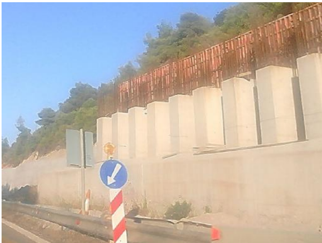
Εικόνα 83.Στήριξη πρανών με φρεατοπάσσαλους. (κ)
