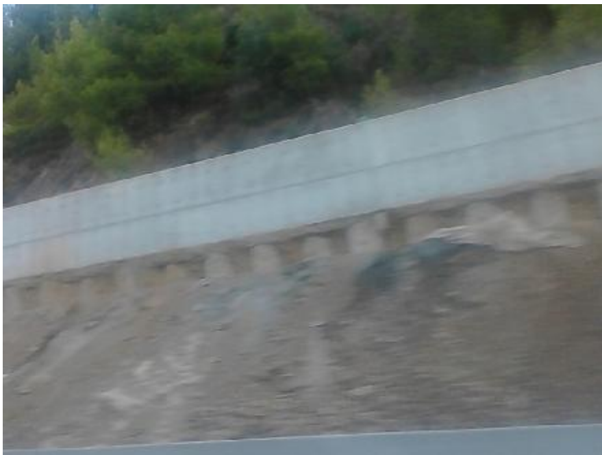
Εικόνα 77.Στήριξη πρανών με φρεατοπάσσαλους. (δ)
