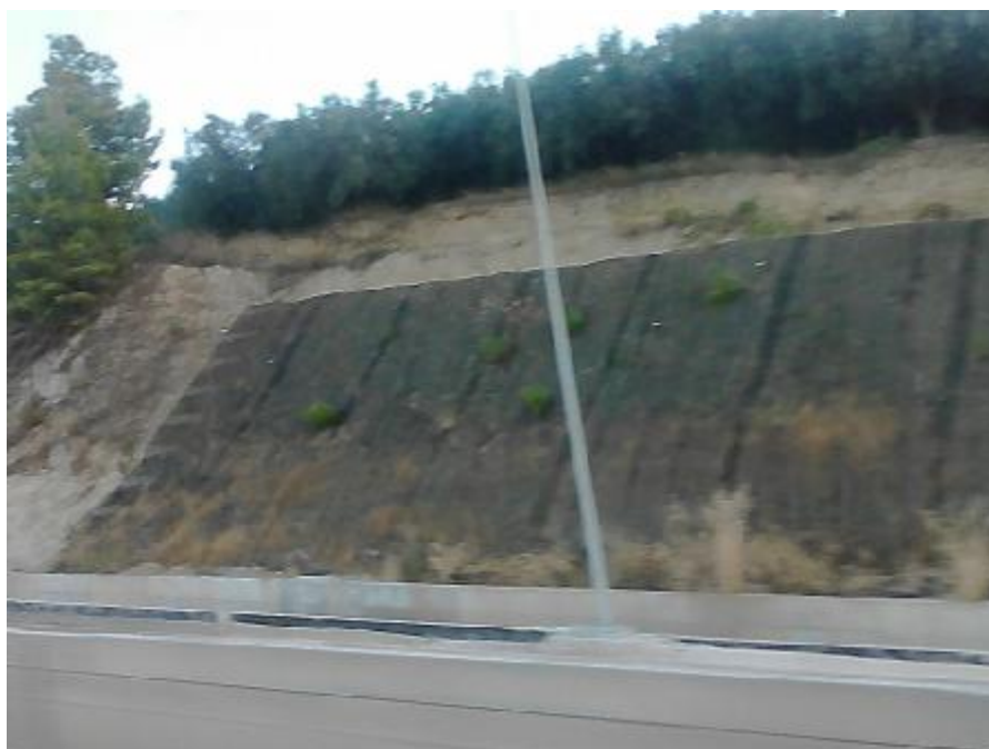
Εικόνα 65.Κάλυψη διαμορφωμένων πρανών με πλέγμα. (ζ)
