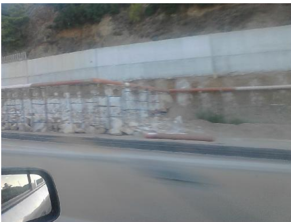
Εικόνα 85.Στήριξη πρανών με φρεατοπάσσαλους. (μ)
