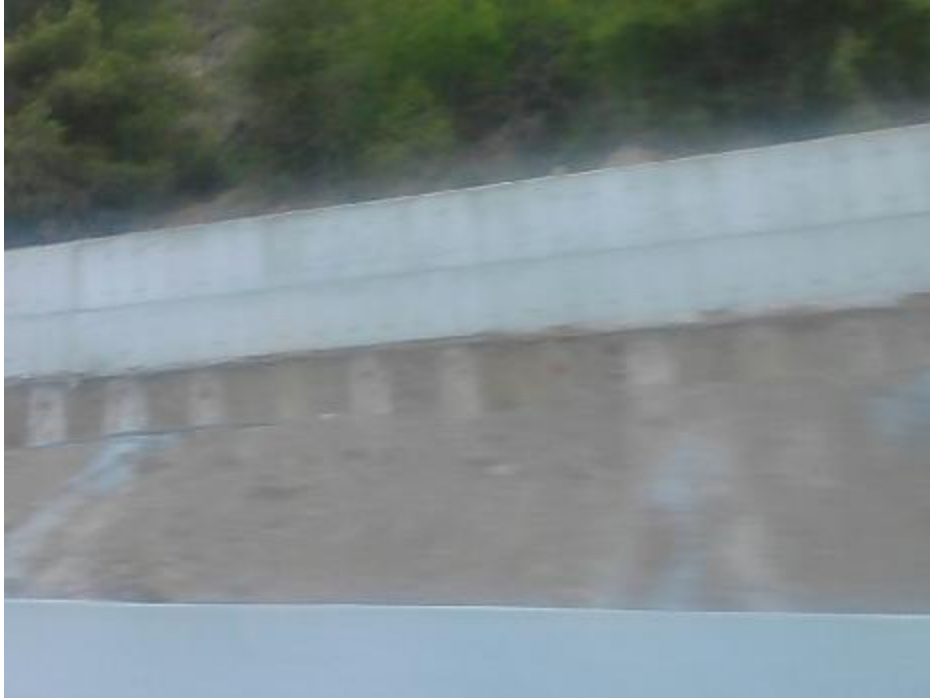
Εικόνα 78.Στήριξη πρανών με φρεατοπάσσαλους. (ε)
