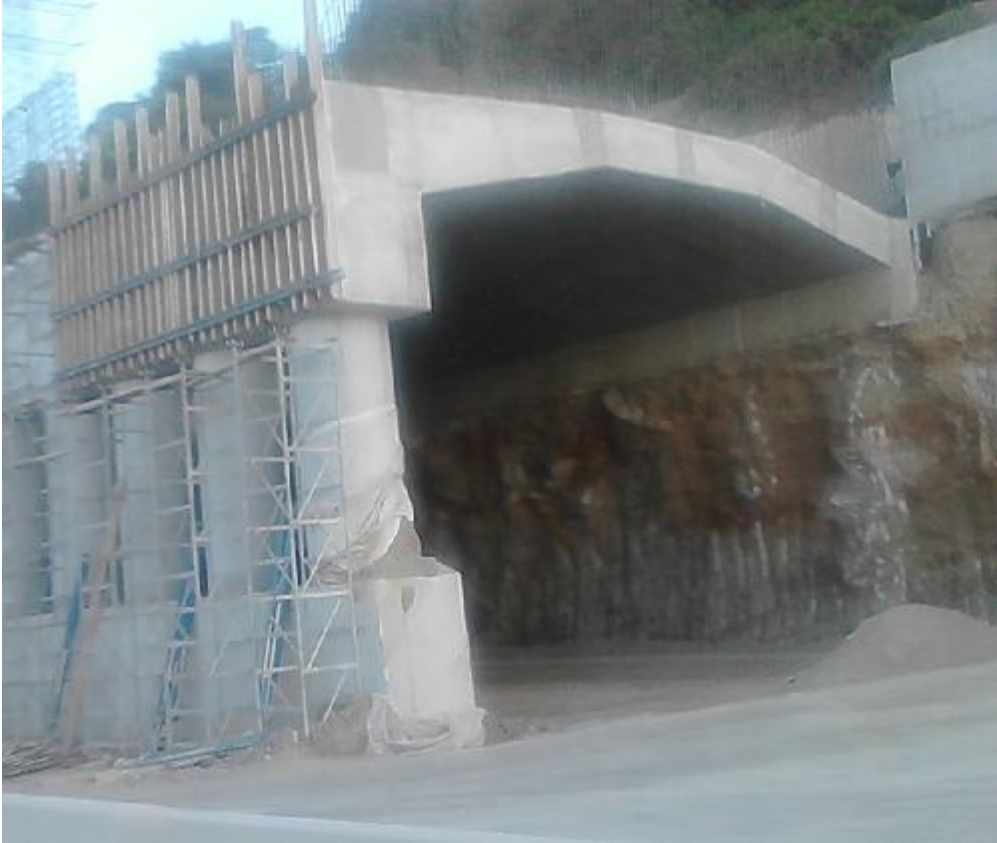
Εικόνα 86.Στήριξη πρανών με φρεατοπάσσαλους. (ν)
