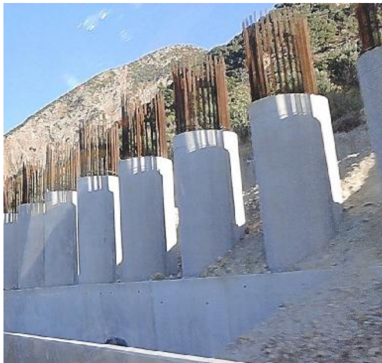
Εικόνα 75. Στήριξη πρανών με φρεατοπάσσλους. (β)
