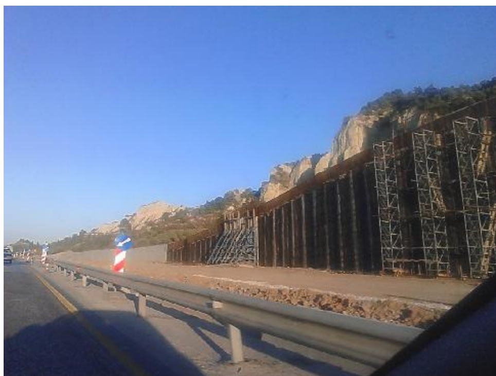
Εικόνα 91.Στήριξη πρανών με φρεατοπάσσαλους. (σ)
