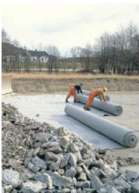
Εικόνα 6. Το γεωύφασμα λειτουργεί ως διαχωριστική στρώση ανάμεσα στο έδαφος και στο θραυστό υλικό.[2]
