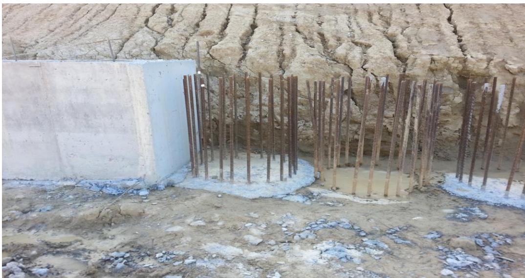
Εικόνα 4.13 Κατασκευή κεφαλόδεσμου
