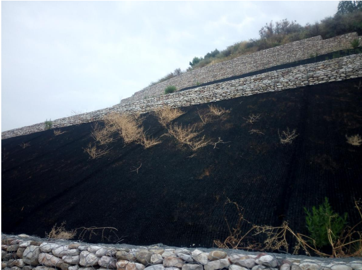
Εικόνα 5.4 Τοποθετημένο γεόπλεγμα στο πρανές.
