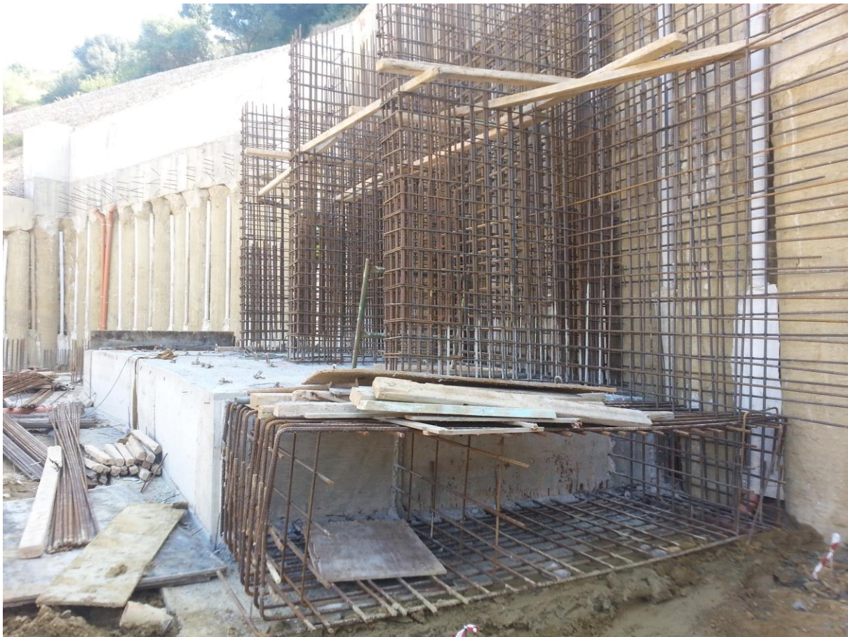
Εικόνα 4.17 Σκυροδετημένος κεφαλόδεσμος. Φαίνεται η προεξοχή επιπρόσθετου οπλισμού.
