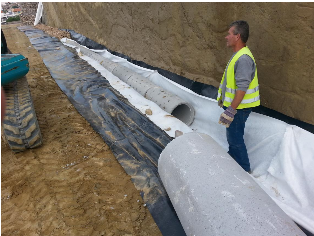
Εικόνα 5.1 Εργασίες τοποθέτησης αποχετευτικού σωλήνα.
