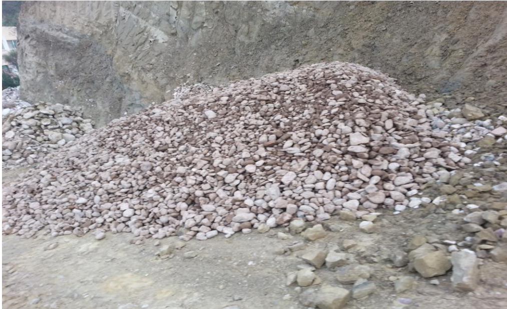
Εικόνα 3.2 Λίθοι για την πλήρωση συρματοκιβωτίων
