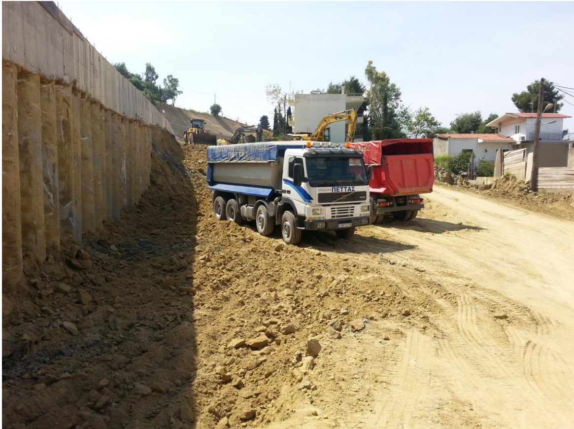
Εικόνα 4.14 Εκσκαφή για την εμφάνιση της πασσαλοστοιχίας
