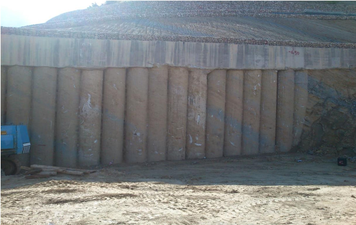
Εικόνα 4.15 Εμφάνιση πασσαλότοιχου μετά την κατακόρυφη εκσκαφή
