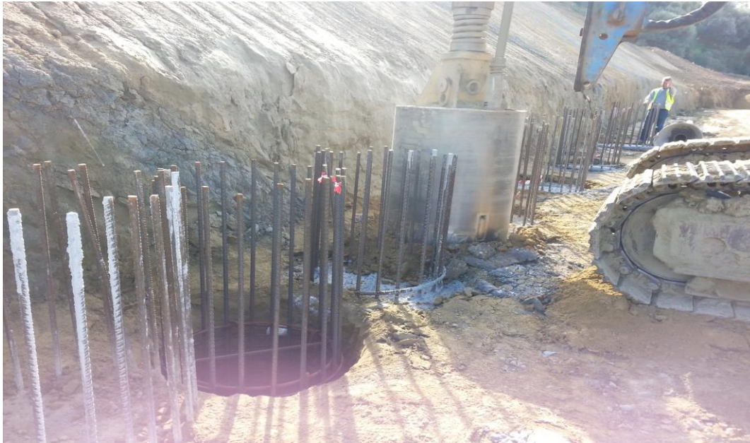
Εικόνα 4.12 Απεικόνιση του μηχανήματος διάτρησης κατά την εκσκαφή οπής ενδιάμεσα από δύο σκυροδετημένους πασσάλους
