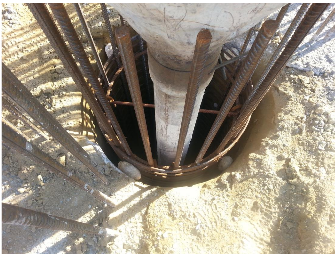
Εικόνα 4.9 Τοποθετημένος οπλισμός στην οπή έτοιμη για σκυροδέτηση.
