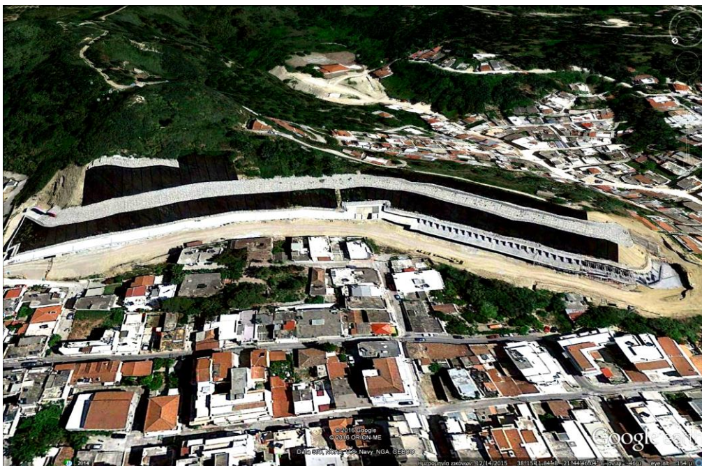
Εικόνα 4.32 Εικόνα Google Earth <Διάνοιξη οδού Κανακάρη> 2016
