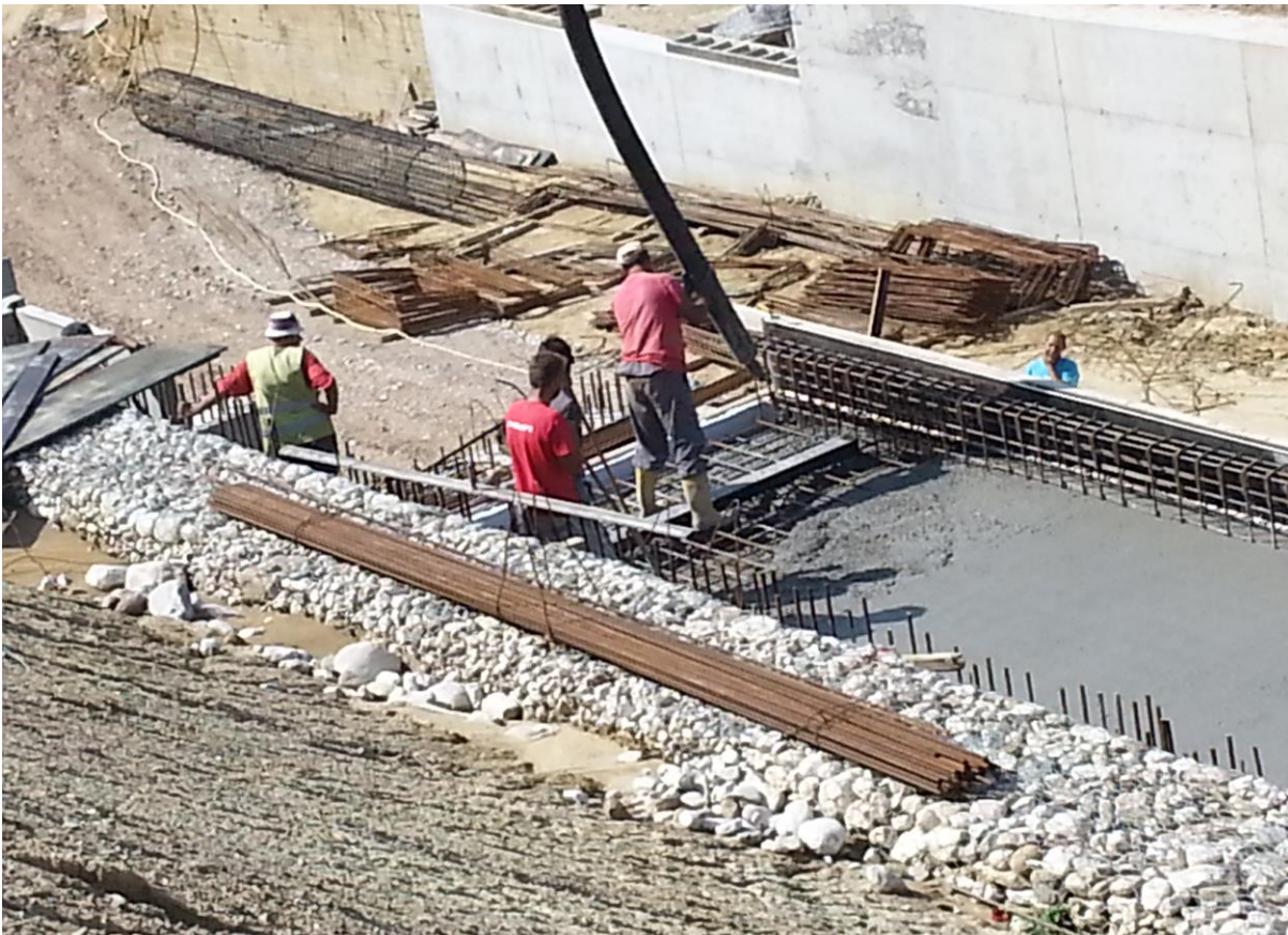
Εικόνα 4.25 Διαδικασία σκυροδέτησης προβόλου.
