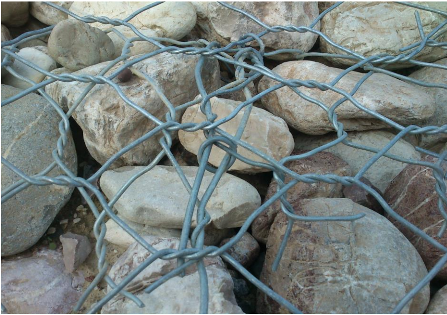
Εικόνα 3.7 Συνδετήρας σαραζανέτ και επιπλέον στρώση συρματοπλέγματος.
