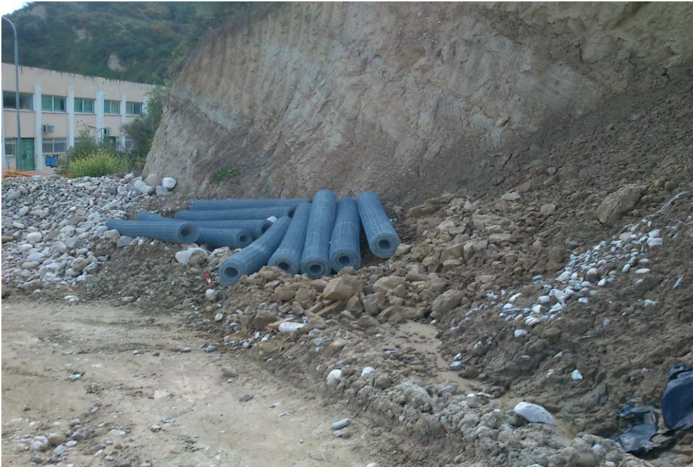
Εικόνα 3.3 Συρματόπλεγμα για τη συγκρότηση των λίθων
