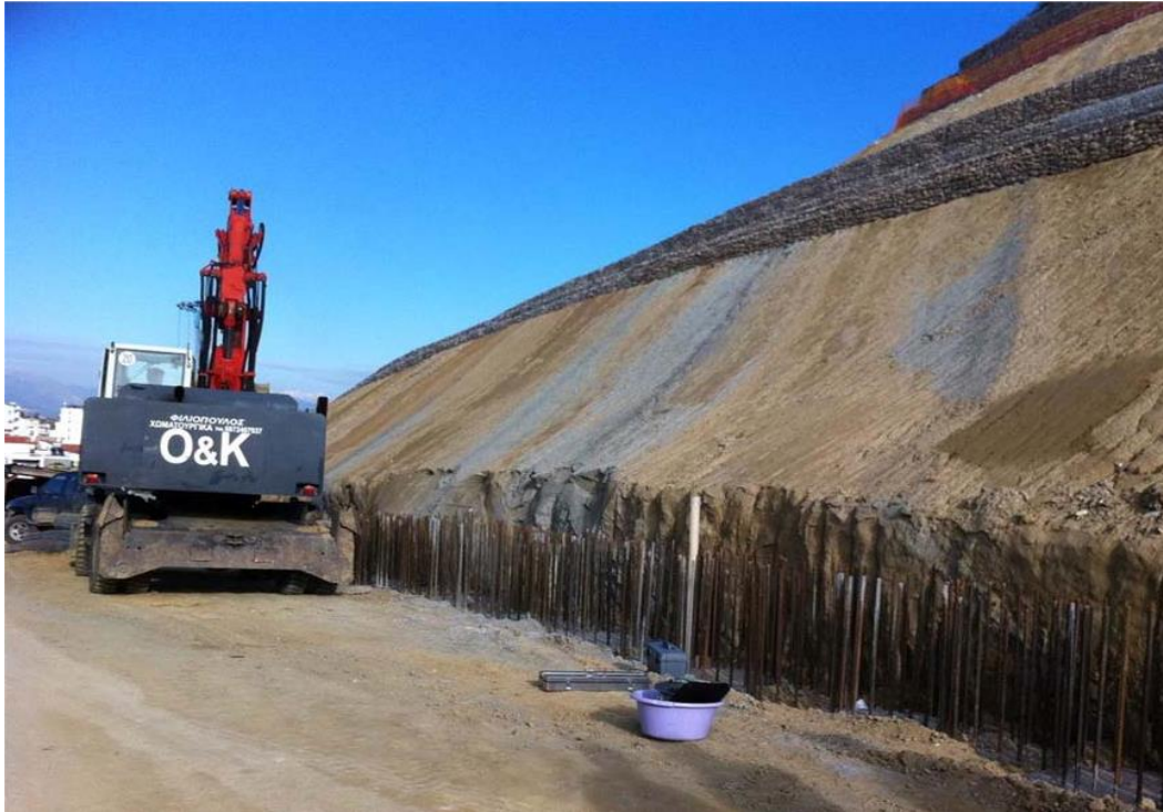
Εικόνα 6.1.1 Τοποθετημένος αποκλισιομετρικός σωλήνας στο σημείο που θα κατασκευαστεί κεφαλόδεσμος
