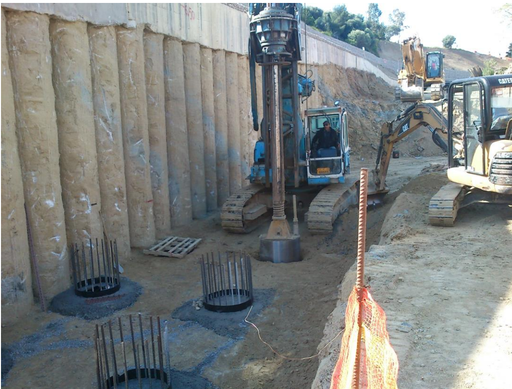
Εικόνα 4.16 Πάσσαλοι θεμελίων
