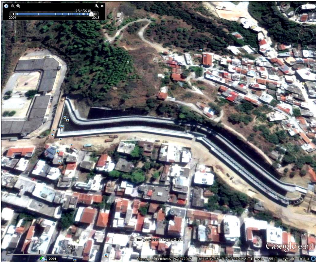
Εικόνα 4.32 Εικόνα Google Earth <Διάνοιξη οδού Κανακάρη> 2015
