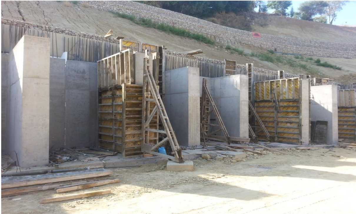
Εικόνα 4.22 Στην εικόνα φαίνονται αντηρίδες που τους έχουν αφαιρεθεί τα καλούπια , και άλλες που βρίσκονται στο διάστημα αφαιρέσής τους.
