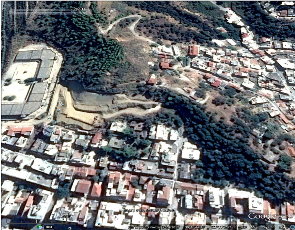
Εικόνα 4.30 Εικόνα Google Earth <Διάνοιξη οδού Κανακάρη> 2013
