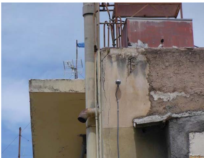
Εικόνες 6.1.7 , 6.1.8 , 6.1.9 Τοποθετημένα κλισίμετρα σε τοιχοποιίες οικοδομών
