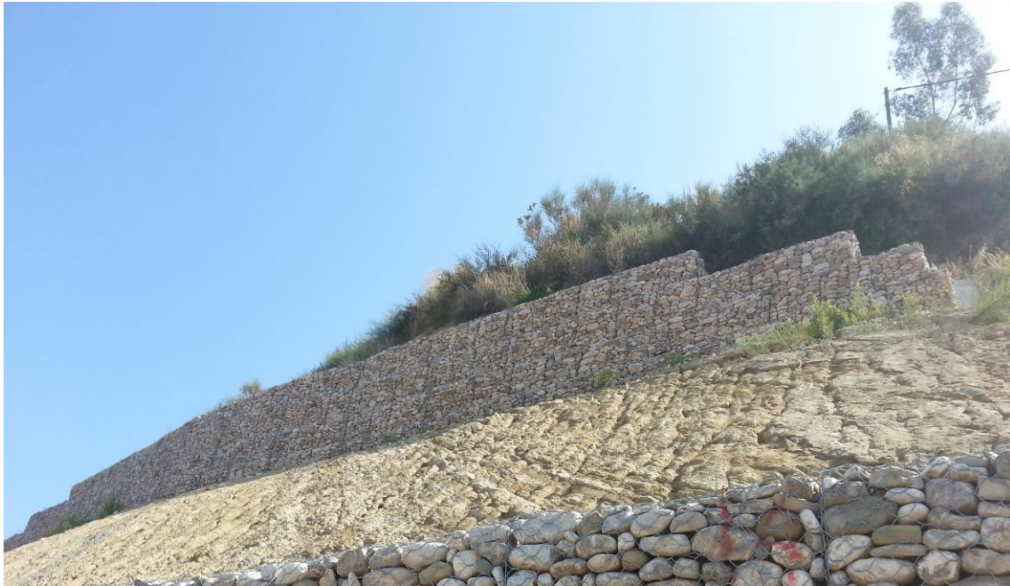
Εικόνα 3.9 Ο πρώτος τοίχος σαραζανέτ πάνω στο όριο έργου.
