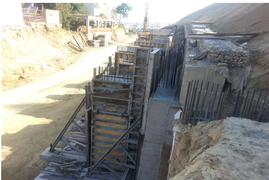
Εικόνα 4.23 Οπλισμός στην κορυφή των αντηρίδων για την κατασκευή του προβόλου.
