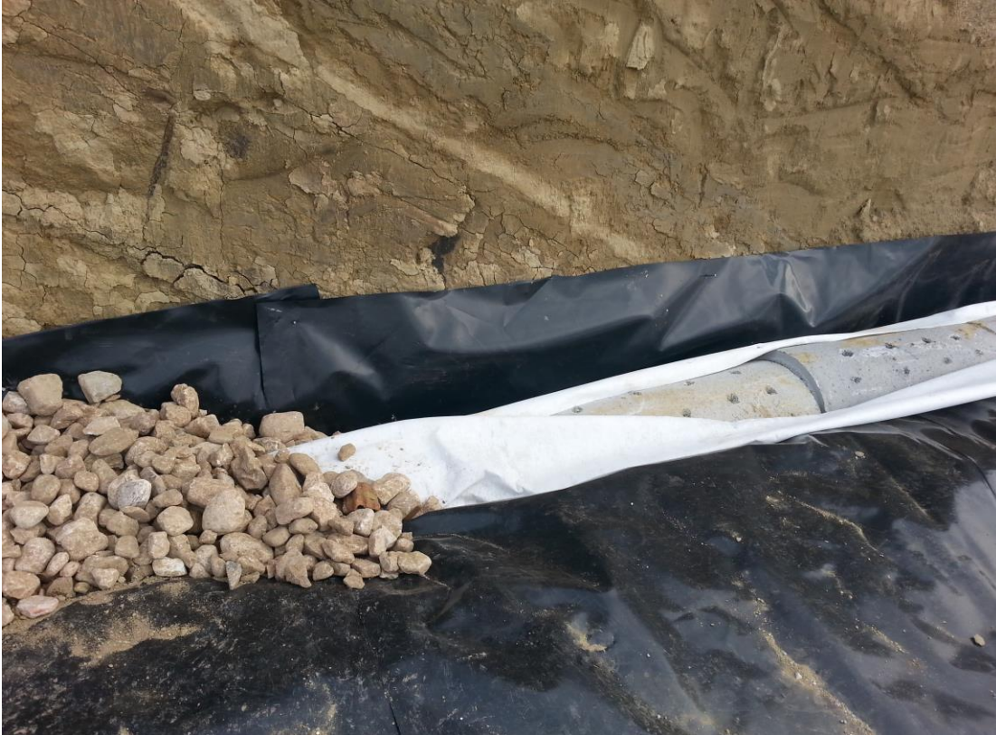
Εικόνα 5.2 Τοποθέτηση θραυστού υλικού πάνω σε αγωγό αποστράγγισης.
