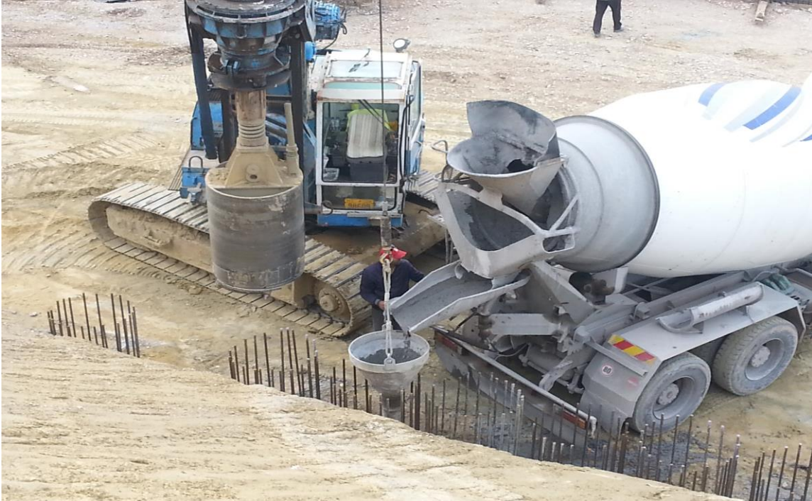
Εικόνα 4.10 Διαδικασία σκυροδέτησης. Το μηχάνημα διάτρησης έχει τοποθετήσει το εξάρτημα τη διαδικασία και η μπετονιέρα γεμίζει την οπή με σκυρόδεμα.
