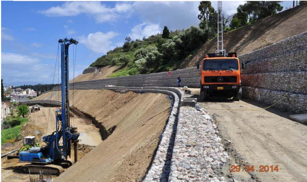
Εικόνα 6.1.2 Διαδικασία τοποθέτησης αποκλισιομετρικών σωλήνων
