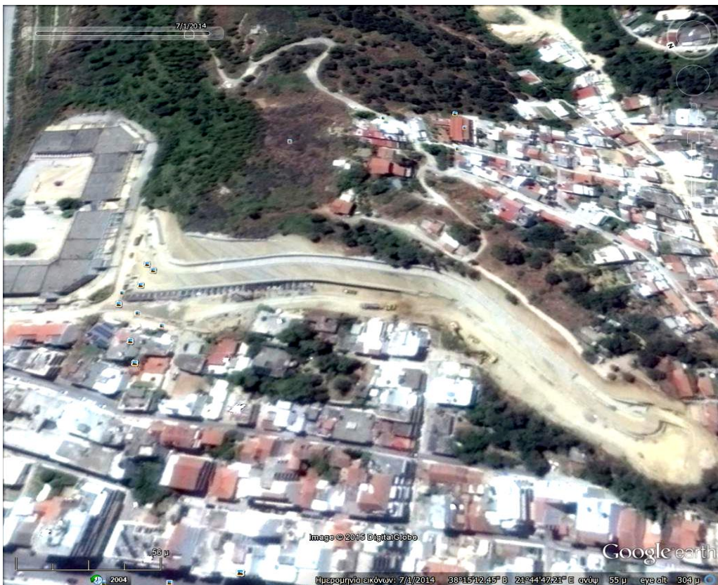
Εικόνα 4.31 Εικόνα Google Earth <Διάνοιξη οδού Κανακάρη> 2014
