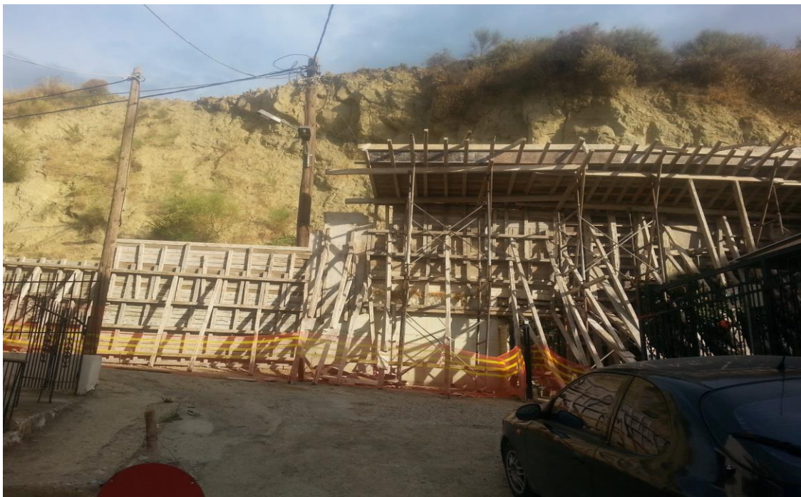
Εικόνα 2.4 Προσωρινή κατασκευή ξύλινου τοίχου για την προστασία από την κατάπτωση βράχων
