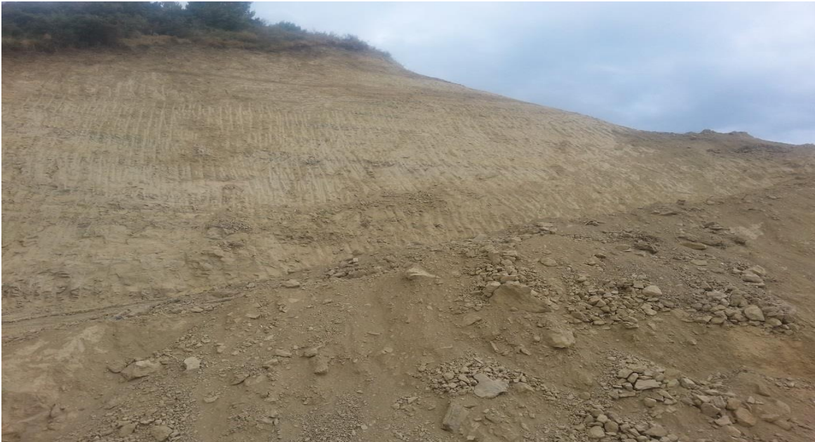
Εικόνα 2.6: Πρανές διαμορφωμένο με το εξωτερικό του κάδου του εκσκαφέα
