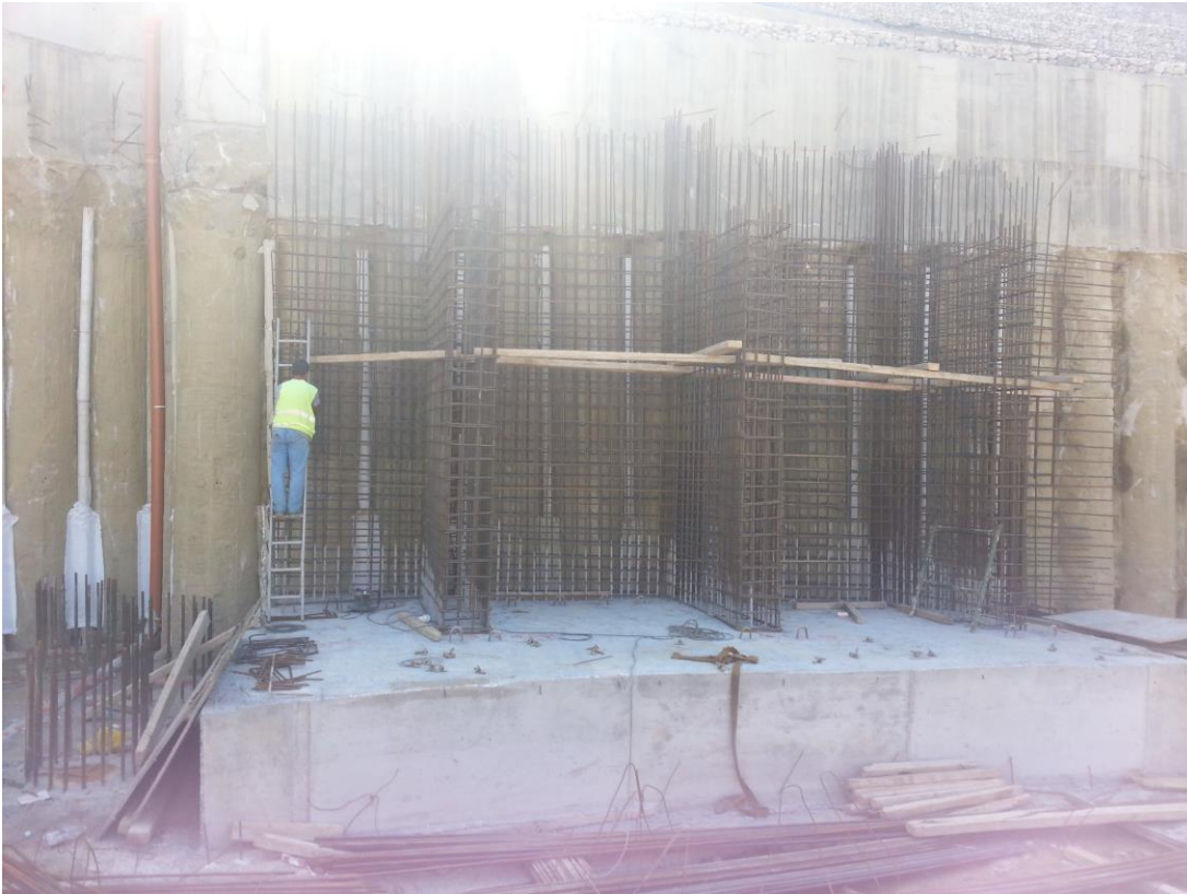
Εικόνα 4.18 Απεικονίζεται ο οπλισμός των αντηρίδων.
