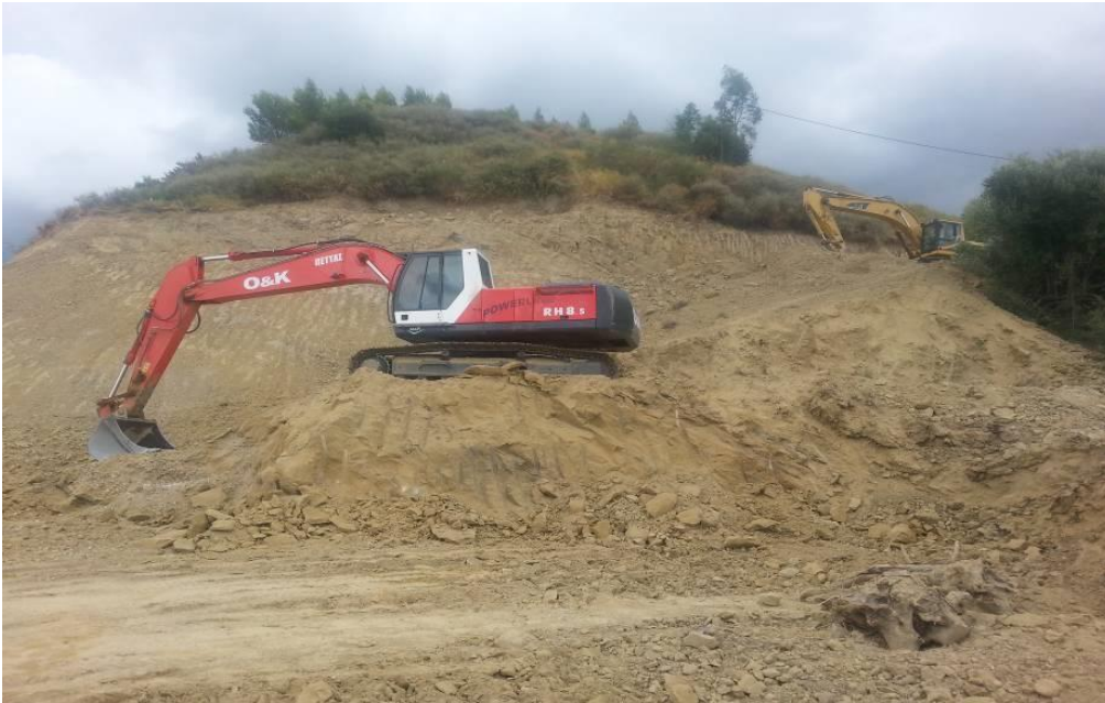
Εικόνα 2.1 Προετοιμασία εργοταξίου – αφαίρεση 1 ης φάσης πρανούς
