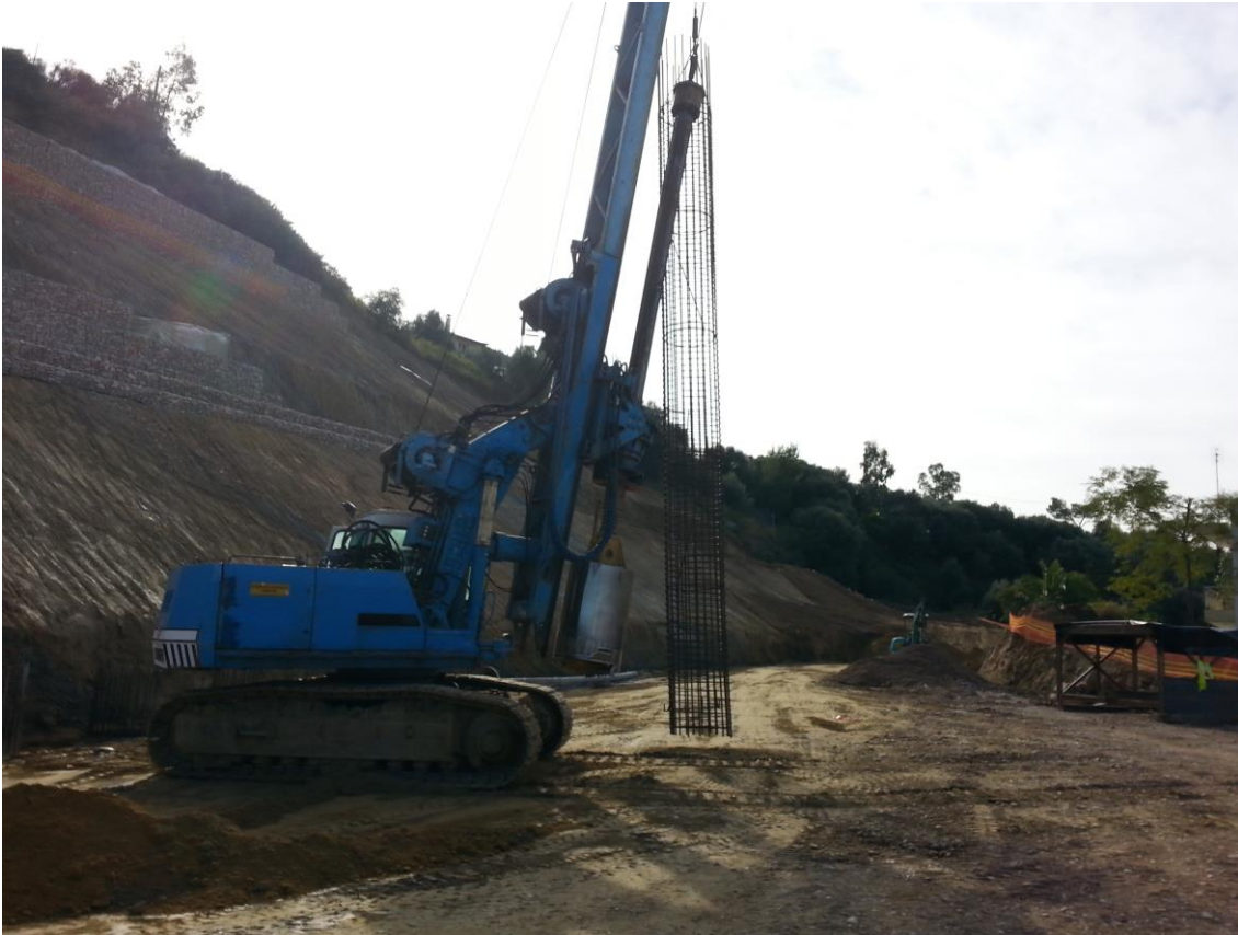
Εικόνα 4.7 Μεταφορά οπλισμού στην οπή.
