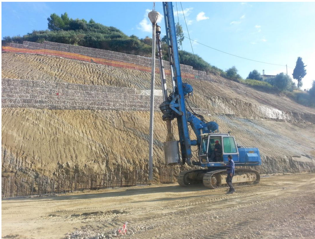
Εικόνα 4.8 Μεταφορά του εξαρτήματος στην οπή
