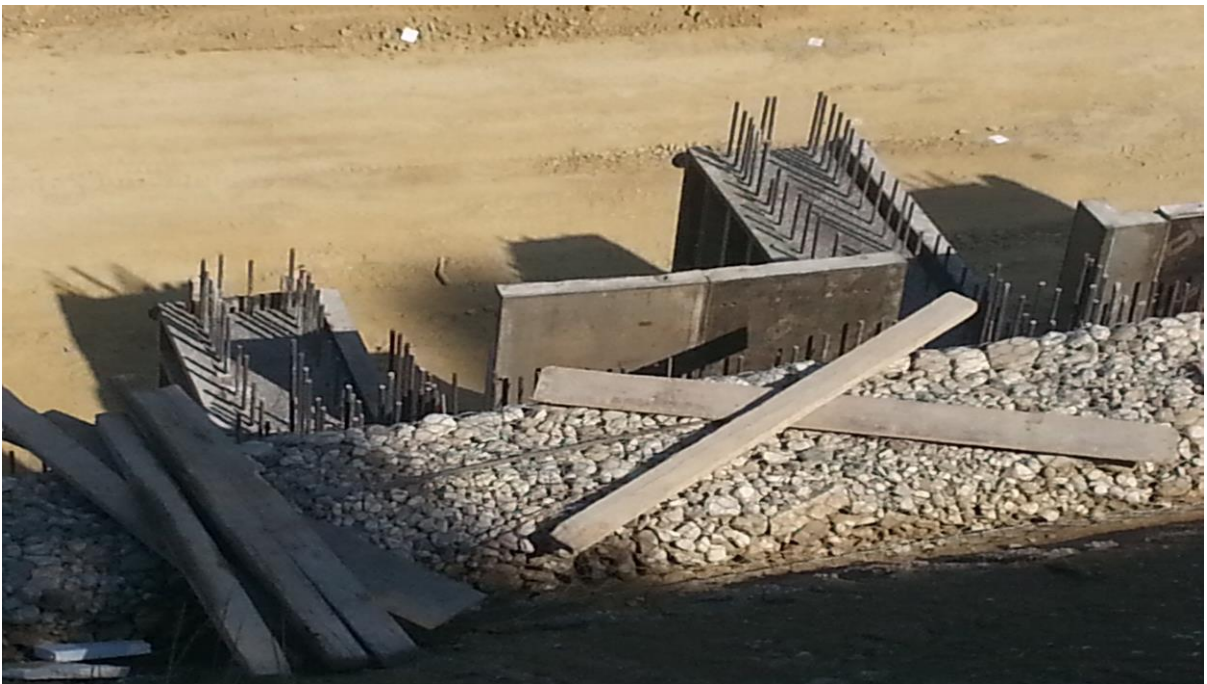
Εικόνα 4.21 Σκυροδετημένες αντηρίδες.
