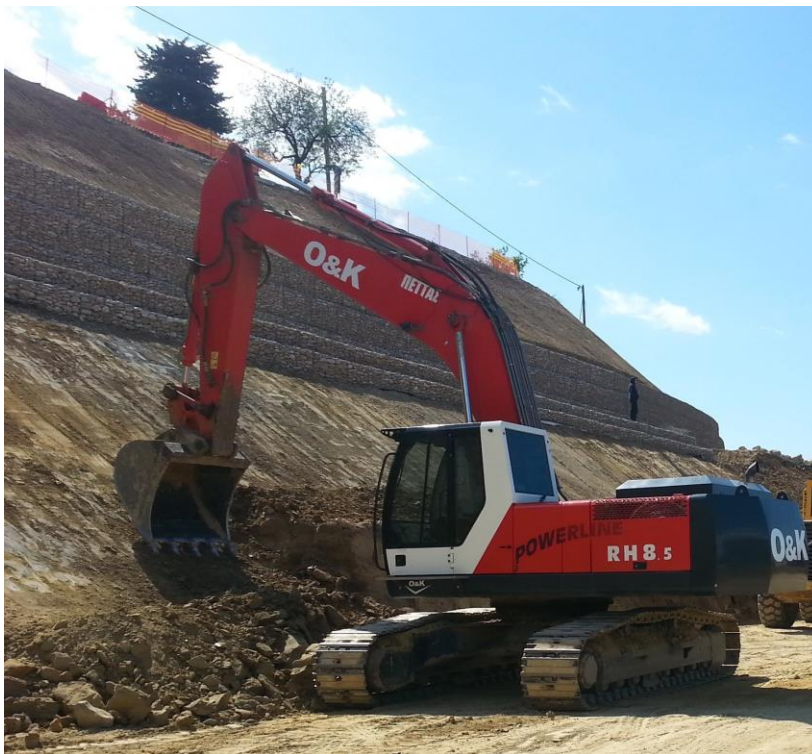
Εικόνα 2.5: Διαμόρφωση πρανούς με την βοήθεια της εξωτερικής παρειάς του κάδου του εκσκαφέα
