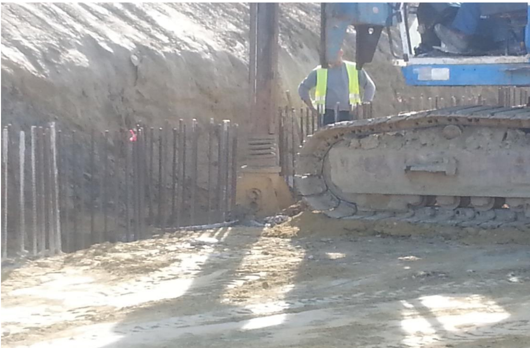
Εικόνα 4.3 Το μηχάνημα κατά τη διάρκεια της εκσκαφής
