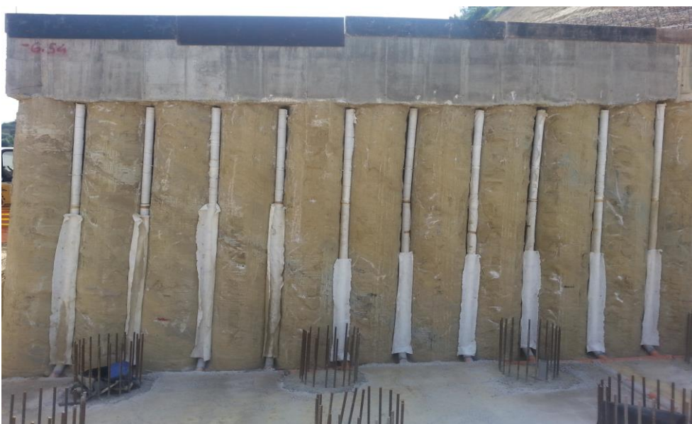
Εικόνα 5.3 Τοποθετημένοι σωλήνες PVC για ομαλή αποστράγγιση.
