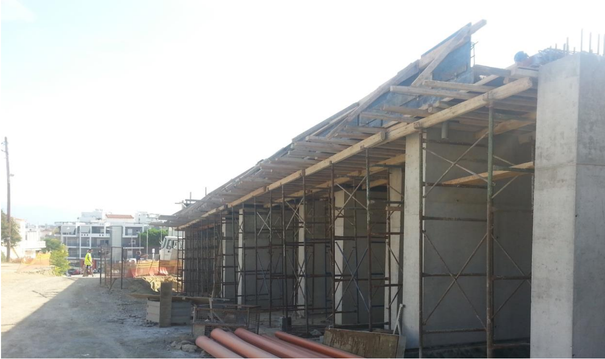
Εικόνα 4.24 Σκαλωσιές ανάμεσα από τις αντηρίδες και καλούπωμα.
