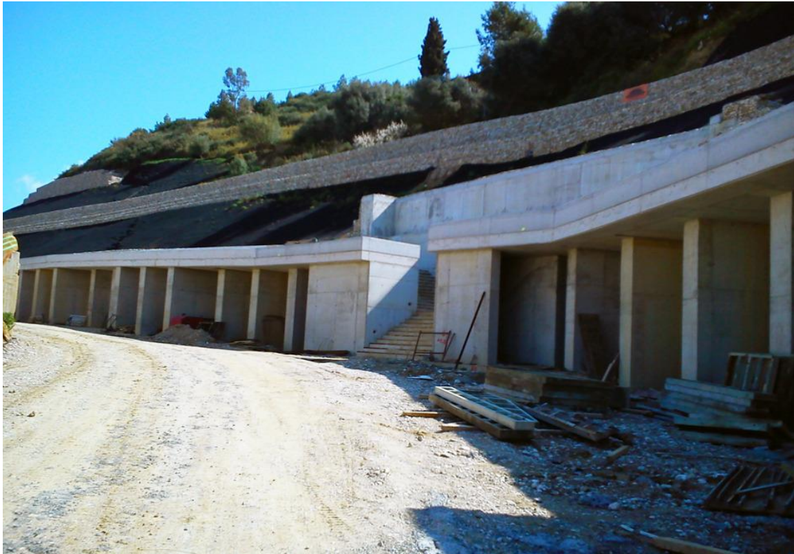
Εικόνα 4.28 Τελική μορφή τοίχου αντιστήριξης.
