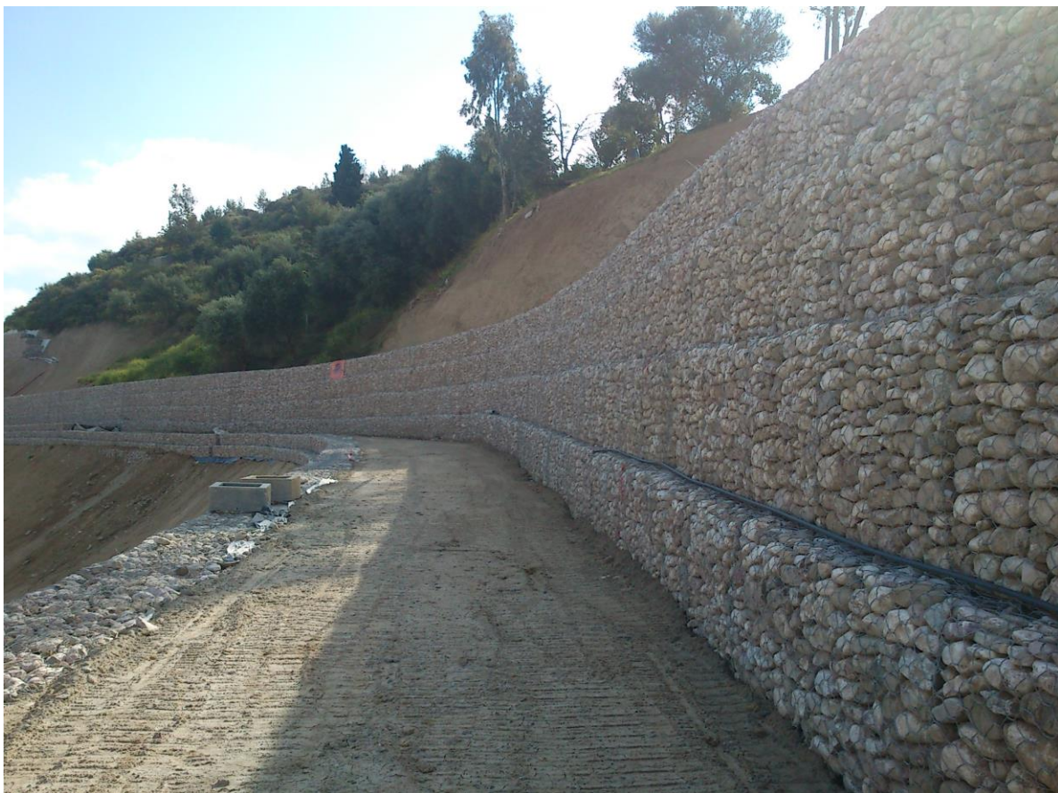
Εικόνα 3.1 Γενική εικόνα τοίχου σαραζανέτ
