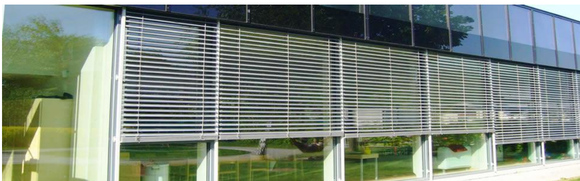
Εικόνα 32. Άποψη κτιρίου με εξωτερικές περσίδες σκίασης
