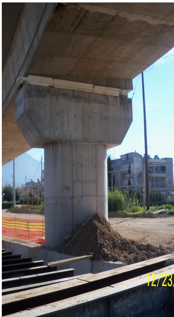
Φωτ. 6.10 Κατασκευή του μεσόβαθρου M15Δ όπου διακρίνονται τα φελιζόλ εν αναμονή για την τοποθέτηση των εφεδράνων.
