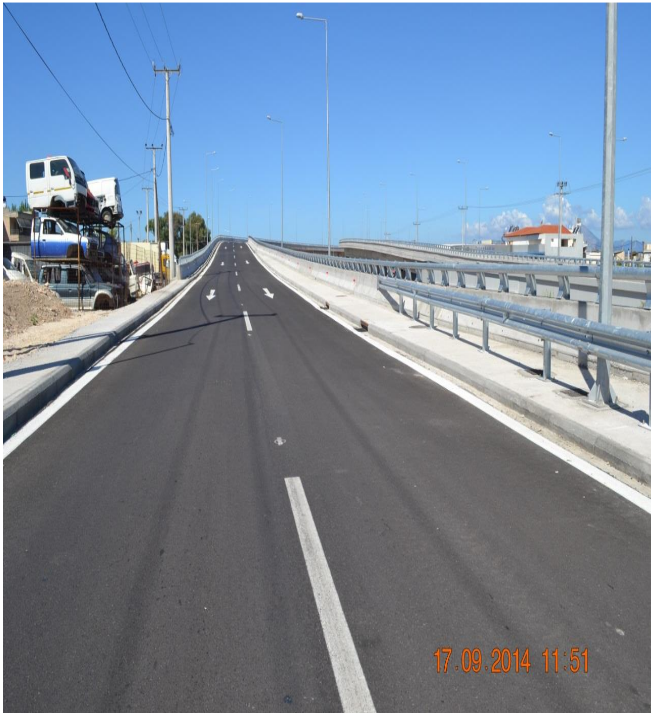
Φωτ. 6.24 Γενική άποψη του φορέα του καταστρώματος μετά την τοποθέτηση ασφαλτοτάπητα.
