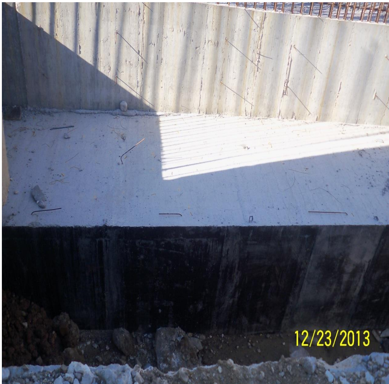
Φωτ. 6.21 Διακρίνεται η κεφαλοδοκός.
