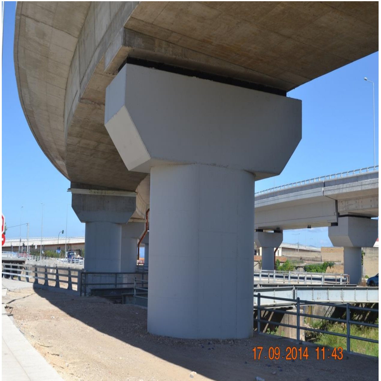
Φωτ. 6.11 Όψη του μεσόβαθρου M15Δ όπου διακρίνονται τα ελαστομεταλλικά εφεδράνα. Σε δεύτερο πλάνο διακρίνεται το μεσόβαθρο M14Δ στο οποίο παρατηρούμε τα φελιζόλ εν αναμονή για την τοποθέτηση των εφεδράνων.
