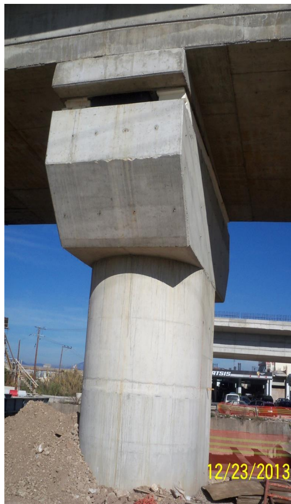
Φωτ. 6.10 Κατασκευή του μεσόβαθρου M15Δ όπου διακρίνονται τα φελιζόλ εν αναμονή για την τοποθέτηση των εφεδράνων.
