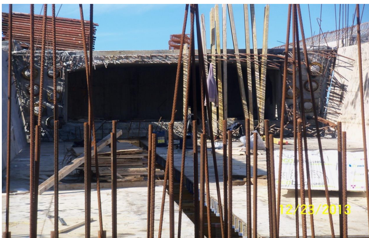
Φωτ. 6.20 Τυπική διατομή φορέα. Διακρίνονται δεξιά και αριστερά οι καμπάνες προέντασης.
