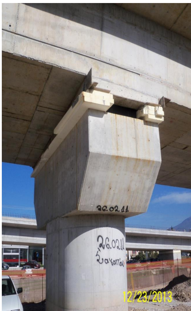
Φωτ. 6.13 Πλάγια όψη του μεσόβαθρου M16Δ όπου διακρίνονται τα φελιζόλ εν αναμονή για την τοποθέτηση των εφεδράνων και όψη του μεσόβαθρου όπου διακρίνονται τα ελαστομεταλλικά εφέδρανα της παρούσας γέφυρας.
