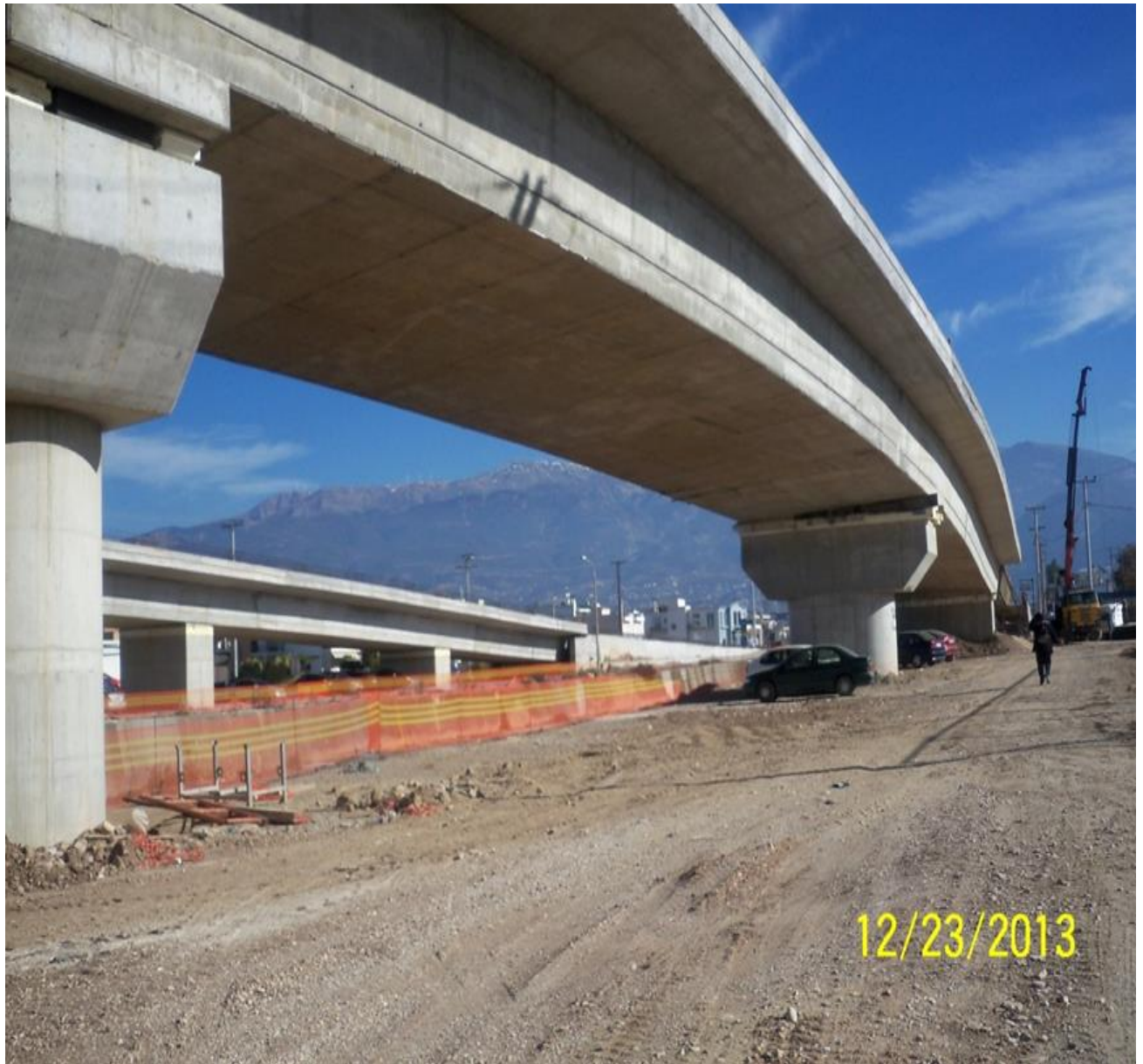
Φωτ. 6.12 Κατασκευή των μεσόβαθρων Μ15Δ, Μ16Δ και Μ17Δ της παρούσας γέφυρας. Σε δεύτερο πλάνο διακρίνεται η Γέφυρα Τ10.
