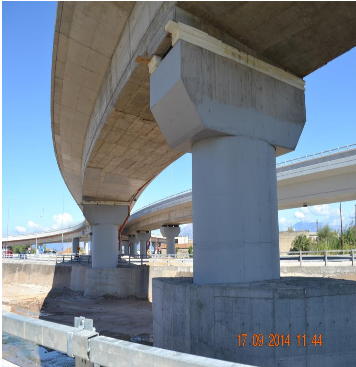
Φωτ. 6.8 Όψη του μεσόβαθρου M13Δ και του μεσόβαθρου M14Δ. Σε δεύτερο πλάνο διακρίνεται η Γέφυρα T8.
