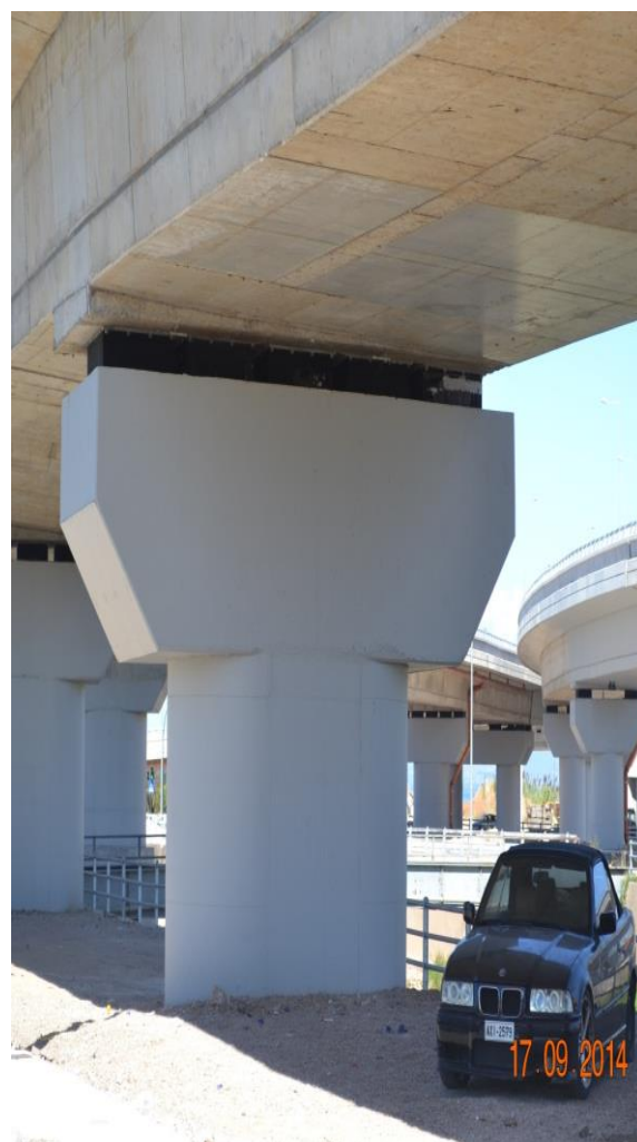
Φωτ. 6.13 Πλάγια όψη του μεσόβαθρου M16Δ όπου διακρίνονται τα φελιζόλ εν αναμονή για την τοποθέτηση των εφεδράνων και όψη του μεσόβαθρου όπου διακρίνονται τα ελαστομεταλλικά εφέδρανα της παρούσας γέφυρας.
