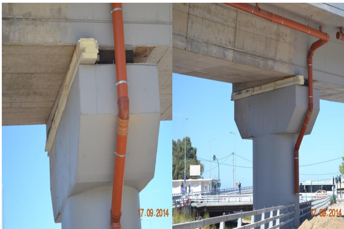
Φωτ. 6.7 Κατασκευή του μεσόβαθρου M13Δ. Παρατηρούμε την διάταξη αγωγών υδροσυλλογής και τα φελιζόλ εν αναμονή για την τοποθέτηση των εφεδράνων.
