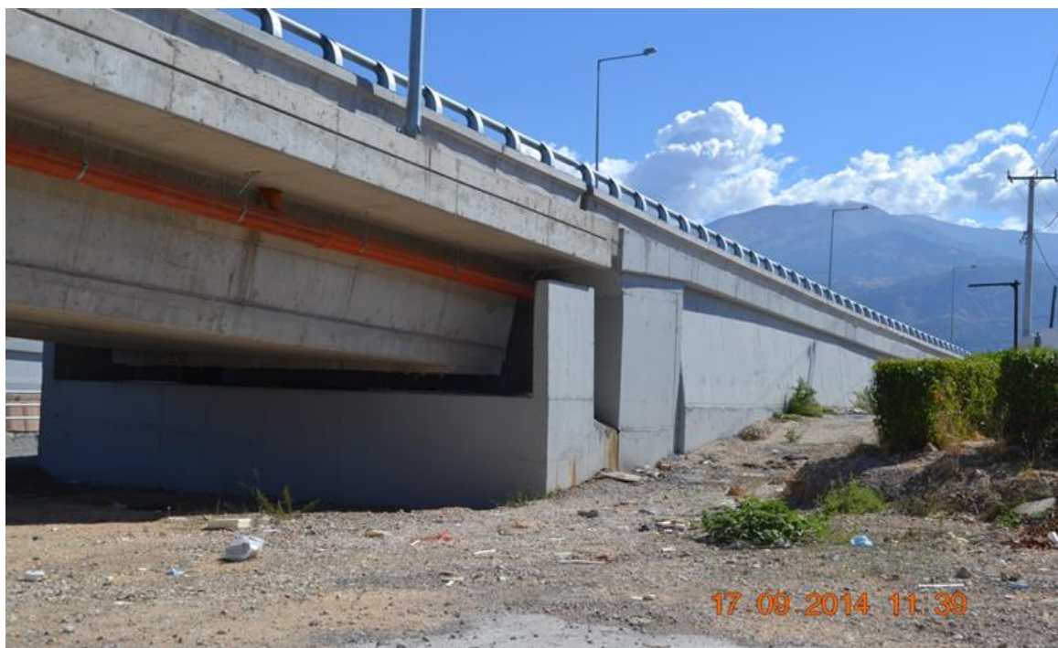
Φωτ. 6.16 Πλάγια όψη του ακρόβαθρου Α2Δ της παρούσας γέφυρας.
