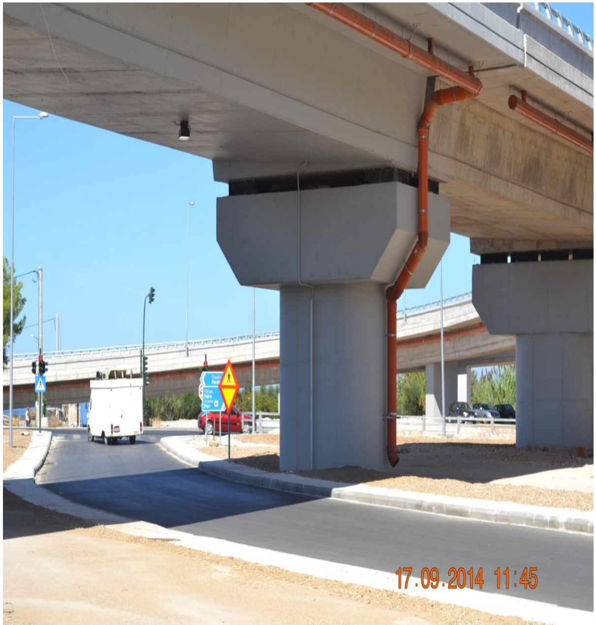
Φωτ. 6.6 Όψη του μεσόβαθρου Μ12Δ όπου διακρίνεται ο αγωγός υδροσυλλογής και τα εφέδρανα.
