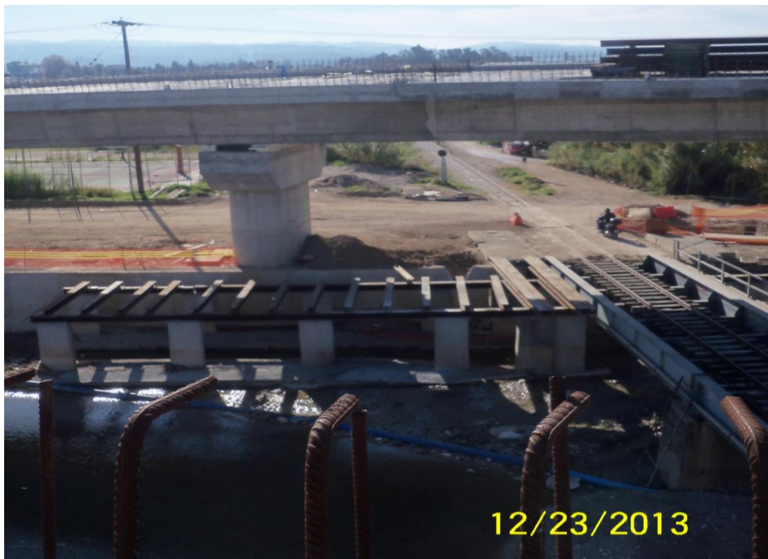
Φωτ. 6.3 Στάδια κατασκευής έργου. Φάση 2 (Αριστερά) - Φάση 3 (Δεξιά). Διακρίνεται το μεσόβαθρο M15Δ.
