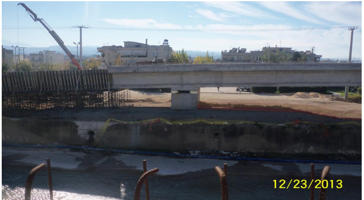
Φωτ. 6.4 Στάδια κατασκευής έργου. Φάση 6 (Αριστερά) - Φάση 1 (Δεξιά). Αριστερά: Παρατηρείται ο ξυλότυπος για την τοποθέτηση οπλισμού μεταξύ του ακρόβαθρου Α2Δ και του μεσόβαθρου Μ17Δ. Δεξιά: Διακρίνεται το μεσόβαθρο Μ17Δ.
