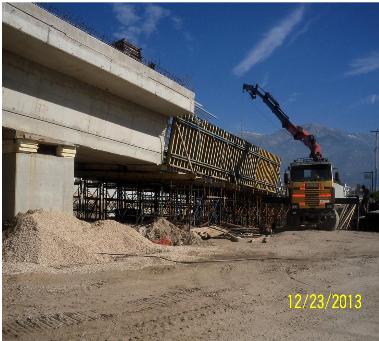
Φωτ. 6.15 Πλάγιες όψεις του μεσόβαθρου Μ17Δ καθώς και του ακρόβαθρου Α2Δ όπου διακρίνεται ο ξυλότυπος.
