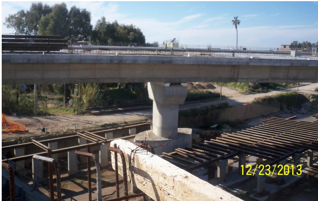
Φωτ. 6.2 Στάδια κατασκευής έργου. Φάση 3 (Αριστερά) - Φάση 4 (Δεξιά). Διακρίνεται το μεσόβαθρο M14Δ.
