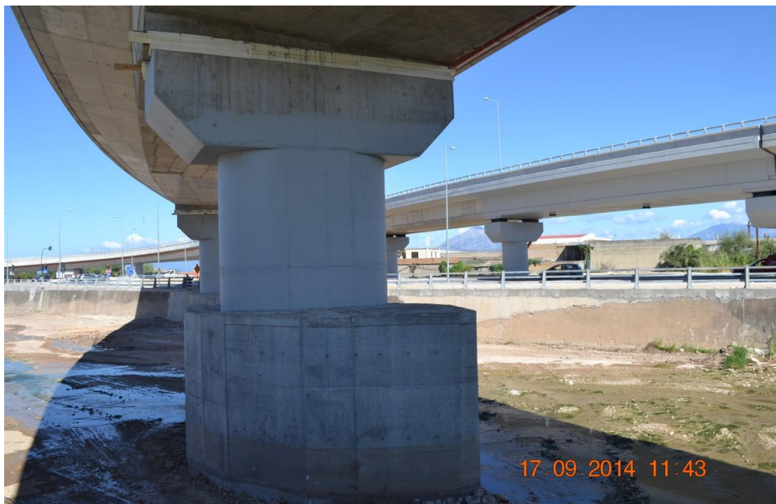
Φωτ. 6.9 Κατασκευή του μεσόβαθρου M14Δ. Παρατηρούμε την κατασκευή υποστηλώματος σε σχήμα βάρκας, για προστασία από την τυρβώδη ροή του νερού. Επίσης, διακρίνονται τα φελιζόλ εν αναμονή για την τοποθέτηση των εφεδράνων.
