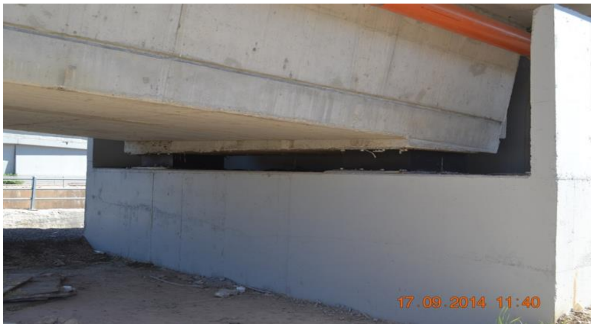
Φωτ. 6.17 Όψη του ακρόβαθρου Α2Δ όπου διακρίνονται τα εφάδρανα.
