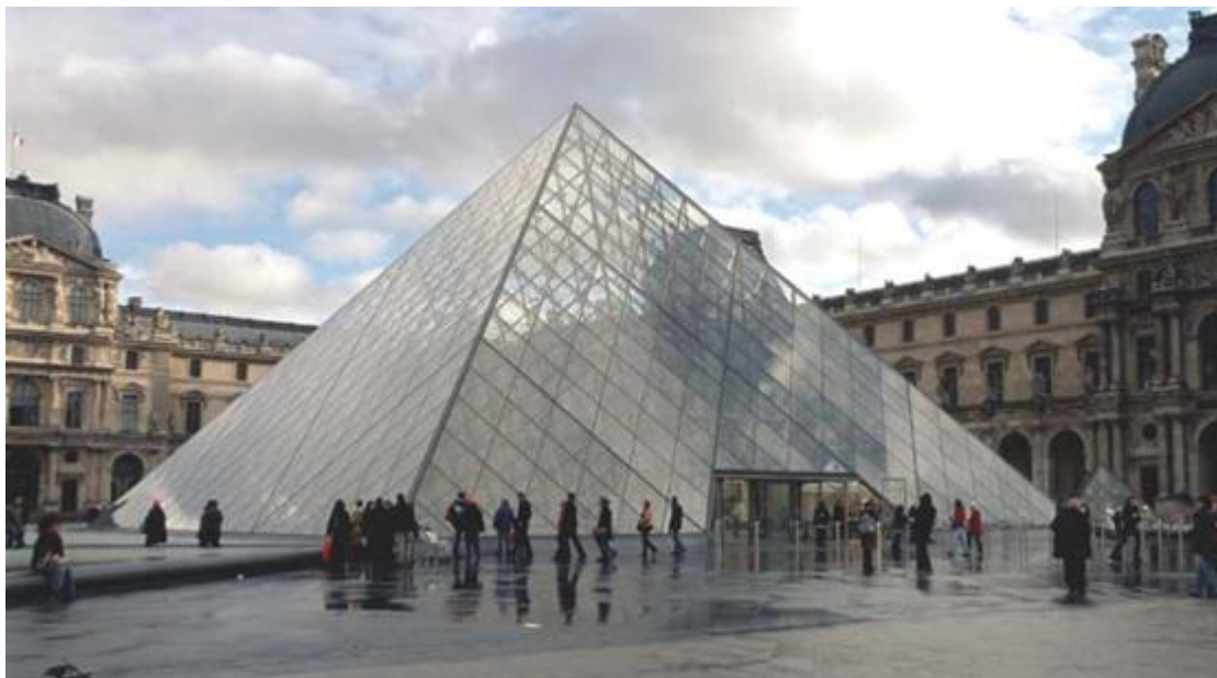
Εικόνα 19. Γυάλινες κατασκευές, Λούβρο, Γαλλία [5]
