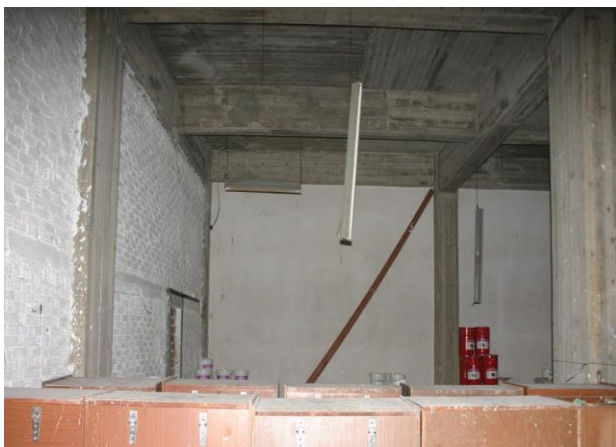
Εικόνα 34 Κτίριο A Ισόγειο
