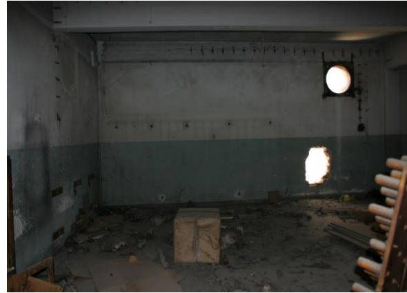
Εικόνα 37 Κτίριο Α Ισόγειο
