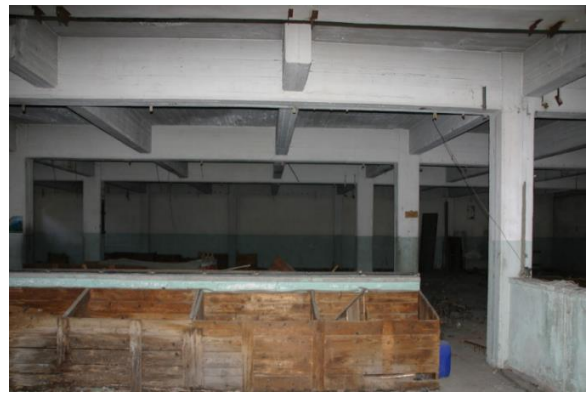
Εικόνα 31 Κτίριο Α 1 ος όροφος
