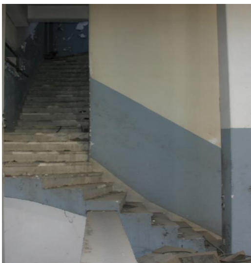
Εικόνα 38 Κτίριο Α Ισόγειο
