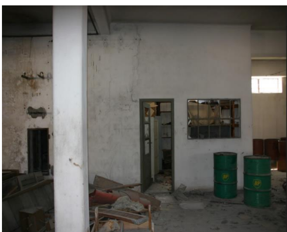
Εικόνα 40 Κτίριο Α Ισόγειο
