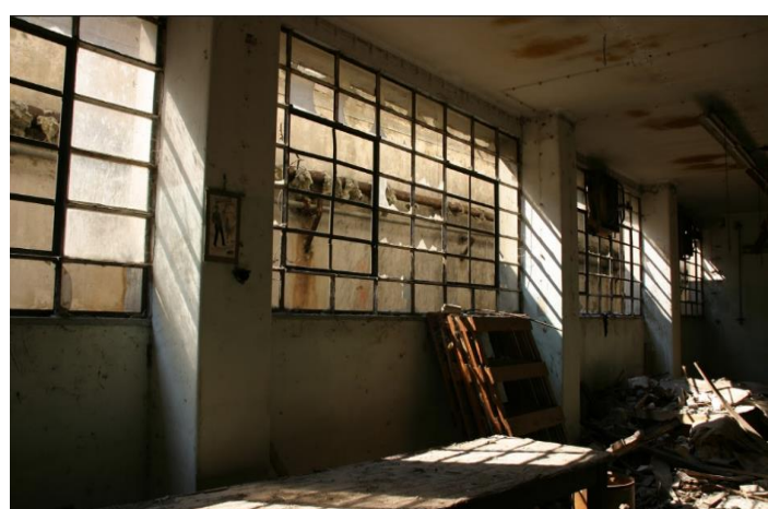
Εικόνα 55 Κτίριο Β Υπόγειο
