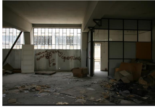
Εικόνα 59 Κτίριο Β Ισόγειο
