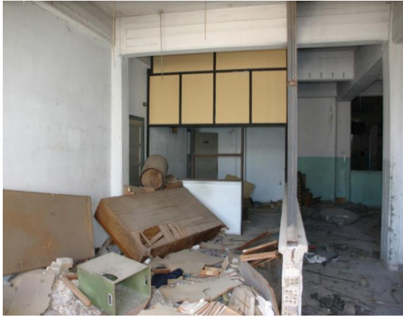
Εικόνα 42 Κτίριο Α 1 ος όροφος (χώρος γραφείων)
