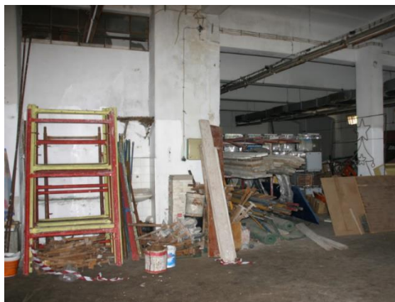
Εικόνα 33 Κτίριο A Ισόγειο
