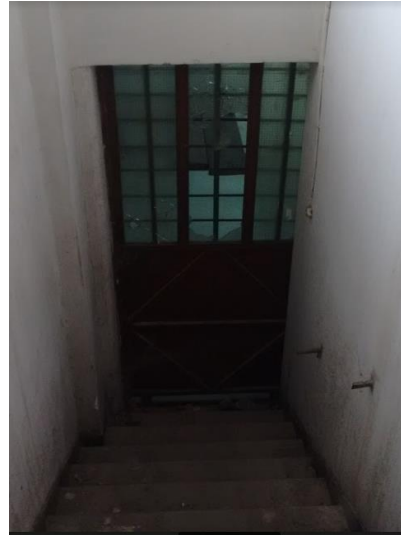
Εικόνα 76 Κτίριο Γ Ισόγειο
