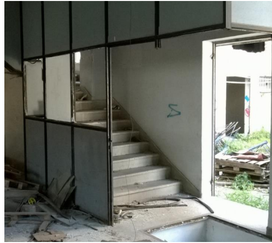
Εικόνα 57 Κτίριο Β Κλίμακα Ισογείου
