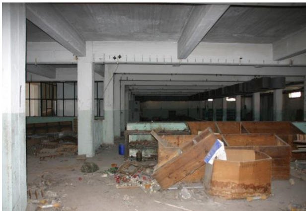
Εικόνα 32 Κτίριο A 1 ος όροφος
