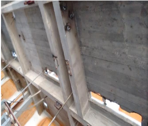
Εικόνα 84 Κτίριο Ε Όροφος Α΄
