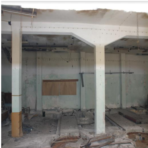
Εικόνα 50 Κτίριο Β Υπόγειο
