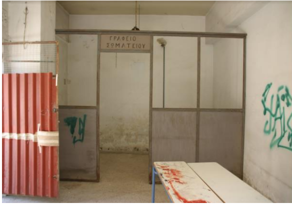
Εικόνα 58 Κτίριο Β Ισόγειο χώρος σωματείου
