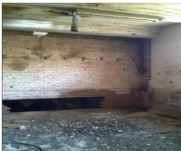
Εικόνα 97 Κτίριο Ε Όροφος Α
