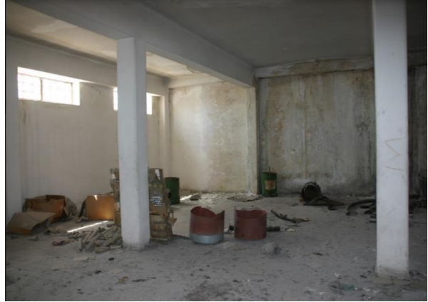
Εικόνα 29 Κτίριο Α 1 ος όροφος
