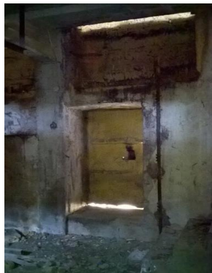
Εικόνα 91 Κτίριο Ε Ισόγειο
