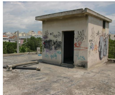
Εικόνα 69 Κτίριο Β Δώμα
