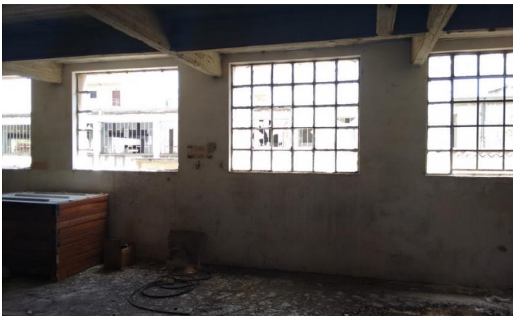
Εικόνα 90 Κτίριο Ε Όροφος Α
