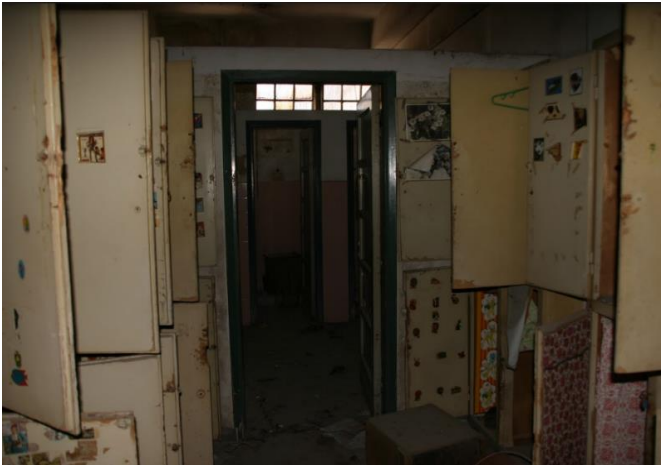
Εικόνα 44 Κτίριο Α 1 ος όροφος τουαλέτες γυναικών
