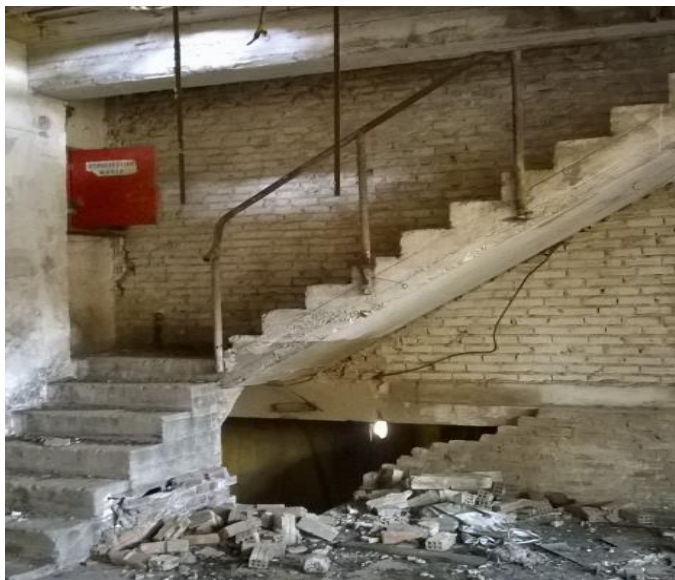
Εικόνα 92 Κτίριο Ε Όροφος Α
