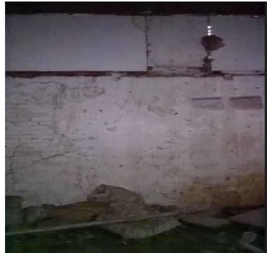
Εικόνα 87 Κτίριο Ε Ισόγειο
