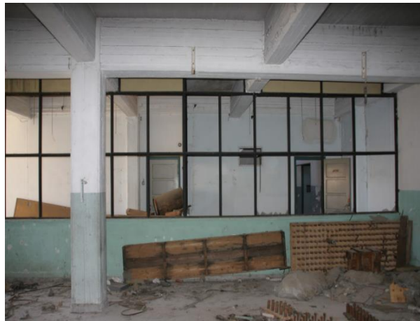
Εικόνα 43 Κτίριο Α 1 ος όροφος (χώρος γραφείων)
