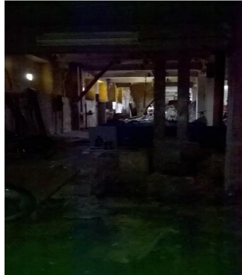
Εικόνα 85 Κτίριο Ε Ισόγειο
