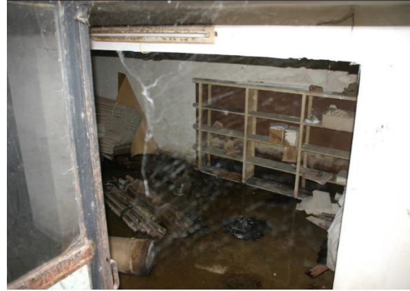
Εικόνα 66 Κτίριο Β Υπόγειο Β
