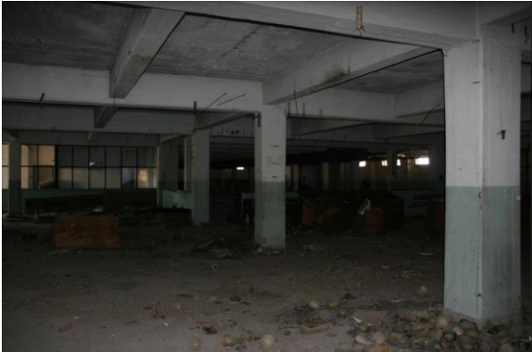
Εικόνα 30 Κτίριο Α 1 ος όροφος
