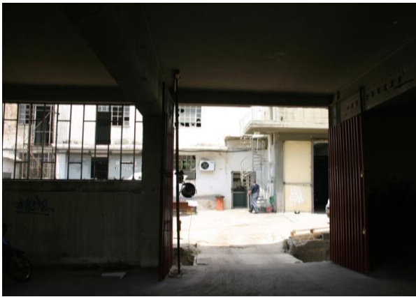
Εικόνα 52 Κτίριο Β Ισόγειο
