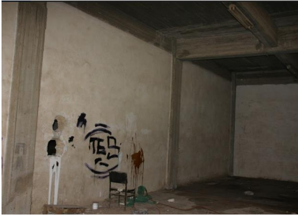
Εικόνα 36 Κτίριο Α 1 ος όροφος
