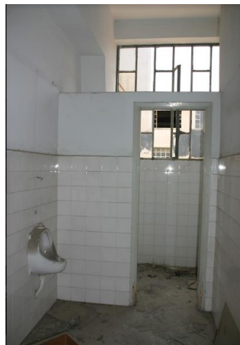
Εικόνα 68 Κτίριο Β Όροφος Α' WC
