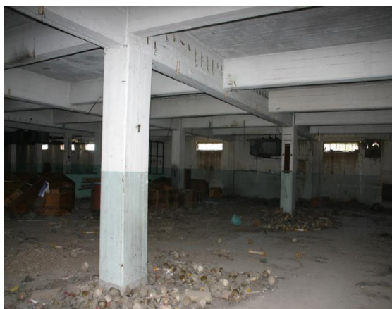
Εικόνα 35 Κτίριο A 1 ος όροφος
