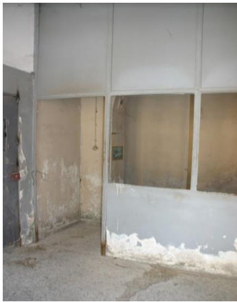
Εικόνα 60 Κτίριο Β χώρος φύλακα
