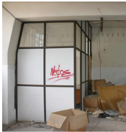
Εικόνα 61 Κτίριο Β Ισόγειο
