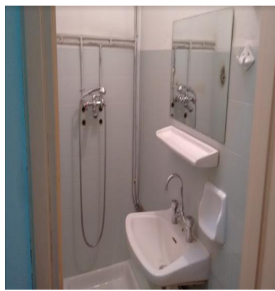
Εικόνα 80 Κτίριο Γ Ισόγειο WC
