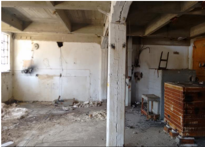
Εικόνα 82 Κτίριο Ε' Όροφος Α'
