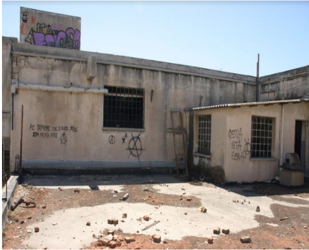
Εικόνα 46 Κτίριο A Δώμα
