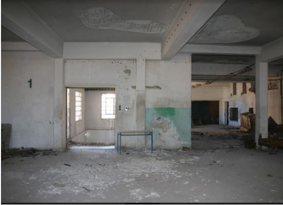
Εικόνα 28 Κτίριο Α 2 ος όροφος
