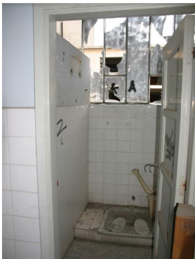
Εικόνα 67 Κτίριο Β Όροφος Α' WC
