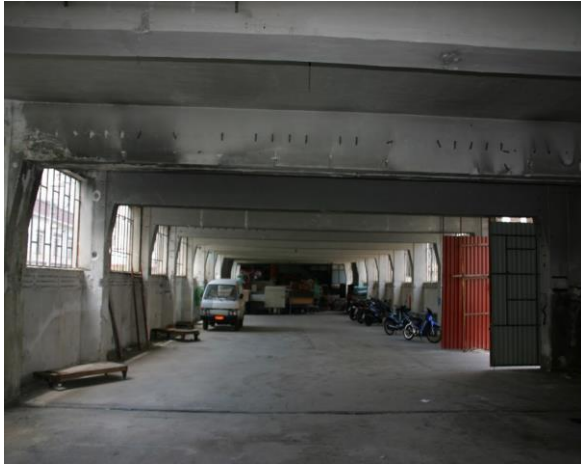
Εικόνα 48 Κτίριο Β Ισόγειο
