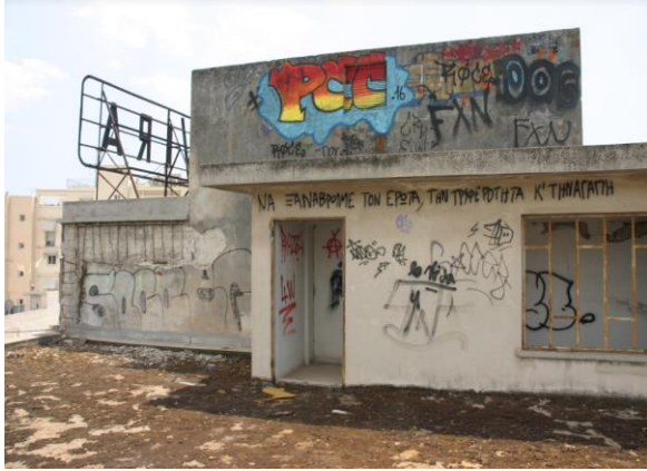
Εικόνα 65 Κτίριο Β Δώμα
