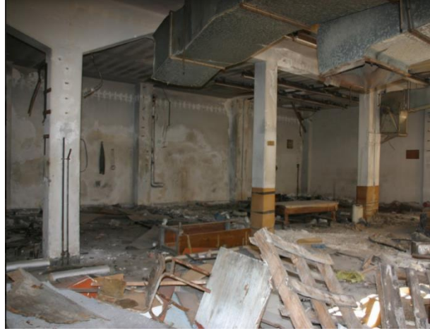
Εικόνα 49 Κτίριο Β Υπόγειο
