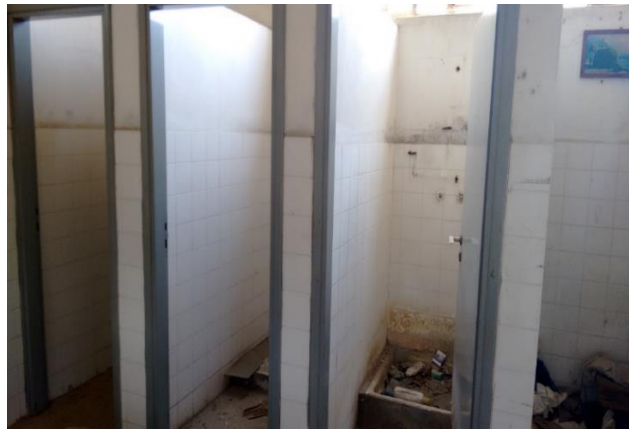
Εικόνα 78 Κτίριο Γ Όροφος Α' αποδυτήρια
