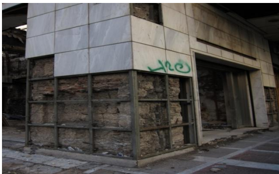
Εικόνα 17 - Φθορές εξωτερικής τοιχοποιίας
