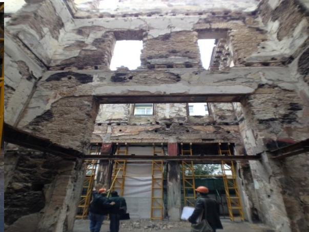
Εικόνα 12 - Τμήμα τοιχοποιίας (εσωτερική)
