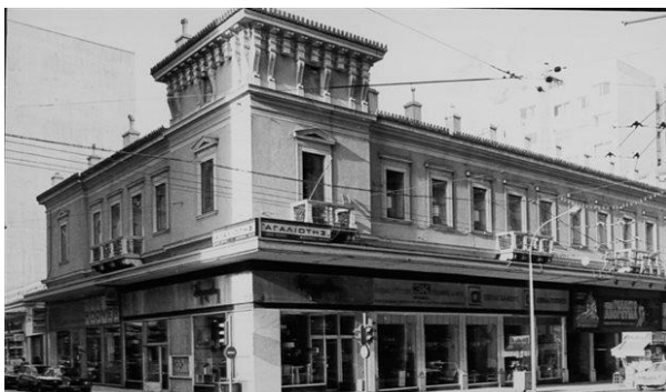
Εικόνα 1 - Άποψη κτηρίου πριν την καταστροφή του
