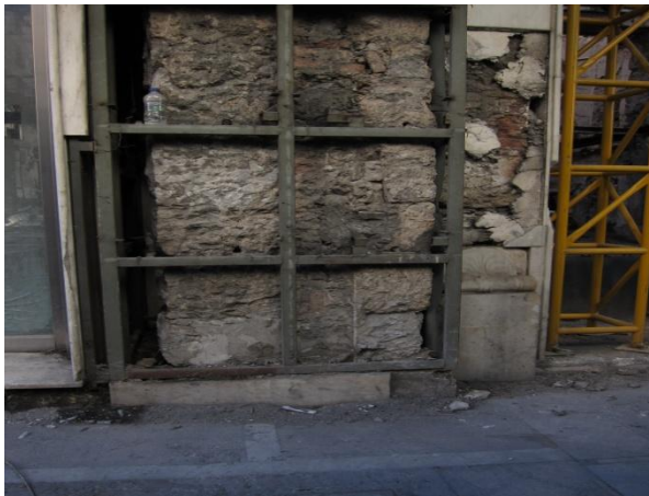
Εικόνα 11 – Τμήμα τοιχοποιίας (εξωτερική)
