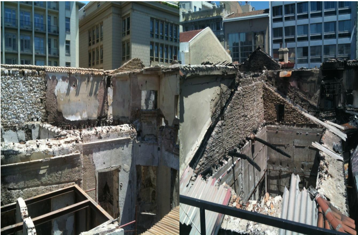
Εικόνα 53 - Άποψη τμήματος στέγης εκ των έσω.
