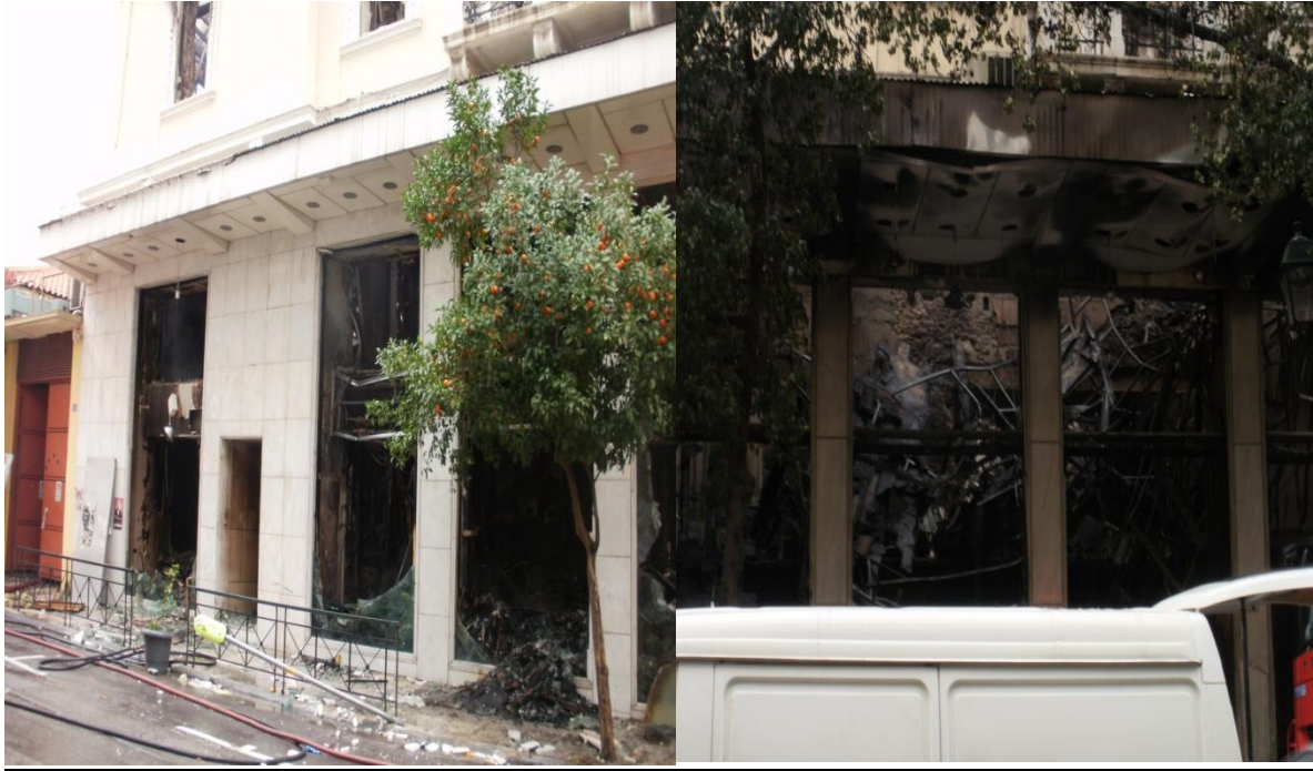
Εικόνα 31 α ,β - Άποψη εξωτερικών ανοιγμάτων ισόγειου.
