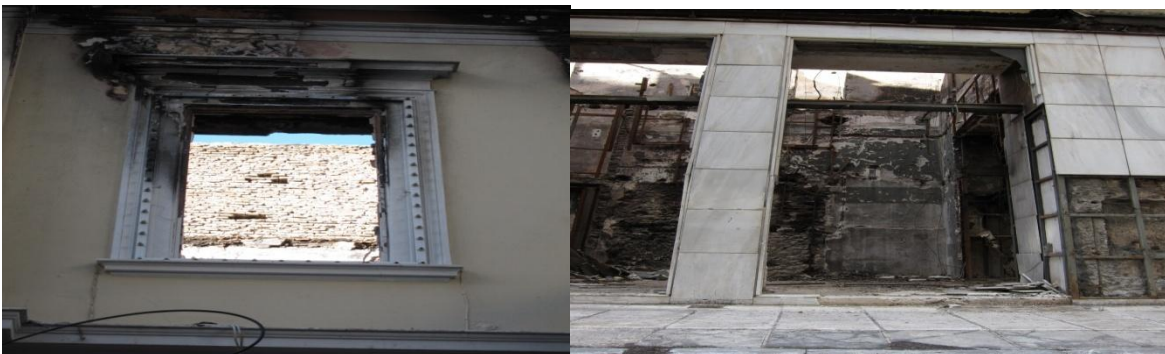
Εικόνα 16 A,B - Άποψη ανοιγμάτων
