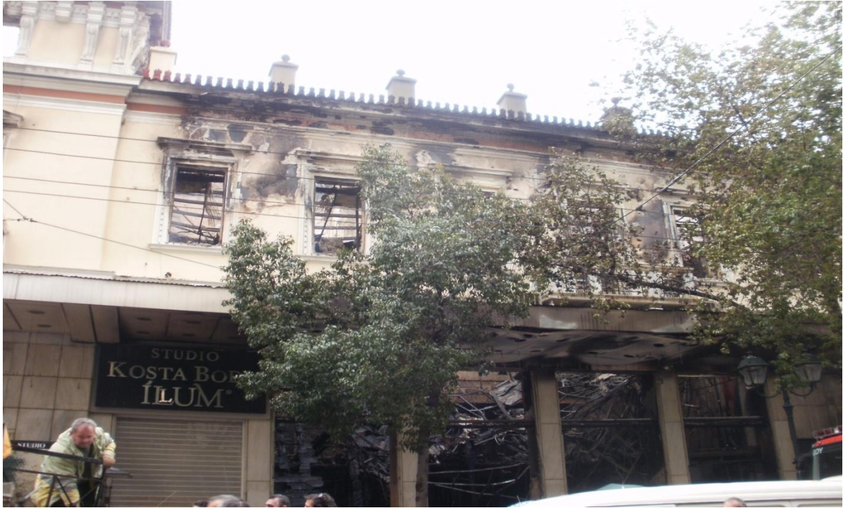
Εικόνα 30 Α ,Β - Όψη επί της οδού Σταδίου - πύργος.
