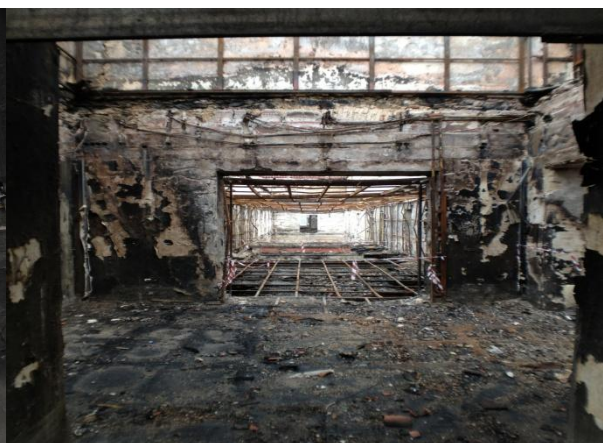
Εικόνα 14 - Άποψη δαπέδου στον Α' όροφο
