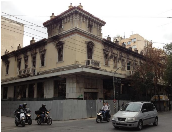
Εικόνα 3 - Άποψη κτηρίου (πύργος)
