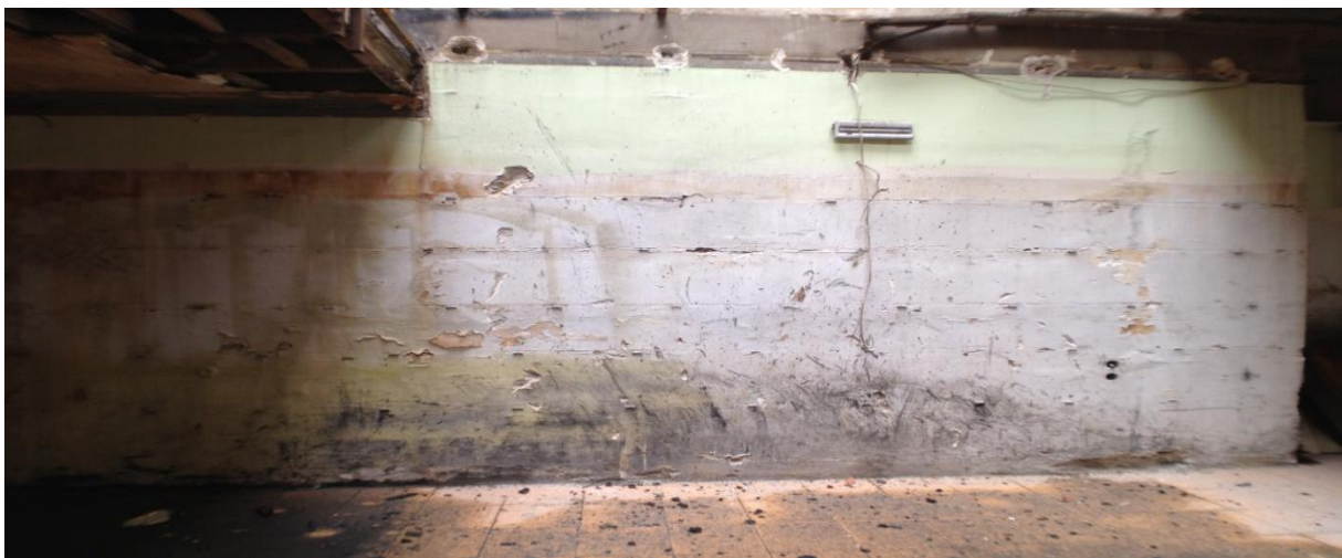
Εικόνα 22 - Τοιχοποιία με ένδειξη επένδυσης πλακιδίων
