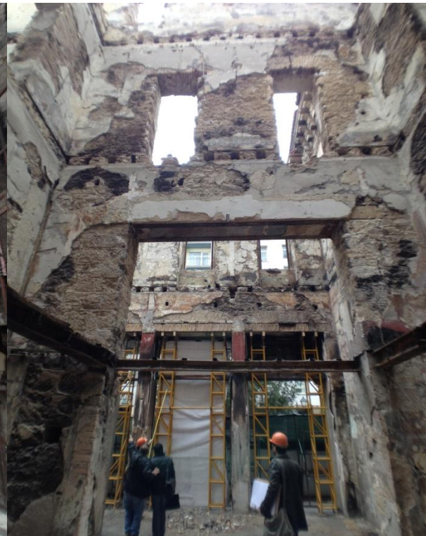
Εικόνα 35 - Άποψη τοιχοποιίας με στήριξη ικρωμάτων
