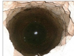
Διεύρυνση ανοίγματος ομοιόμορφα σε όλες τις κατευθύνσεις
