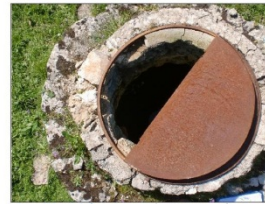
Αποκάλυψη λίθων και επιχρίσματος στο στόμιο
