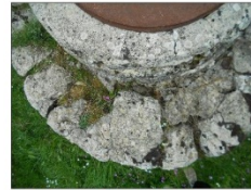
Επιφάνεια σπινθίου και βάσης - ρηγματώσεις (Απριλίου 2013)
