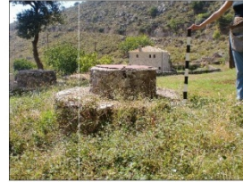
Επιφανές έδαφος/αποκόλληση επιχρίματος και ρηγματώσεις/αποκόλληση λίθων
