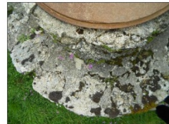
Σημείο επαφής βάσης και στομιού - Ρυγμές στο ταυνοσημείο (Απρίλιος 2013)
