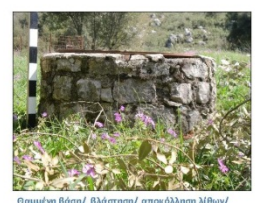
Θαμμένη βρύση/ βλάστηση/ αποκόλληση λίθων/ ρεγμάτωση τοιμενοκοινώματος
