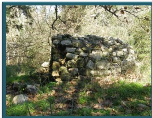
εικόνα 9. Πλάγια όψη πηγαδιού
