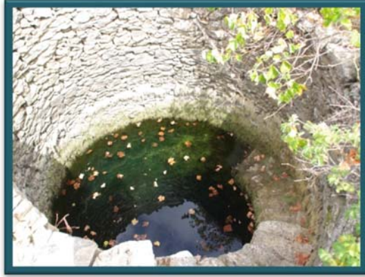
εικόνα 25. Το εσωτερικό του φρεατίου κατά τους καλοκαιρινούς μήνες.
