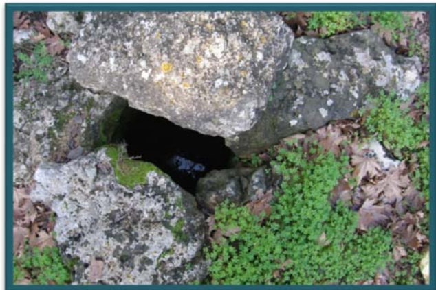
εικόνα 15. Το ανώτερο τμήμα έχει καταρεύσει και έχει απομείνει μία σπή στο έδαφος.
