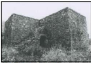
Οικόσι Τζαβέλα από την ανακατασκευή (2)
