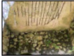
Ειδικός οπλισμός στην οροφή του πρώτου κλιμακίου (2)
