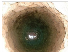
Τμήμα με βλάστηση εσωτερικά
