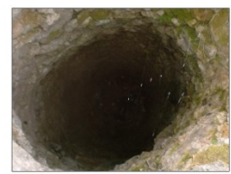
Διεύρυνση και βλάστηση
