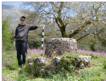
Ρηγμάτωση τσιμεντοκονιάματος/ Αποκόλληση λίθων/ Βλάστηση/ Απουσία λίθων
