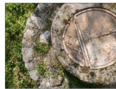
Έντονη βλάστηση, ρημάτωση ταμπενονομιάματος
