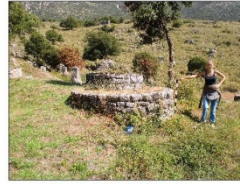
Εικόνα 72 Επισκεπτικές εδράφους (2) / αποσιδηλωμένη επιχρίσματα / αθίζωση εδάφους /
