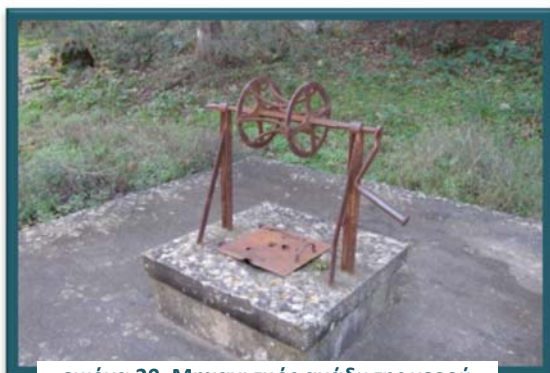
εικόνα 20. Μηχανισμός ανάδυσης νερού
