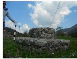
Αποσάρθρωση τετραγωνοκονιάματος/ρηγματώσεις
