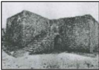
Οικόσι Τζαβέλα από την ανακατασκευή
