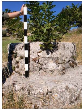
Ρηγμάτωση και αποκόλληση κονιάματος στην βάση και στο στόμιο
