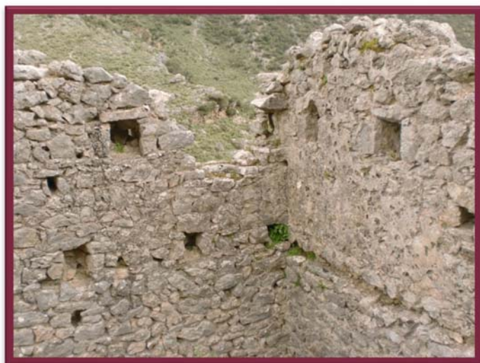
εικόνα 114. Τμήμα τοιχοποιίας κατοικίας Ζέρβα. Εμφανές ίχνος πλάκας.
