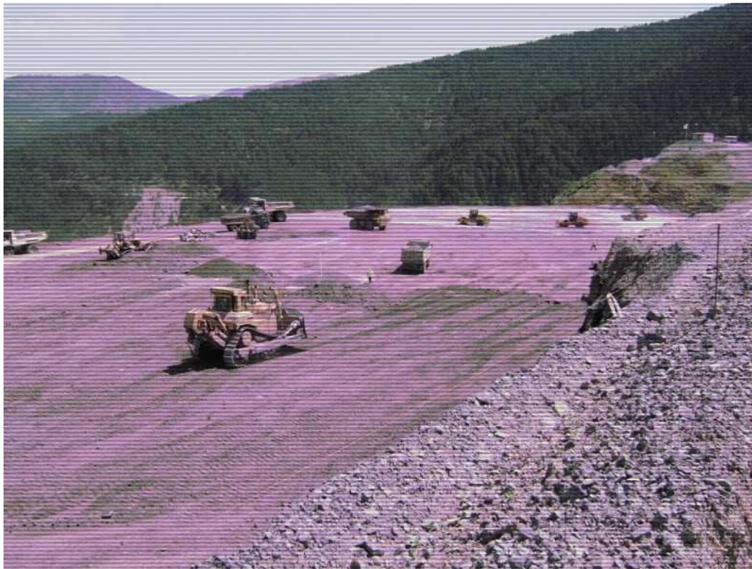
Εικόνα5: κατασκευή επιχώματος
