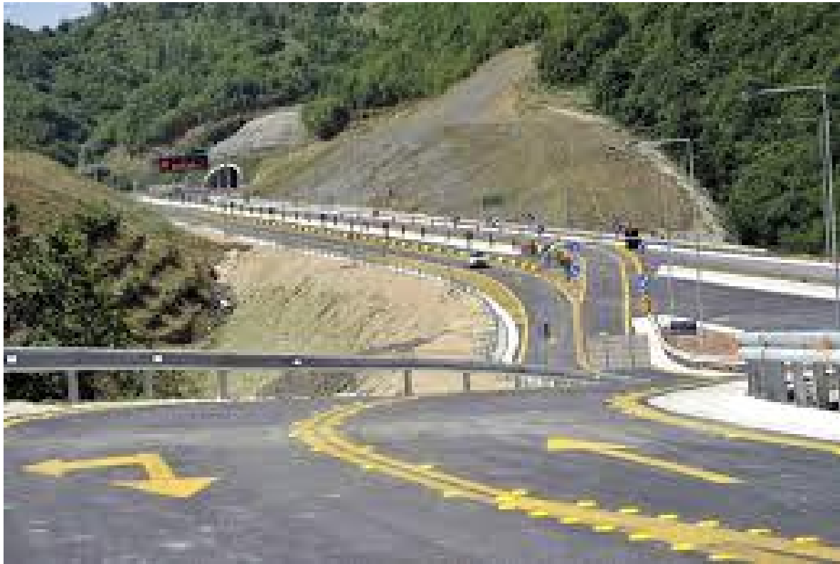
Εικόνα4: δρόμος σε επίχωμα
