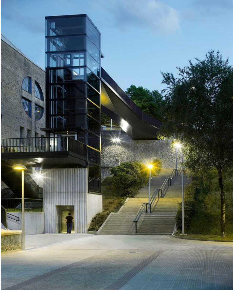
(Εικ. Ενδεικτική Σιδηροκατασκευή με υαλοστάσια που στεγάζει τον ανελκυστήρα και το κλιμακοστάσιο)
