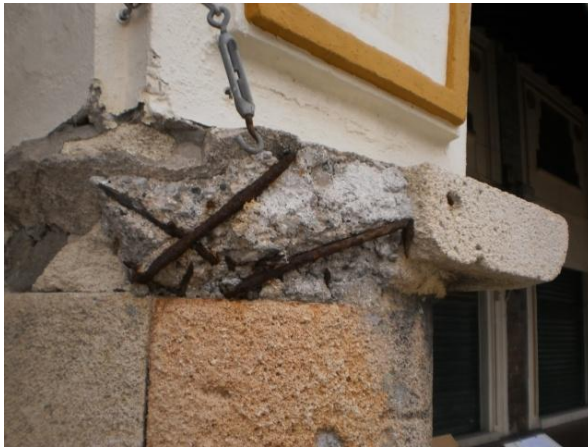
Εικόνα 48 (οξειδωμένος οπλισμός)
