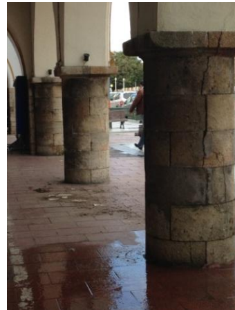
Εικόνα 49 (ρηγμάτωση πωρόλιθου)
