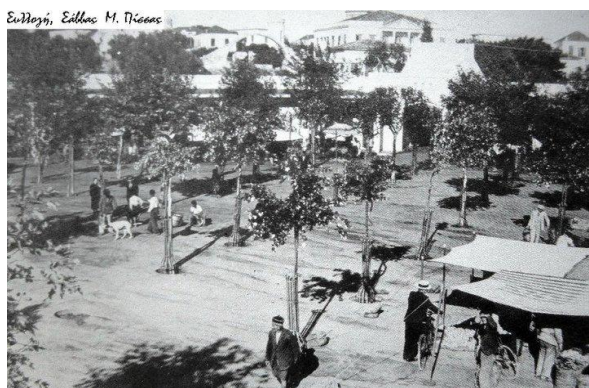
Εικόνα 16 (υπαίθριος χώρος στο εσωτερικό της Ν.Αγοράς)
