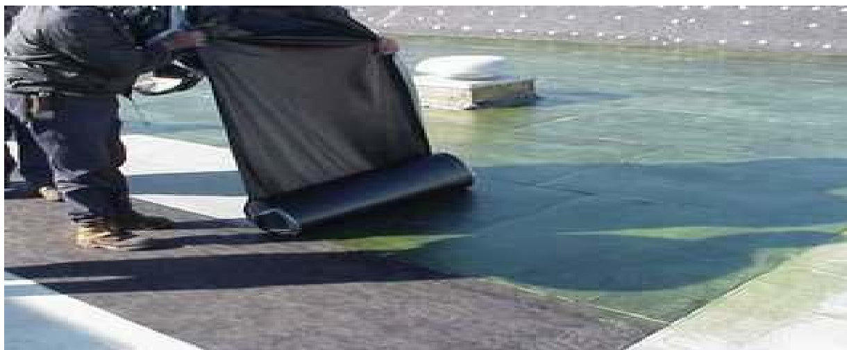
Εικόνα 8: Τοποθέτηση συνθετικής μεμβράνης σε ταράτσα
