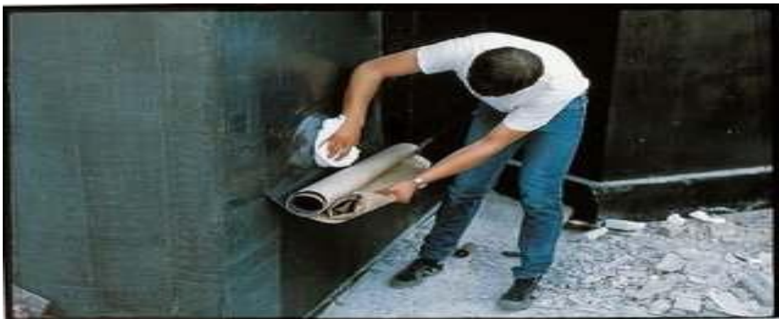
Εικόνα 7: Τοποθέτηση ασφαλτικής μεμβράνης σε τοίχο
