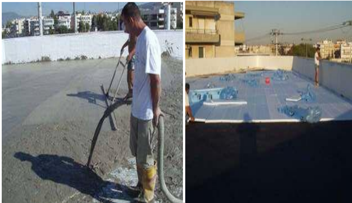
Εικόνα 4: Διαδικασία διαμόρφωσης ρύσεων και στεγανοποίησης σε ταράτσα
