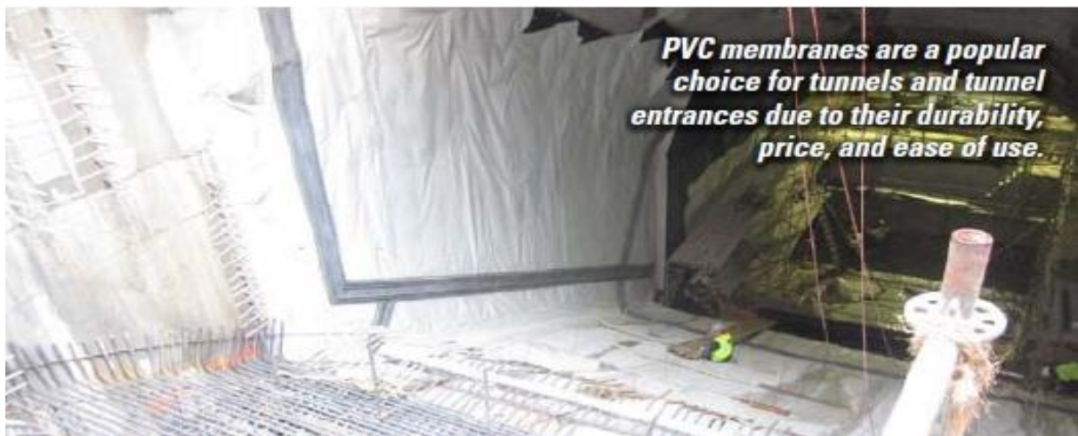
Εικόνα 11: Οι μεμβράνες PVC είναι μια δημοφιλής επιλογή για σήραγγες και εισόδους σηράγγων λόγω της αντοχής, της τιμής και της ευκολίας χρήσης τους.
