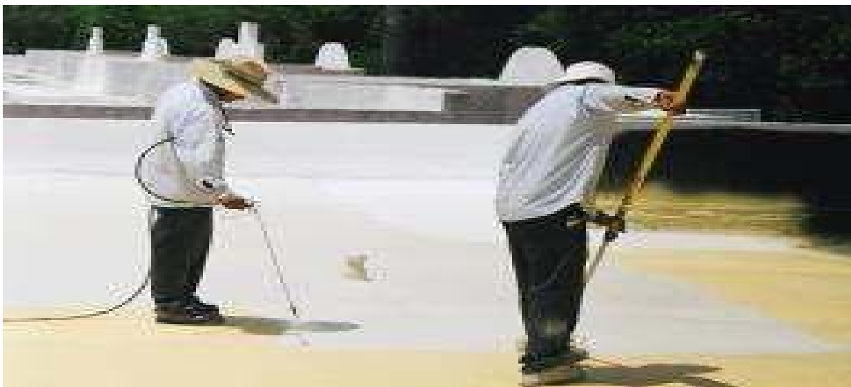
Εικόνα 6: Επίστρωση επαλειφόμενου στεγανωτικού υλικού σε ταράτσα
