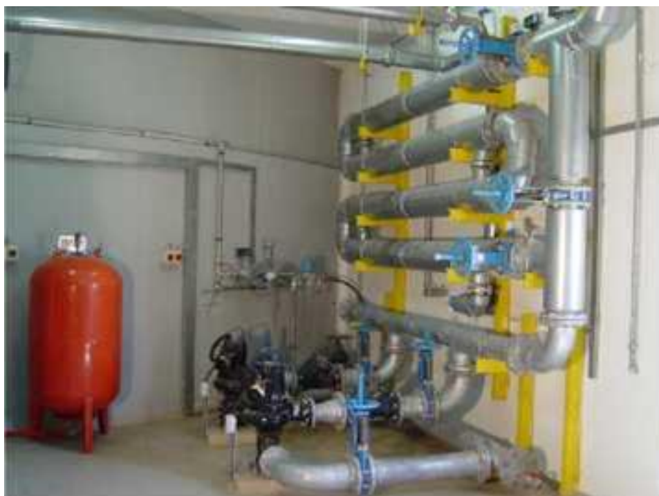
Εικόνα 41. Σύστημα θέρμανσης της ιλύος.
