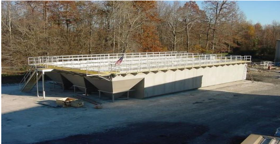
Εικόνα 24. Προκατασκευασμένες εγκαταστάσεις επεξεργασίας λυμάτων
