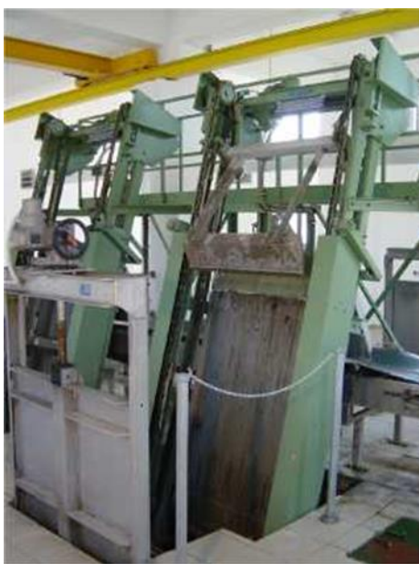
Εικόνα 34. Μηχανικά αυτοκαθαριζόμενες εσχάρες.
