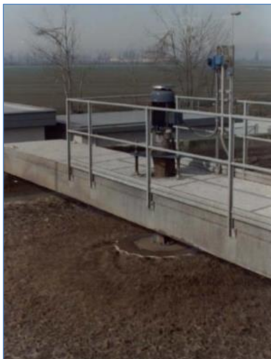
Εικόνα 12. Κατακόρυφοι Επιφανειακοί Αεριστήρες από Fiberglass
