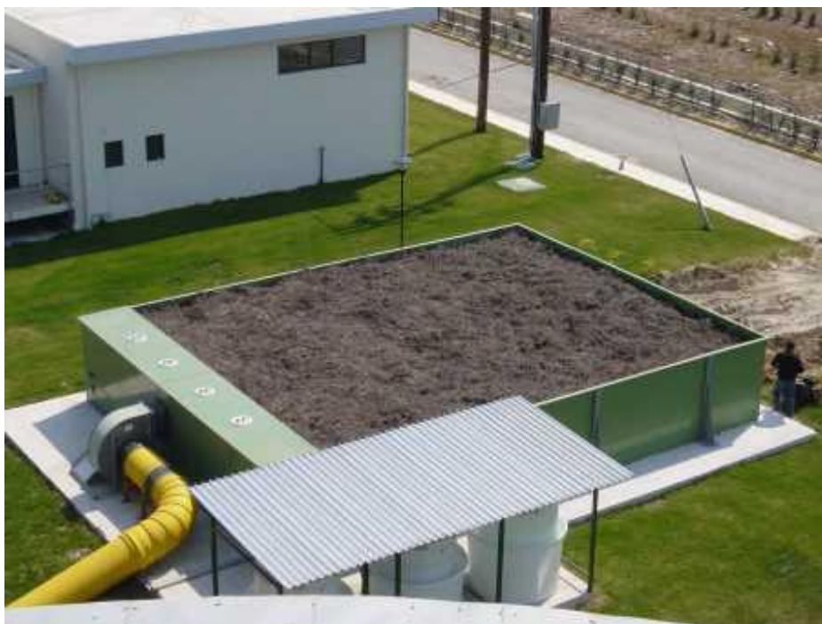
Εικόνα 42. Σύστημα απόσμησης
