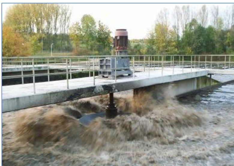
Εικόνα 13. Κατακόρυφοι Επιφανειακοί Αεριστήρες από Χάλυβα
