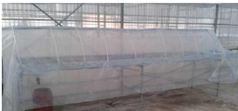
Κατασκευή ριζοτηρίου και υλικά που χρησιμοποιήθηκαν
