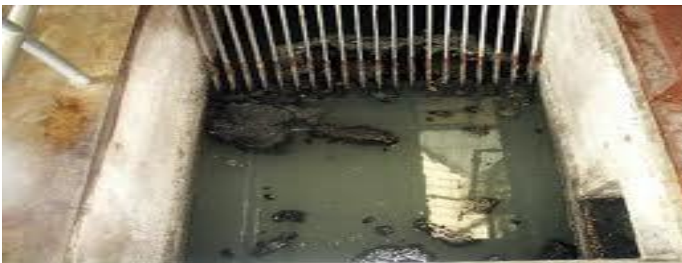
Εικόνα 2.3: Μη αεριζόμενος αγωγός με αυτοκαθαριζόμενη σήτα ( http://home.howstuffworks.com/home-improvement/plumbing/sewer3.htm )
