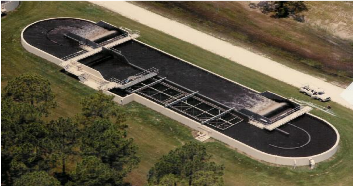
Εικόνα 2.40: Τάφρος οξείδωσης σε λειτουργία ( www.beardintl.com )
