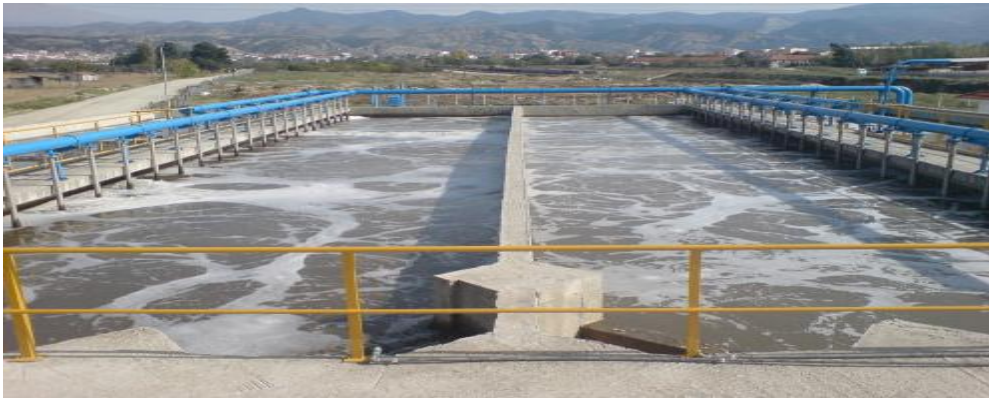
Εικόνα 2.9: Δεξαμενή αιώρησης με σταθερό και μεταβαλλόμενο αερισμό ( www.deyael.gr )
