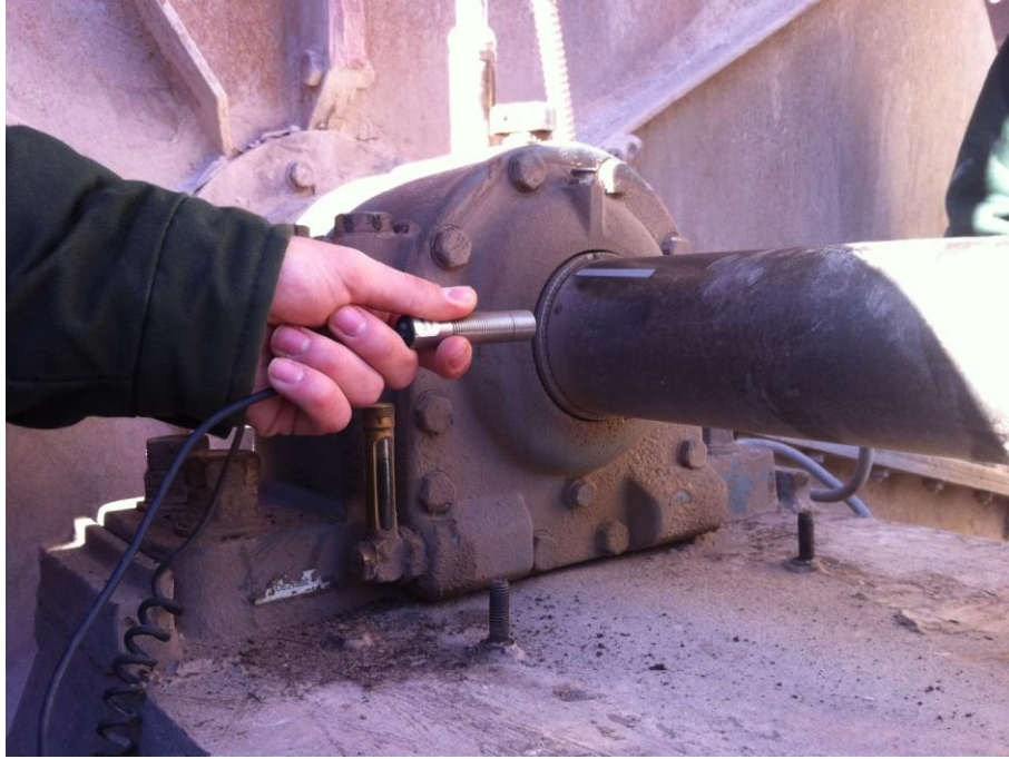
Εικόνα 3.6: Τοποθέτηση αισθητηρίου για την μέτρηση
