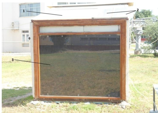
Εικόνα 1.2 : Νότια όψη ενεργειακού οικίσκου, τεχνολογίες ΑΠΕ στο κέλυφος του
