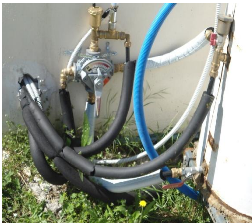
Εικόνα 1.16 : Τετράοδη βάνα μειξης νερού
