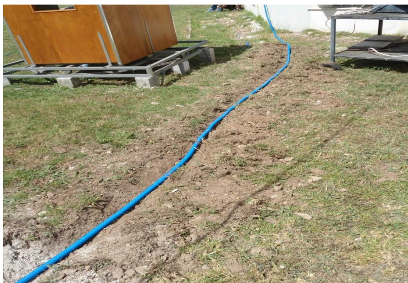
Εικόνα 1.32 : Τοποθέτηση καλωδίων Data Logger κάτω από το χώμα
