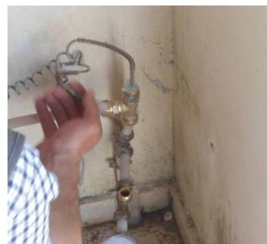
Εικόνα 1.29 : Τοποθέτηση θερμοζεύγους στην είσοδο του ενδοδαπέδιο
