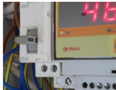
Εικόνα 1.25 : Τοποθέτηση ρελέ
