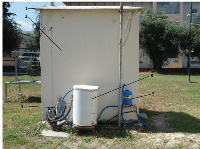
Εικόνα 1.1: Βόρεια όψη ενεργειακού οικίσκου
