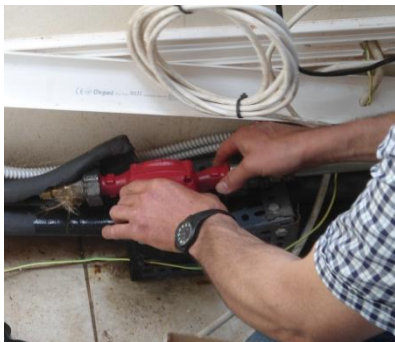
Εικόνα 1.26 : Τοποθέτηση νέου κυκλοφορητή ενδοδαπέδιας
