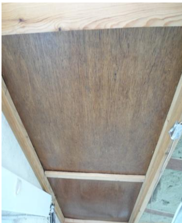
Εικόνα 7.6 : Προστατευτικό καπάκι φωτοβολταϊκών πλαισίων από το εσωτερικό του οικίσκου
