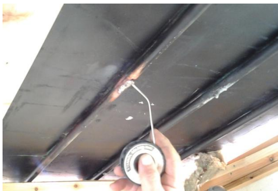
Εικόνα 5.9 : Επισκευές στον συλλέκτη της στέγης
