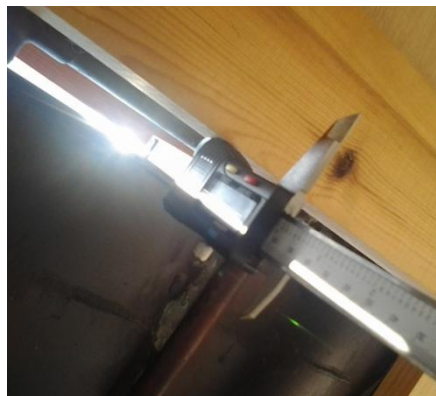
Εικόνα 5.6 : Μέτρηση απόστασης μεταξύ υαλοπίνακα και συλλεκτικής επιφάνειας ιδιοκατασκευής συλλέκτη στέγης
