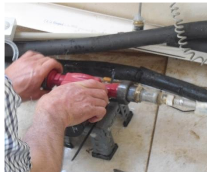
Εικόνα 1.27 : Τοποθέτηση νέου κυκλοφορητή συλλεκτών
