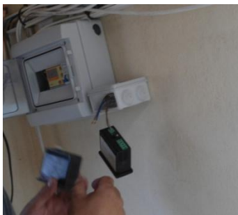
Εικόνα 1.24 : Αλλαγή αυτοματισμού λειτουργίας
