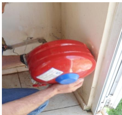
Εικόνα 1.28 : Αποσύνδεση δοχείου διαστολής ενδοδαπέδιας
