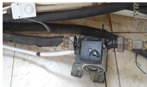
Εικόνα 1.6 : Κυκλοφορητής συλλεκτών
