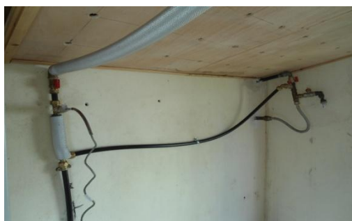
Εικόνα 1.10 Συνδεσμολογία συλλεκτών
