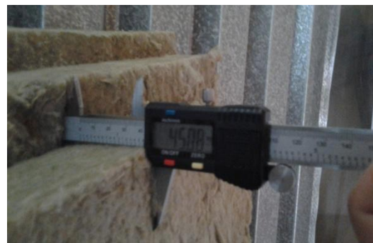
Εικόνα 5.8 : Μόνωση συλλέκτη στέγης οικίσκου
