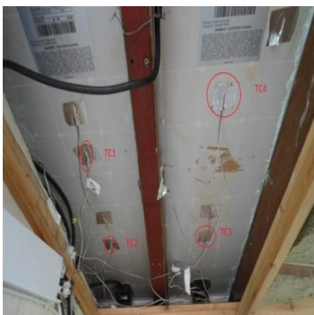
Εικόνα 7.8 : Τοποθέτηση θερμοζευγών στην πίσω όψη των φωτοβολταϊκών πλαισίων
