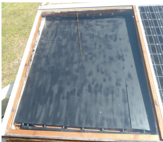
Εικόνα 5.1 : Καθαρισμός συλλέκτη στέγης του Ενεργειακού οικίσκου
