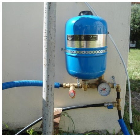
Εικόνα 1.17 : Δοχείο διαστολής – αυτόματος πλήρωσης – βαλβίδα ασφαλείας
