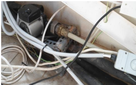
Εικόνα 1.5 : Κυκλοφορητής ενδοδαπέδιας θέρμανσης
