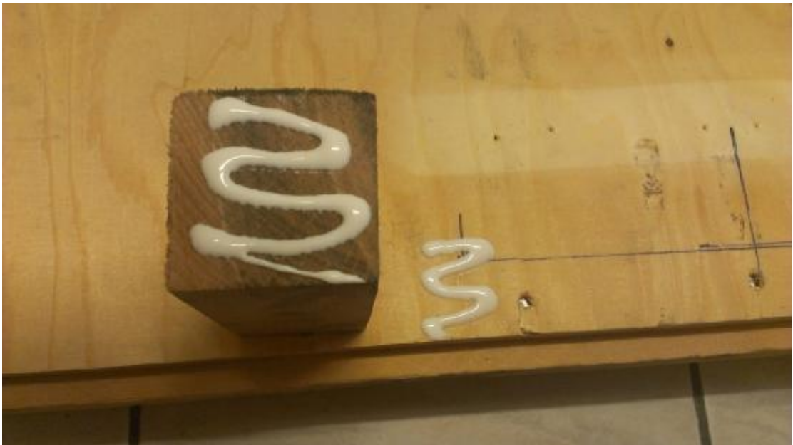
Εικόνα 4.4 Κόλληση ποδιών στην βάση
