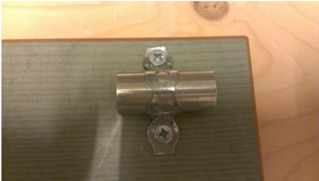
Εικόνα 4.9 Τοποθέτηση οδηγών στην σεισμική πλάκα
