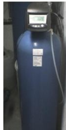
Μονός ογκομετρικός αποσκλήρυντής οικιακής εγκατάστασης
