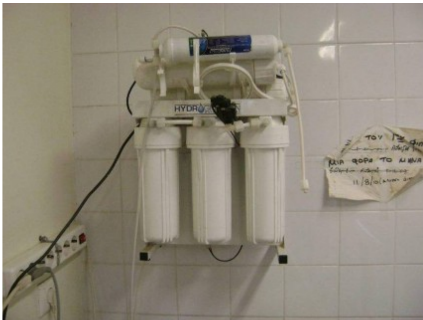
Εικόνα 27: Διάταξη Αντίστροφης Ωσμωσης των 5 σταδίων.
