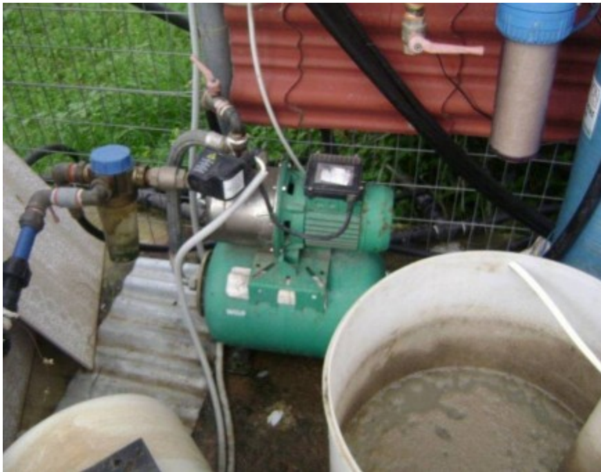
Εικόνα 17: Αντλία WILO, μοντέλο Wilo-MultiPress HMP 305.
