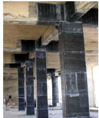
Παράδειγμα επισκευής με χρήση ανθρακονημάτων
