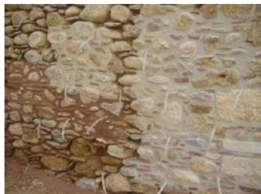
Διαδικασία εφαρμογής υδραυλικών ενεμάτων
