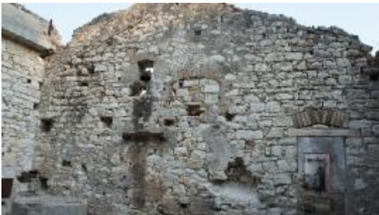
Αποσάρθρωση κονιάματος συνδετικού αρμού
