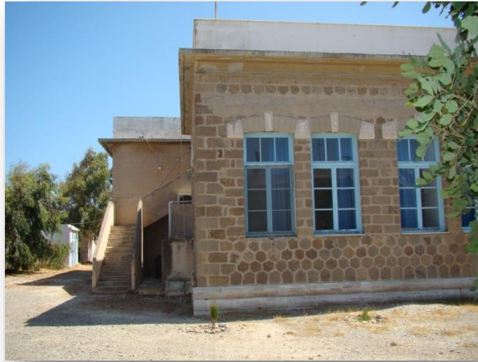
Εικόνα 48: Φ.Δ.1.1. Άποψη του κεντρικού κλιμακοστασίου αλλά και μέρος της Δυτικής Όψης.
