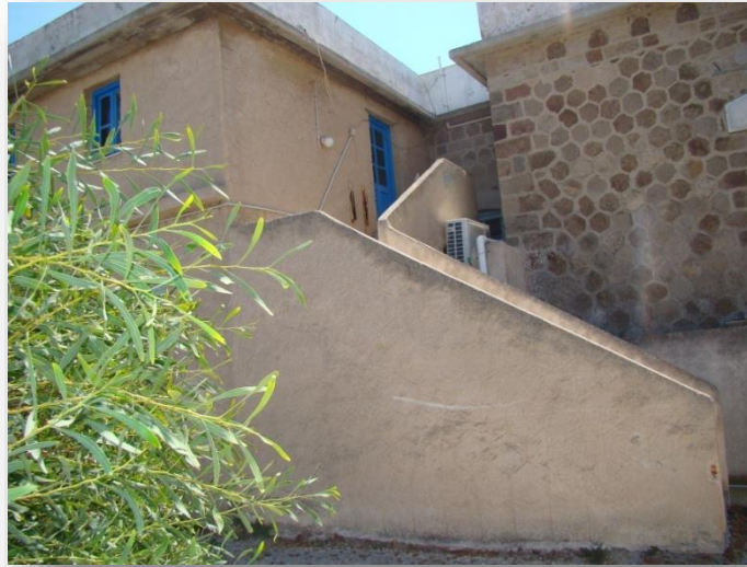
Εικόνα 46: Φ.ΠΟ.1.7.Το κεντρικό κλιμακοστάσιο που βρίσκεται στην Πίσω Όψη.
