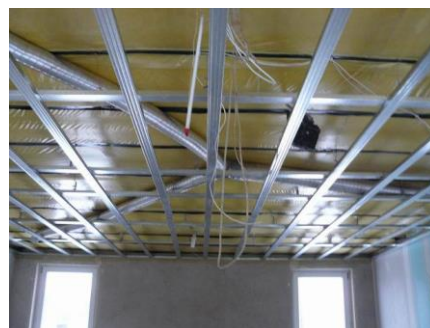
Εικόνα 28:Άποψη του μεταλλικού σκελετού που θα τοποθετηθεί στην οροφή ώστε στη συνέχεια να γίνει η τοποθέτηση των γυψοσανίδων.
