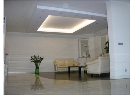
Εικόνα 29: Άποψη της οροφής με γυψοσανίδα και κρυφό φωτισμό.
