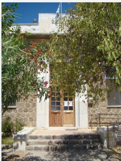
Εικόνα 34: Φ.ΠΡ.1.5.Κεντρική θύρα στην Πρόσοψη του κτιρίου.
