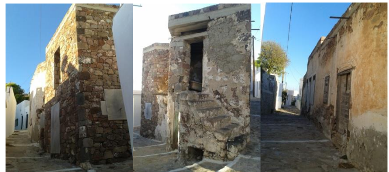
Εικόνα 19: Διατηρητέο κτίριο που στέγαζε το αστυνομικό τμήμα στο παρελθόν.
