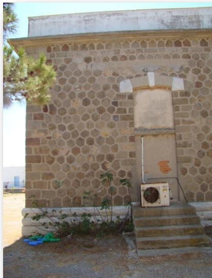
Εικόνα 40: Φ.ΠΟ.1.1. Πίσω όψη του κτιρίου όπου γίνεται ορατό το ίχνος ανοίγματος θύρας.
