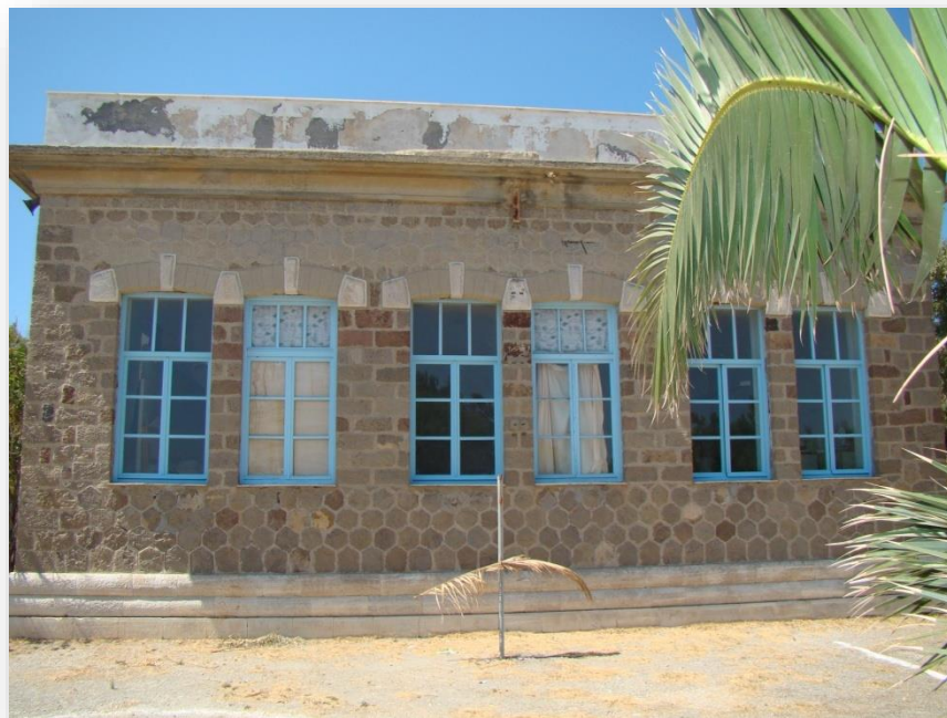
Εικόνα 39: Φ.Α.1.2.Συνέχεια της Ανατολικής όψης του κτιρίου.
