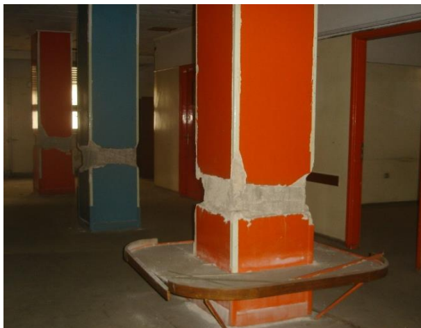
Εικόνα 33-35: Εργαστηριακοί έλεγχοι στα υποστυλώματα
