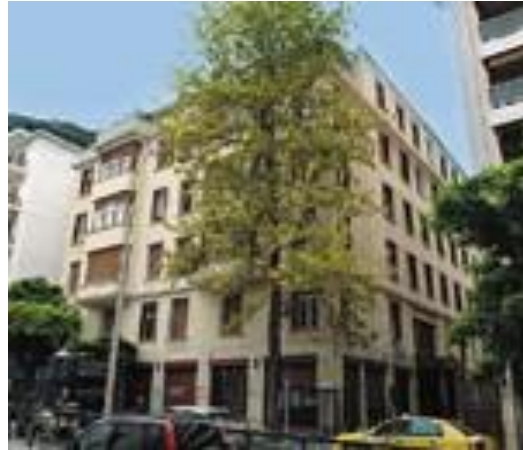
Εικόνα 7: Πολυκατοικία στην οδό Μπουμπουλίνας 20-22
