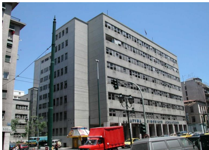
Εικόνα 5: Άποψη κτηρίου από πλατεία Κουμουνδούρου
