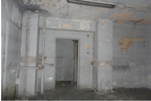
Εικόνα 36-37: Αποφλοιώσεις τοιχοποιιών
