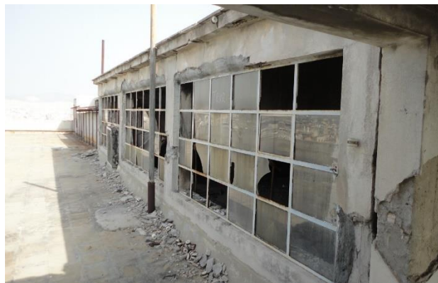
Εικόνα 13: Κτιστό τμήμα μηχανοστασίου δώματος
