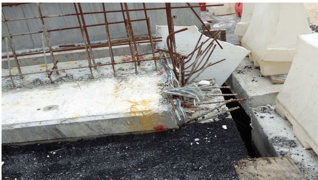
Φωτ. 6.10 Οπλισμός BSt 500S με πλέγμα για την κατασκευή στηθαίου ασφάλειας.
