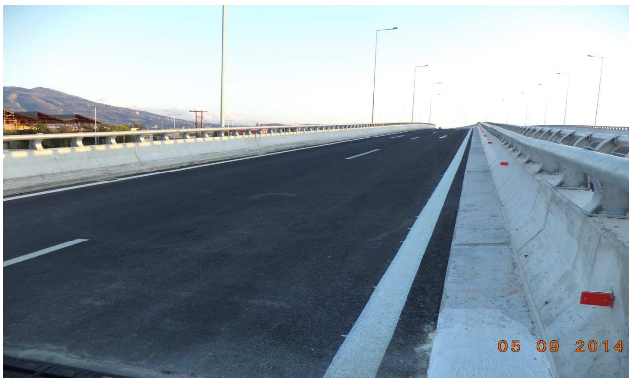
Φωτ. 6.9 Οδόστρωμα τμήματος γέφυρας T6 (μετά την ασφαλτόστρωση).
