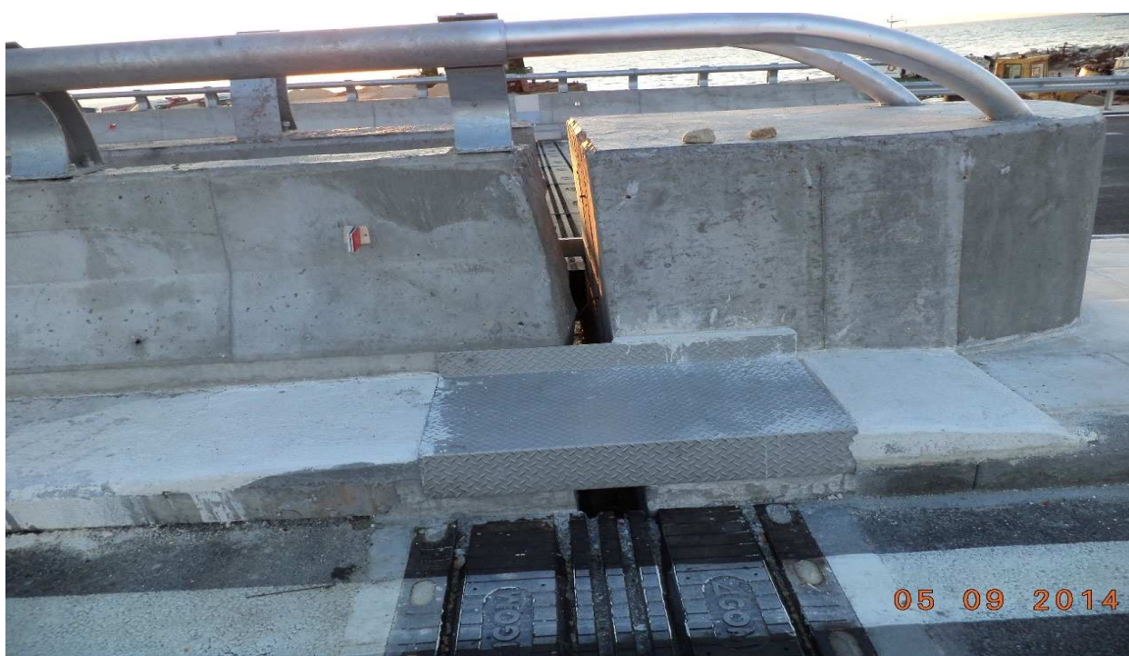
Φωτ. 6.11 Όψη στηθαίου από σκυρόδεμα, κιγκλίδωμα και ελαστική καλύπτρα του αρμού διαστολής.
