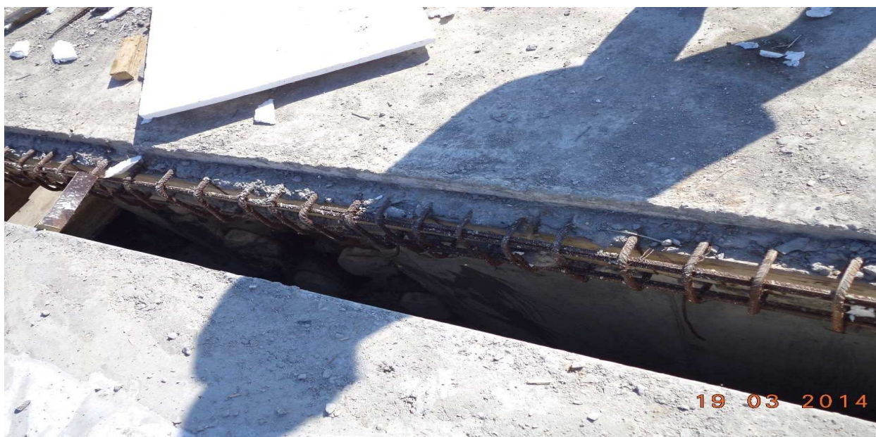
Φωτ. 6.14 Αρμός διαστολής με εμφανή τον σιδηρό σπλισμό BSt 500S, όπου εσωτερικά φαίνεται το σύστημα προέντασης.
