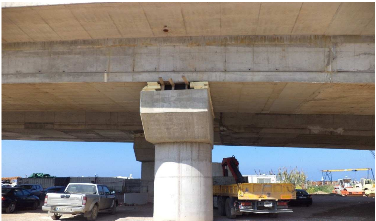
Φωτ. 6.5 Μεσόβαθρο M3.A κυκλικής διατομής με κεφαλοδοκό (πριν την αφαίρεση των προσωρινών στηριγμάτων του εφεδράνου).
