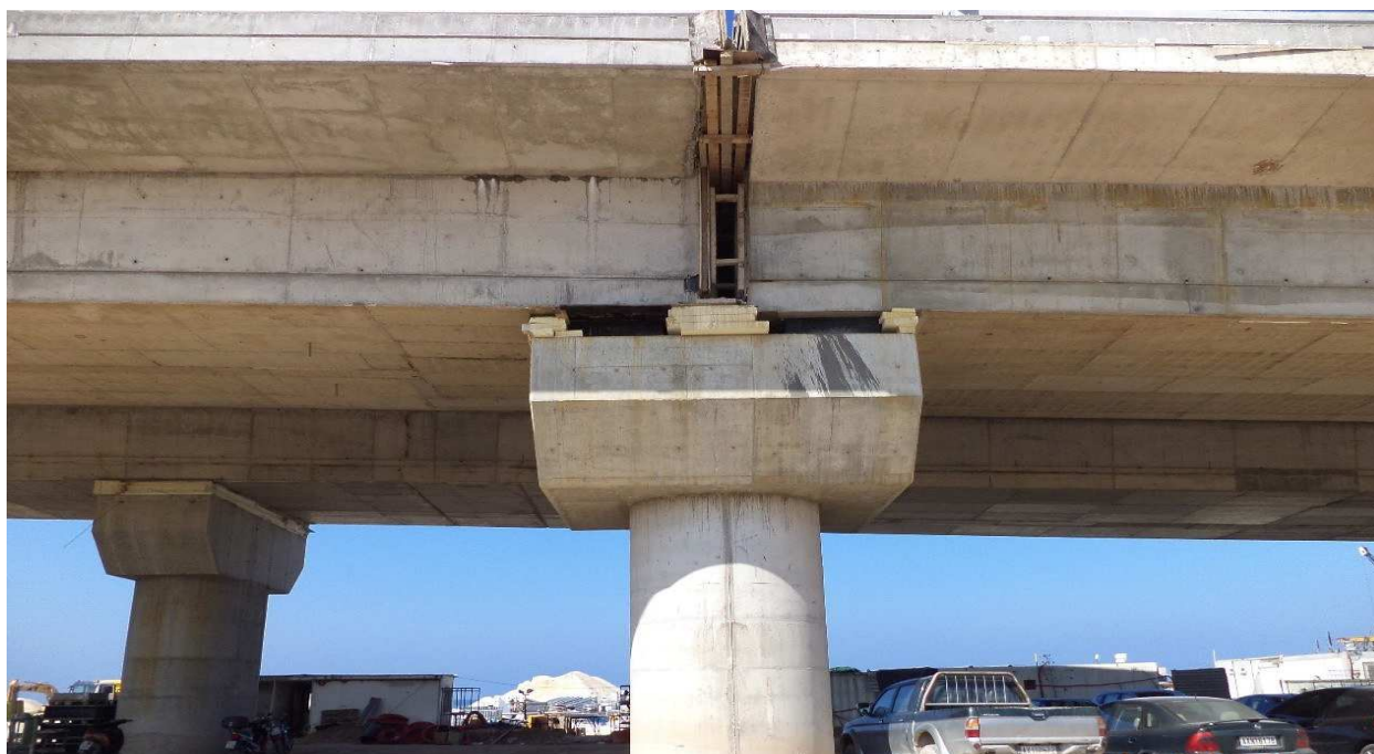
Φωτ. 6.6 Μεσόβαθρο M4.A κυκλικής διατομής με κεφαλοδοκό (πριν την αφαίρεση των προσωρινών στηριγμάτων του εφεδράνου) και αρμός διαστολής της σύνδεσης με τη γέφυρα T7 στα αριστερά.
