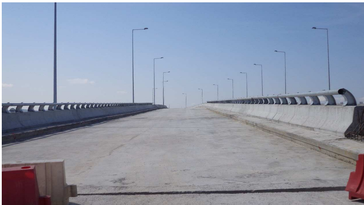
Φωτ. 6.8 Οδόστρωμα τμήματος γέφυρας T6 όπου φαίνονται οι αρμοί διαστολής (πριν την ασφαλτόστρωση).
