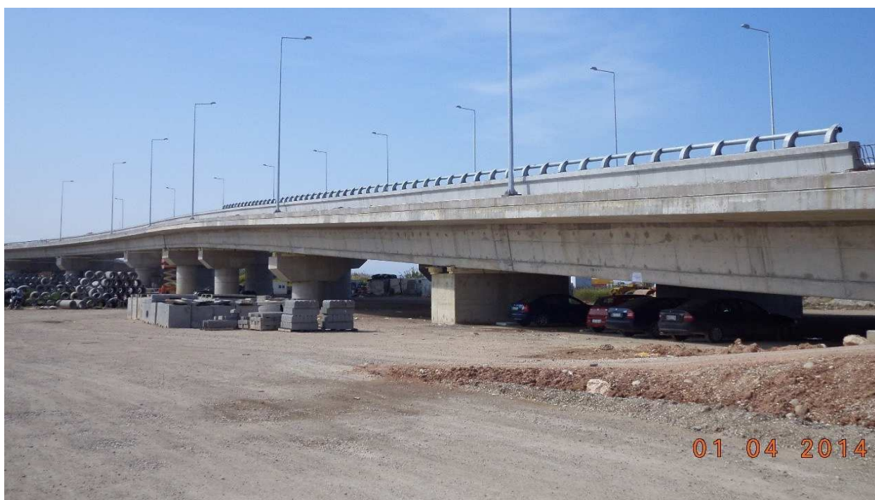
Φωτ. 6.7 Δυτική όψη παρούσας γέφυρας T6 (και μέρος της γέφυρας T7, αριστερά του αρμού) και όψη όλων των βάθρων αυτής (M1.A, M2.A, M3.A, M4.A).
