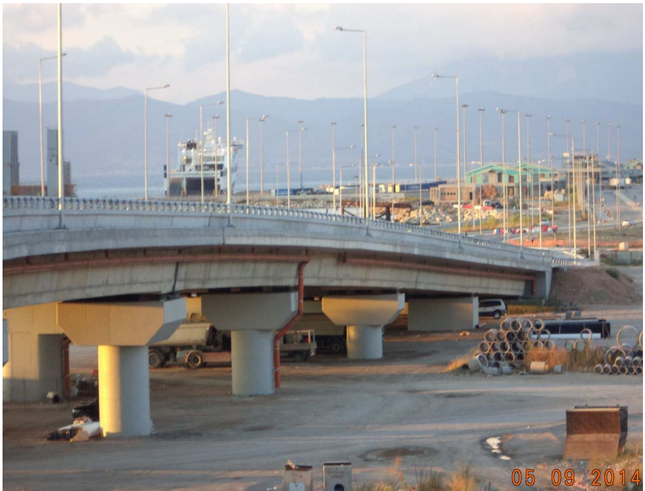
Φωτ. 6.1 Γενική όψη γέφυρας T6 και βάθρων.
