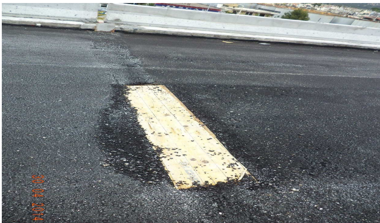
Φωτ. 6.15 Αρμός διαστολής με κάλυψη ασφαλτικού τάπητα με ΠΤΠ Α265 (κυκλοφοριακός τάπητας).
