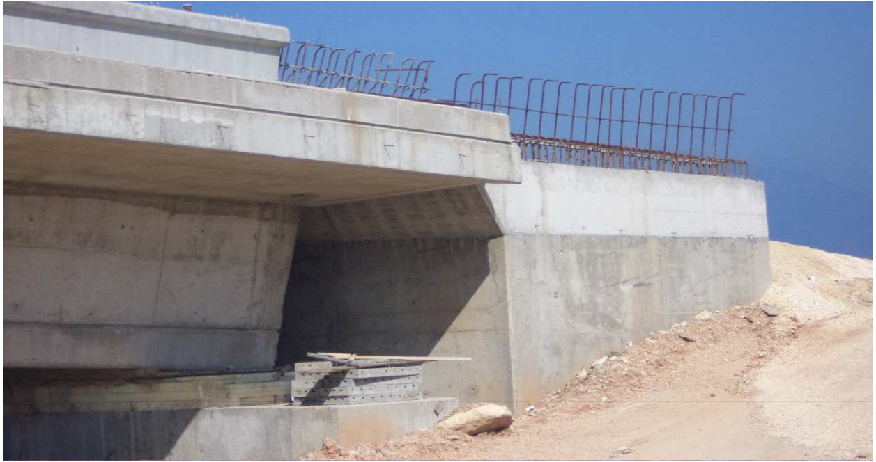
Φωτ. 6.2 Ακρόβαθρο Α1.Α με σπλισμό ΒSt 500S για την κατασκευή στηθαίου ασφαλείας στο άνω μέρος.
