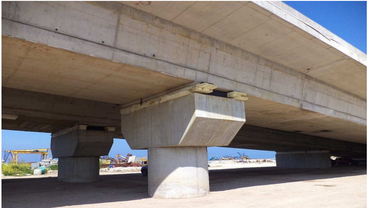
Φωτ. 6.4 Μεσόβαθρο M2.A κυκλικής διατομής με κεφαλοδοκό (πριν την αφαίρεση των προσωρινών στηριγμάτων του εφεδράνου).
