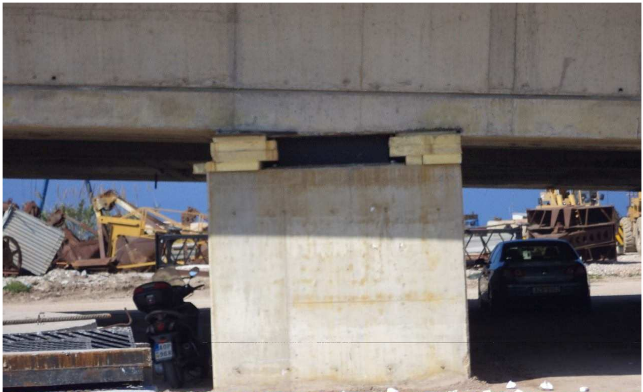
Φωτ. 6.3 Μεσόβαθρο Μ1.Α ορθογωνικής διατομής (πριν την αφαίρεση των προσωρινών στηριγμάτων του εφεδράνου).
