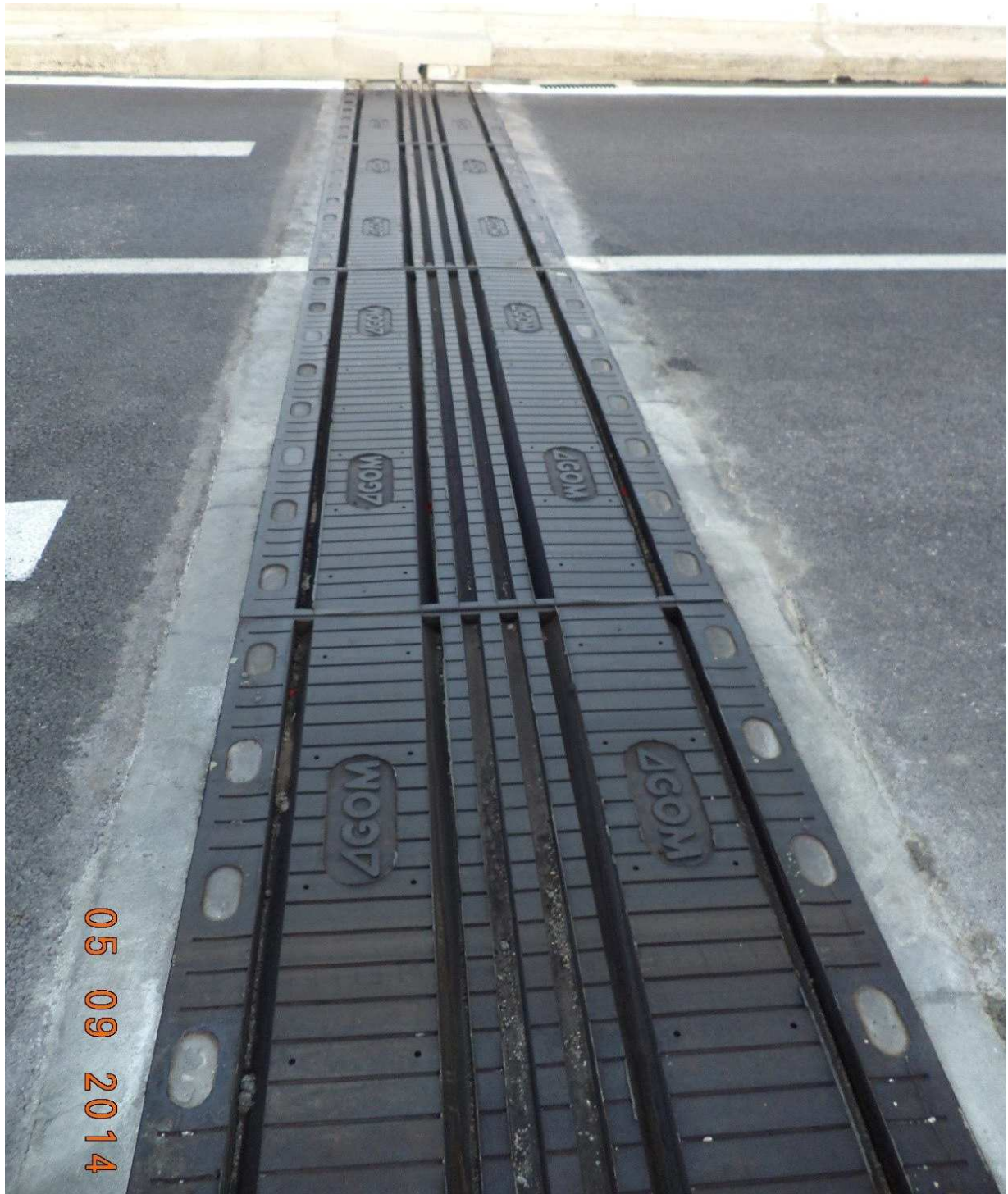
Φωτ. 6.16 Ελαστική καλύπτρα στον αρμό διαστολής μετά το πέρας των εργασιών και όψη διαγράμμισης του τμήματος Τ6 της γέφυρας.
