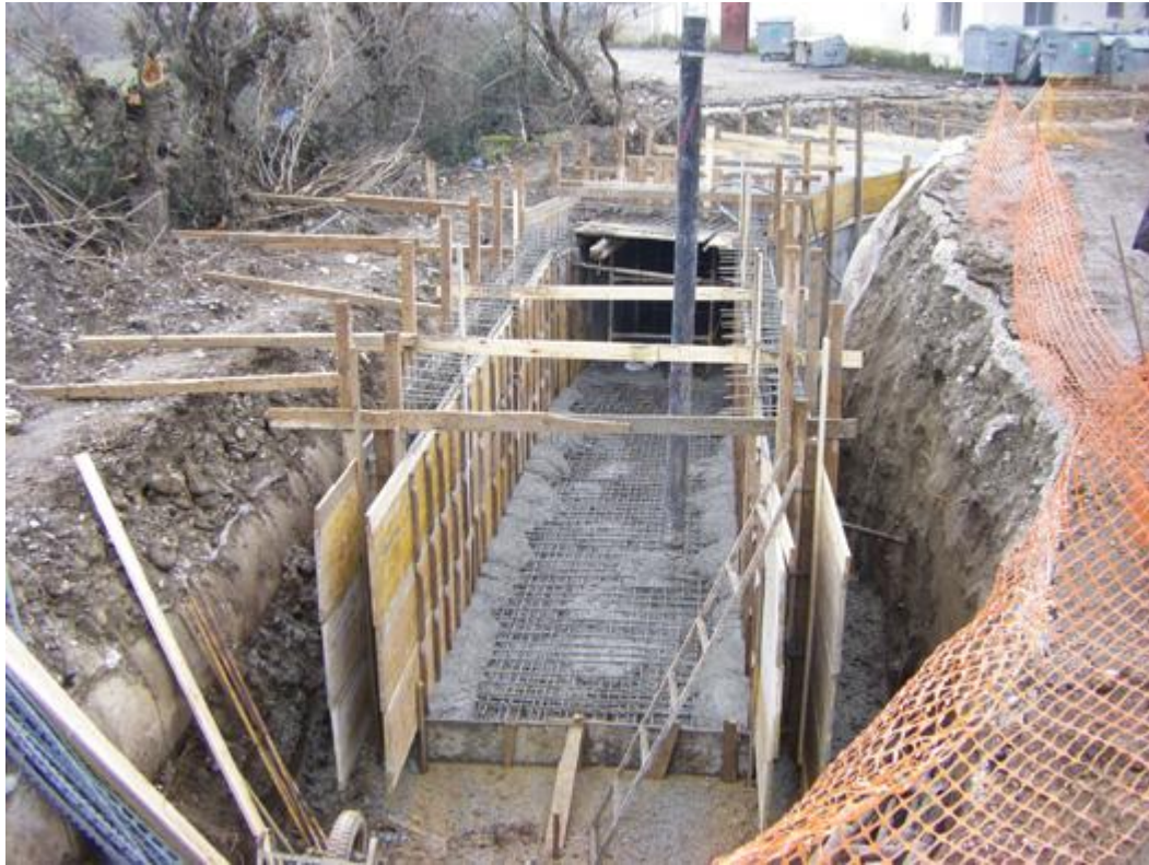
Εικόνα 23. Κατασκευή ορθογωνικής διατομής
