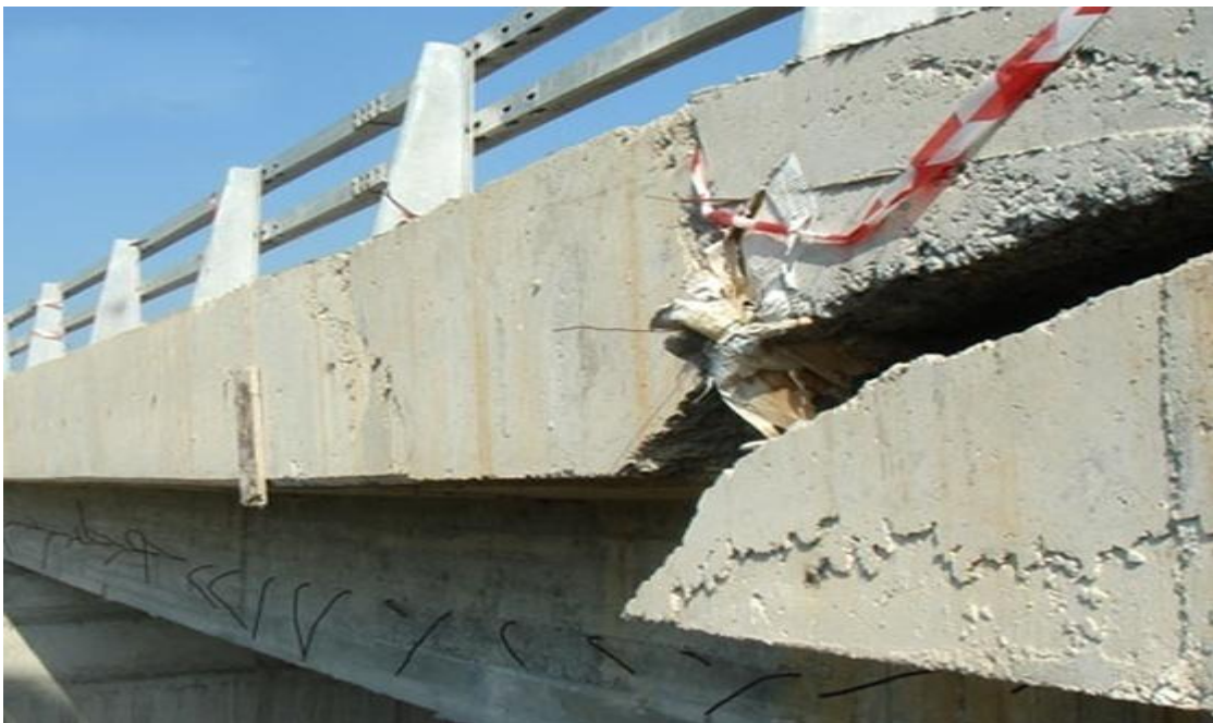
Εικόνα 5.6 Καθιζήσεις στην εθνική οδό Σκάλας – Μολαών Λακωνίας
