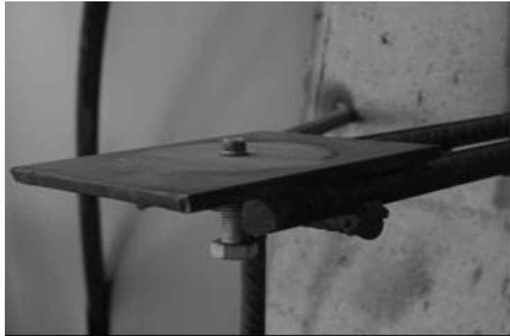
Εικόνα 1.5 Πλακέτα με προεξοχικό κοχλία
