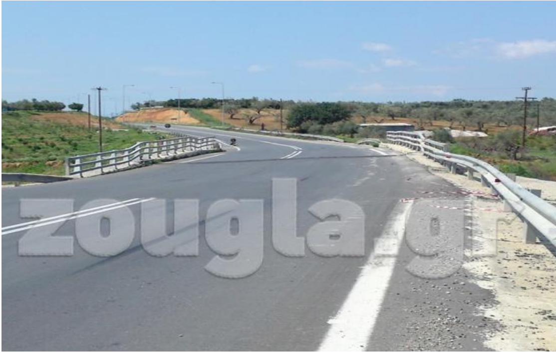
Εικόνα 5.5 Καθιζήσεις στην εθνική οδό Σκάλας – Μολαών Λακωνίας
