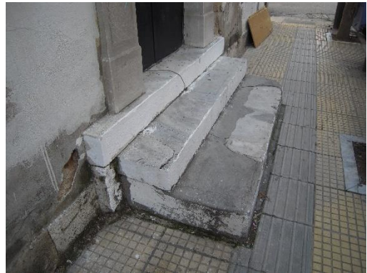
Εικ.23: Εξωτερική κλίμακα εισόδου από οπλισμένο σκυρόδεμα
