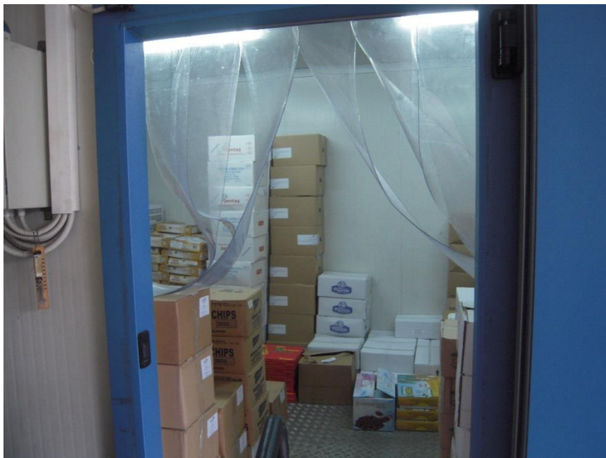
Εικ.53: Ψυγείο θάλαμος
