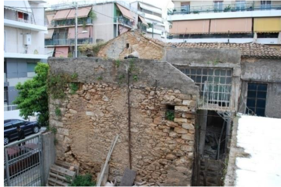
Εικ.21: Δυτική όψη (συμπλήρωση με οπτόπλινθους)
