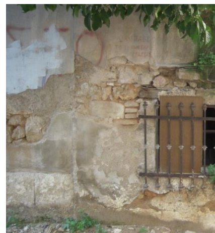
Εικ.18: Κατασκευαστικός αρμός.
