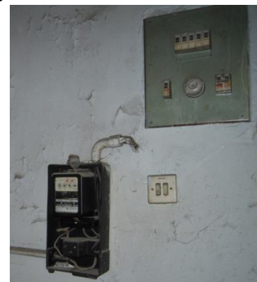
Εικ.42: Διακοπή του κεντρικού καλωδίου παροχής ρεύματος.
