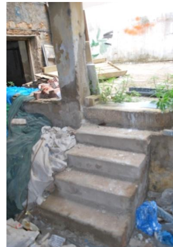
Εικ.26: Κλίμακα ημιυπόγειου από οπλισμένο σκυρόδεμα
