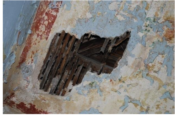
Εικ.40: Τμήμα της οροφής στο χώρο ΗΜ3.
