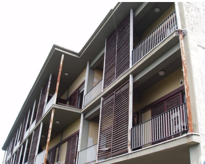
Εικόνα 18 Περσίδες και κιγκλιδώματα
