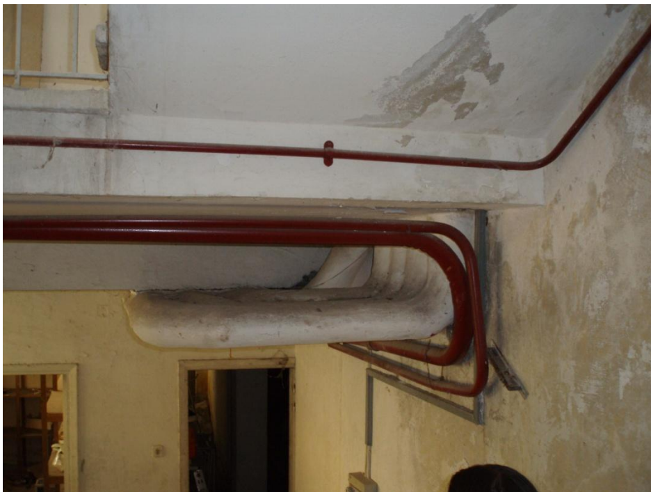
Εικόνα 39 Δείγμα σωληνώσεων θέρμανσης
