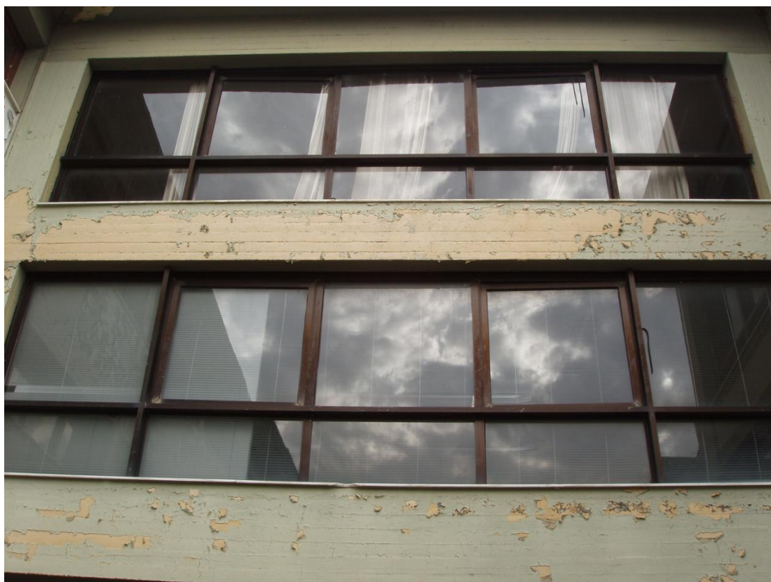
Εικόνα 25 Κουφώματα στην αερογέφυρα
