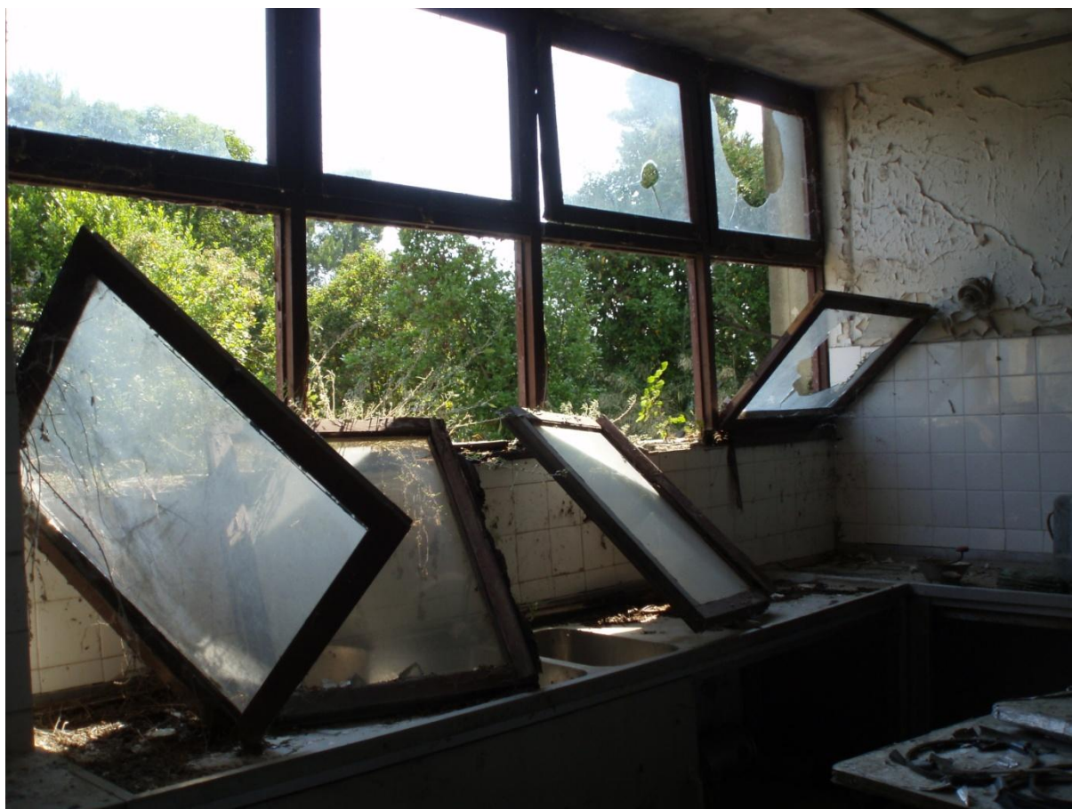
Εικόνα 20 Σπασμένα κουφώματα στην κουζίνα
