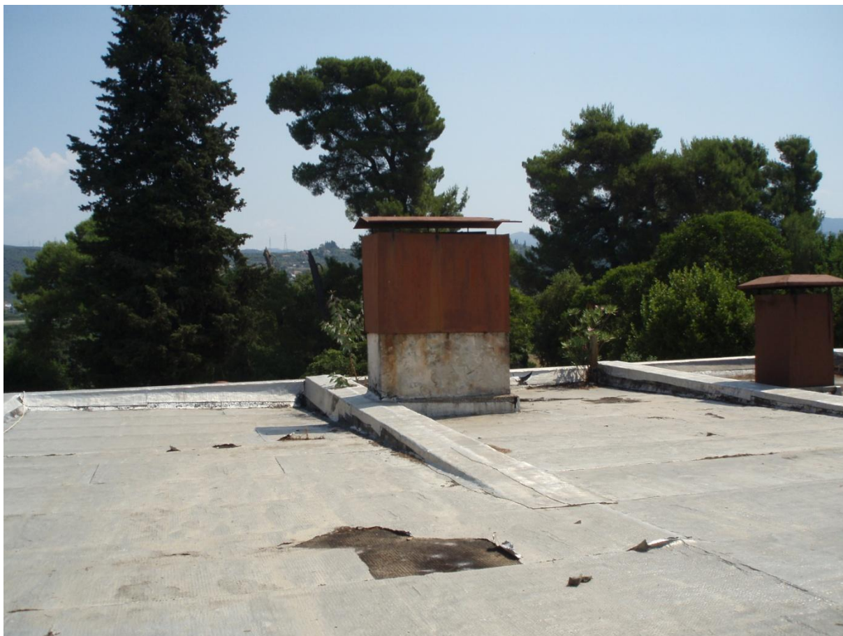
Εικόνα 22 Δώμα πάνω από τον χώρο της κουζίνας
