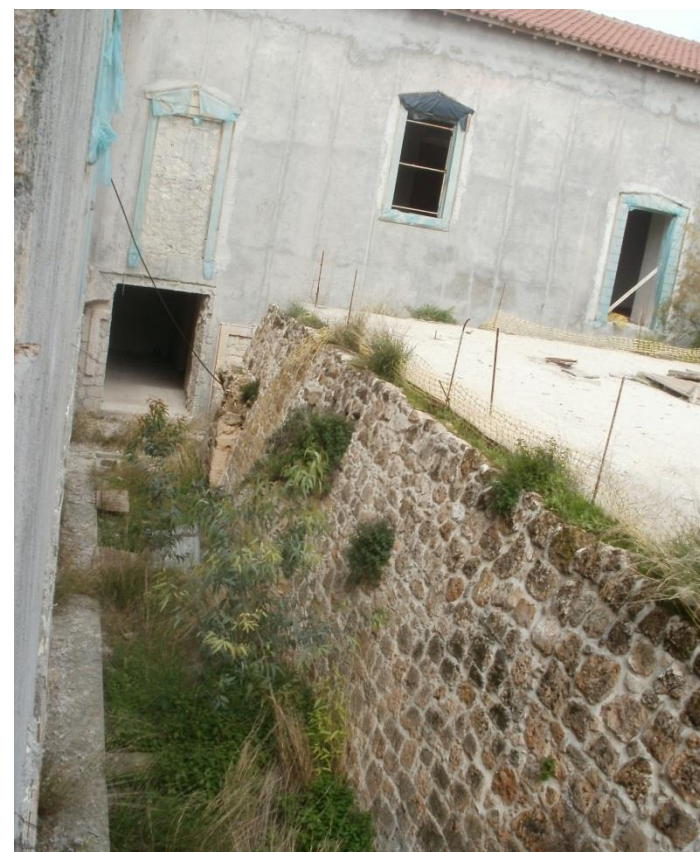
Εικόνα 122 Άποψη της τάφρου στη ΝΔ πτέρυγα. Διακρίνεται ο πέτρινος αναλημματικός τοίχος της τάφρου
