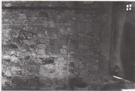
Εικ. 66. Ημιυπόγειο ΝΑ τοίχος χώρου 148 ΒΔ πλευράς, φραγμένα ανοίγματα εσωτερικής τοξοστοιχίας, νεώτερη πόρτα.
