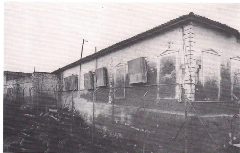
Εικ. 21. ΒΑ πλευρά κτηρίου.
