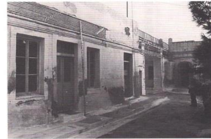
Εικ. 31. Αυλή Κ, χώροι 117, 118, 126, γέφυρα αυλή Ι.
