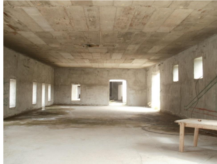
Εικόνα 47 Οροφή από οπλισμένου σκυροδέματος τμήματος του εγκάρσιου κτίσματος (αναρρωτήριο). Πηγή: προσωπικό αρχείο, 2012
