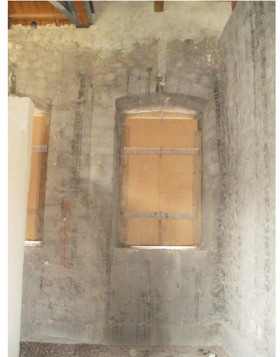
Εικόνα 43. Μανδύας εκτοξευόμενου σκυροδέματος (gunite) στην τοιχοποιία του εγκάρσιου τμήματος. Πηγή: προσωπικό αρχείο, 2012
