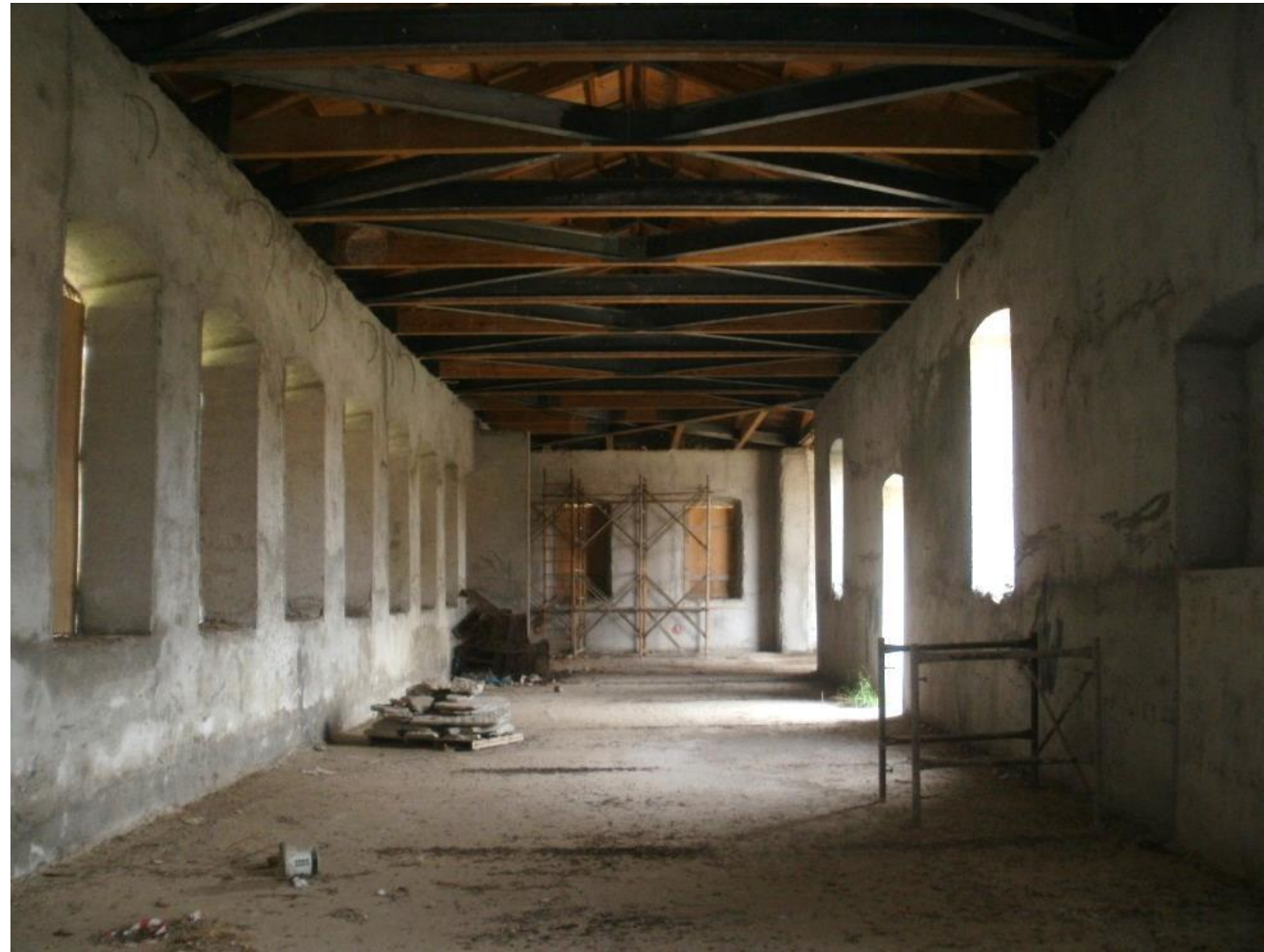
Εικόνα 38 Οριζόντια δικτυώματα. Πηγή: προσωπικό αρχείο, 2012
