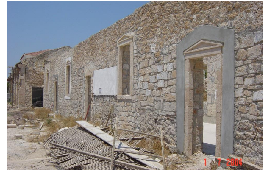
Εικόνα 33 Εμφανής τοιχοποιία των εσωτερικών όψεων της ΝΔ πτέρυγας πριν την επέμβαση του ΥΠ.ΠΟ. Πηγή: ΥΠ.ΠΟ, Διεύθυνση Μουσείων, 2004
