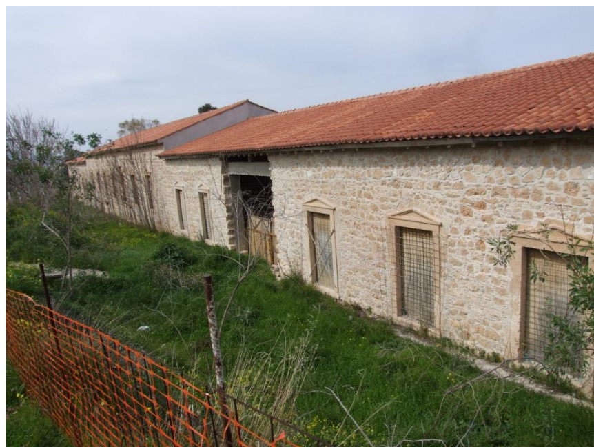
Εικόνα 110 Νοτιοανατολική όψη. Υπάρχει προσωρινό άνοιγμα για την πρόσβαση μηχανημάτων και υλικών
