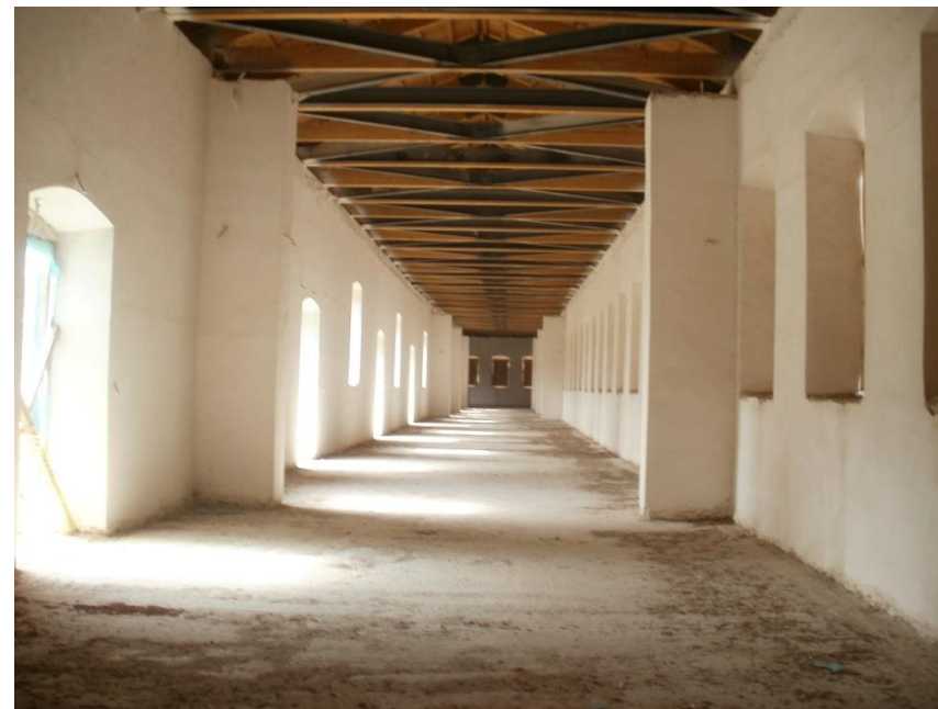
Εικόνα 43. Μανδύας εκτοξευόμενου σκυροδέματος (gunite) στην τοιχοποιία του εγκάρσιου τμήματος. Πηγή: προσωπικό αρχείο, 2012
