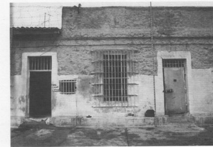
Εικ. 62. Αυλή ακτίνας Β, χώροι 95, 96.
