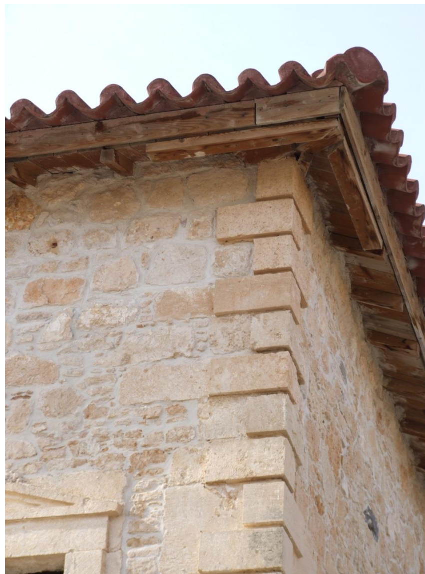
Εικόνα 36 Λαξευμένοι γωνιόλιθοι με μορφή ενός και μισού πλάτους εναλλάξ στην απόληξη των όψεων. Πηγή: προσωπικό αρχείο, 2012
