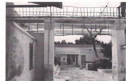
Εικ. 35. Γέφυρα, αυλή Ι.
