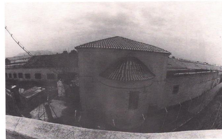
Εικ. 22. ΒΑ πλευρά κτηρίου.
