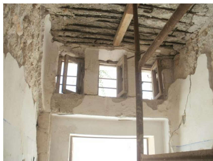
Εικόνα 126 Εσωτερική άποψη της εισόδου της απομόνωσης από το κτήριο
