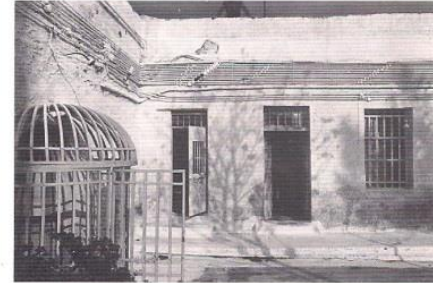
Εικ. 32. Αυλή Κ, χώροι 121, 122. Καγκελόφρακτη πόρτα προς ακτίνες Δ, Ε.
