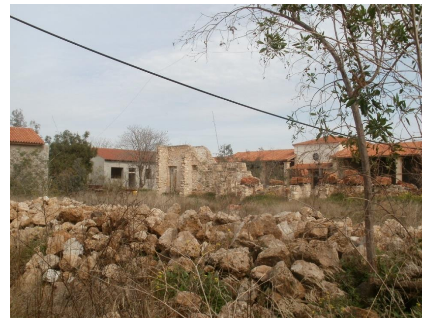
Εικόνα 115 Γενική άποψη της αυλής από την ΝΔ πτέρυγα. Διακρίνεται το ερείπιο του ημιυπαίθριου διαδρόμου των φυλακών, η εκκλησία και μέρος του εγκάρσιου τμήματος
