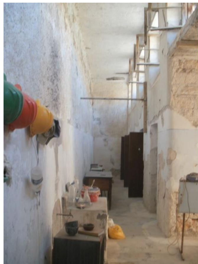
Εικόνα 128 Στενός διάδρομος που οδηγεί στα κελιά απομόνωσης
