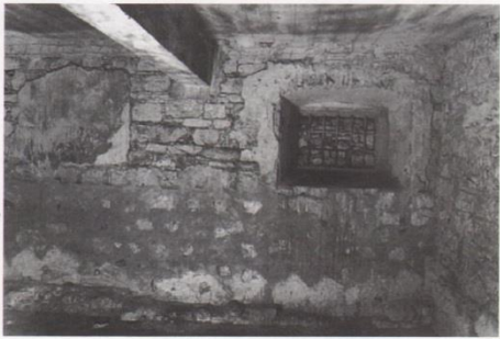
Εικ. 67. Ημιυπόγειο ΒΔ τοίχος χώρου 147.
