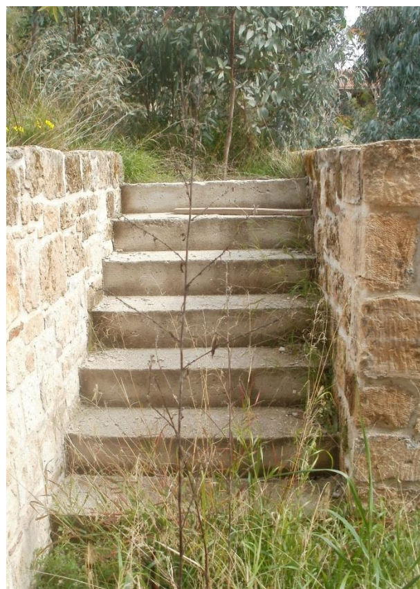
Εικόνα 123 Υπαιθριο κλιμακοστάσιο που οδηγεί από την είσοδο στην αυλή
