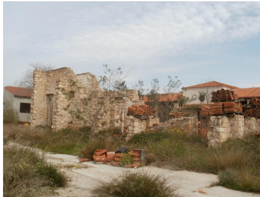
Εικόνα 49. Το κτήριο του επισκεπτηρίου, δεξιά της εισόδου. Πηγή: προσωπικό αρχείο, 2012
