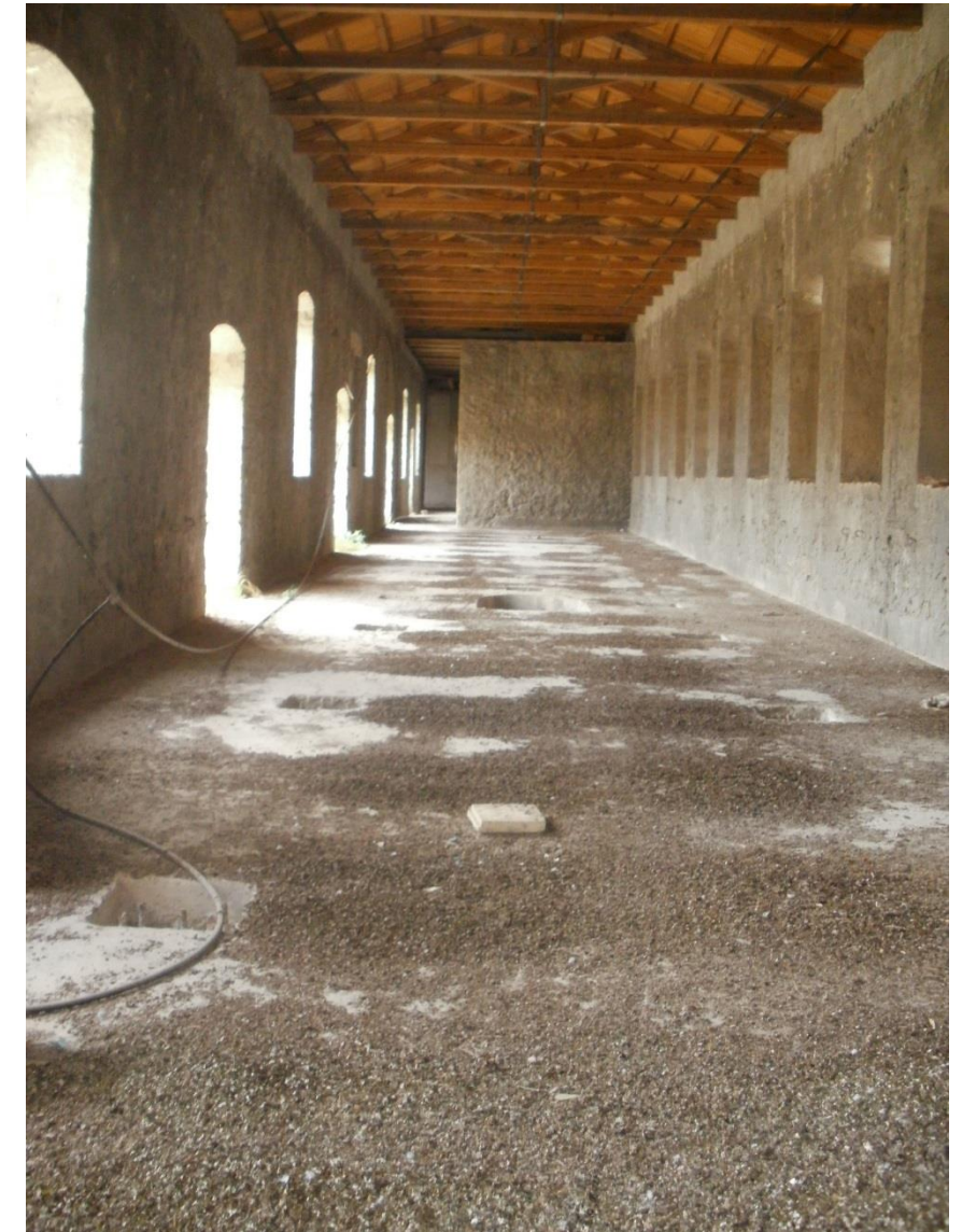
Εικόνα 30 Αδιαμόρφωτοι ενιαίοι χώροι. ΝΔ πτέρυγα .Πηγή: προσωπικό αρχείο, 2012
