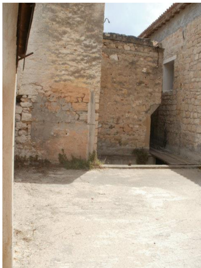
Εικόνα 129 Άποψη του κτίσματος της απομόνωσης από τον υπαίθριο μηχανολογικό χώρο
