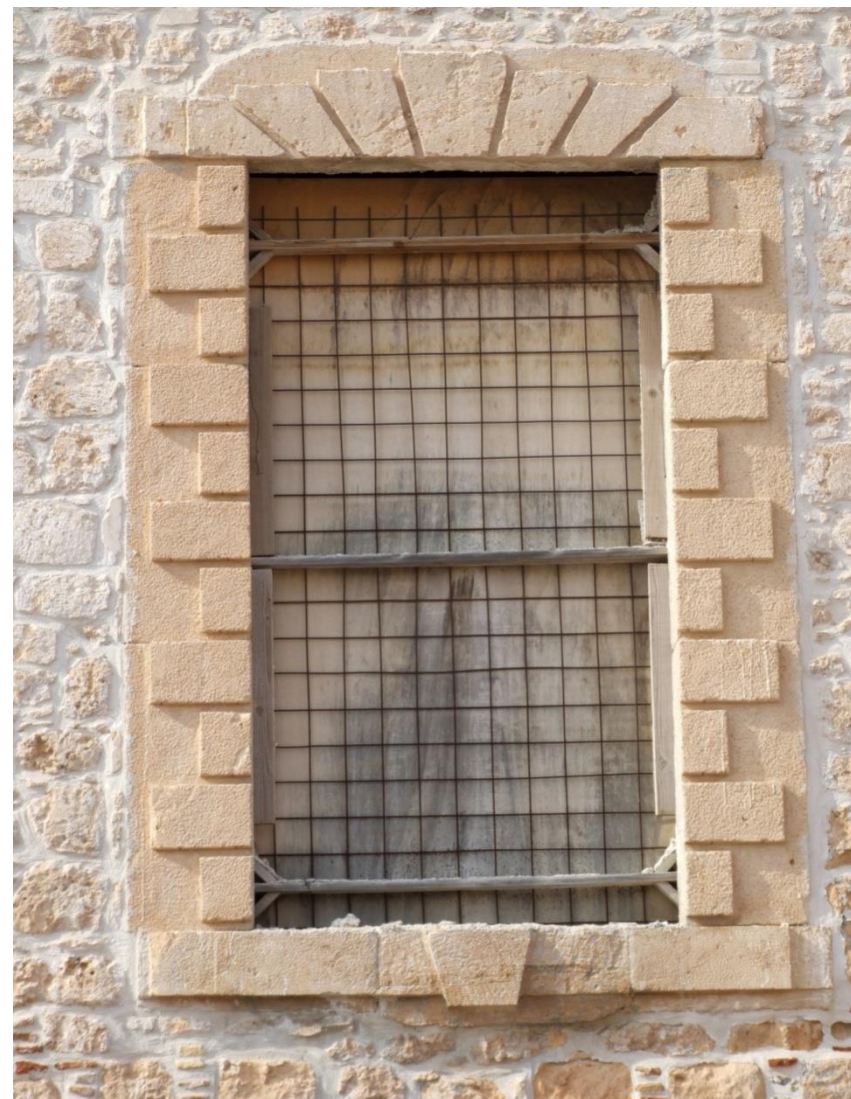
Εικόνα 35 Δεύτερος τύπος υπέρθυρων παραθύρων με επίπεδο μονολιθικό πρέκι και την προσθήκη αετώματος. Πηγή: προσωπικό αρχείο, 2012
