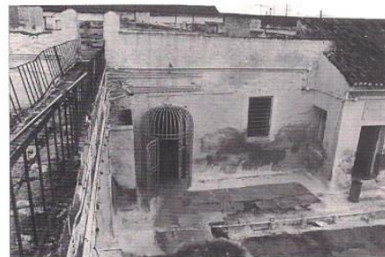
Εικ. 29. Αυλή Ι, γέφυρα, καγκελόφρακτη πόρτα στο διάδρομο 97 προς ακτίνες Α, Β, Γ.
