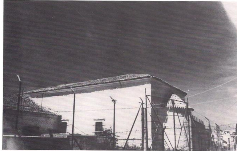
Εικ. 20. ΒΑ πλευρά κτηρίου, εξωτερικό ναού.
