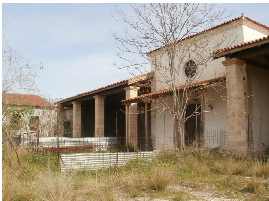
Εικόνα 114 Όψη της εκκλησίας και των ημιυπαίθριων στοών από την αυλή
