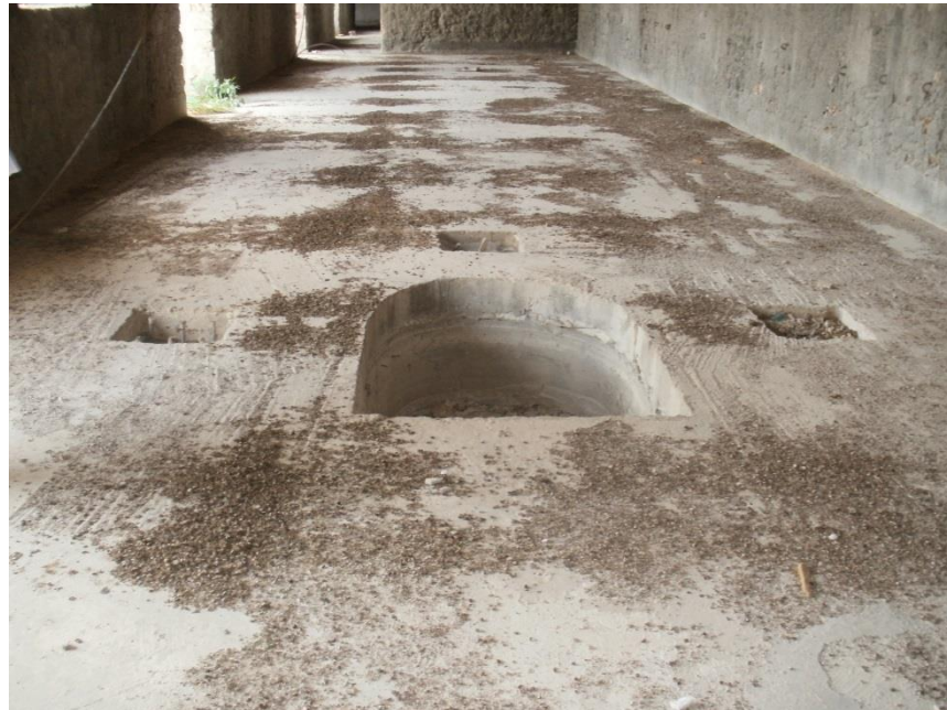
Εικόνα 46 Τμήμα του δαπέδου στο Ν.Α. τμήμα του κτηρίου. Πηγή: προσωπικό αρχείο, 2012
