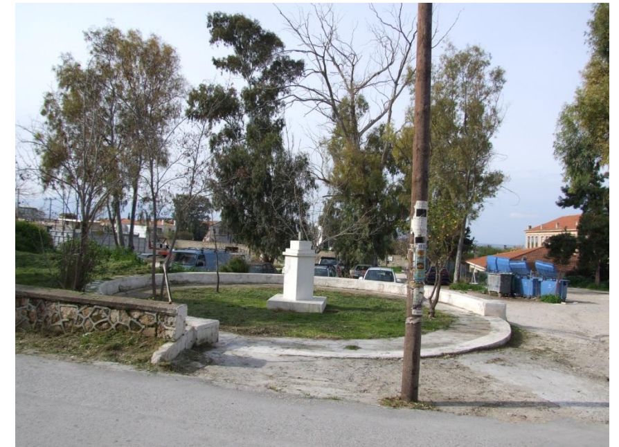
Εικόνα 55 Αδιαμόρφωτος χώρος μπροστά από το κτίσμα της απομόνωσης που χρησιμοποιείται από τους κατοίκους ως χώρος στάθμευσης. Πηγή: προσωπικό αρχείο, 2012
