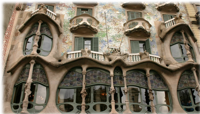
Εικόνα 18: Εξωτερική άποψη από την Casa Batlló
